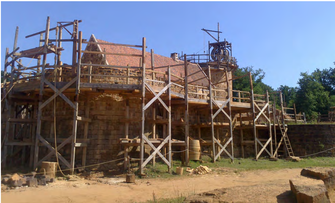
Borgen Guédelon, vid Treigny i Frankrike, är ett experiment i stor skala. Borgen byggs med medeltida tekniker och material. Projektet har pågått sedan år 1997. Kunskaper från bygget av Guédelon används vid återuppbyggandet av Notre-Dame. Foto: Jimmy Juhlin-Alftberg.
