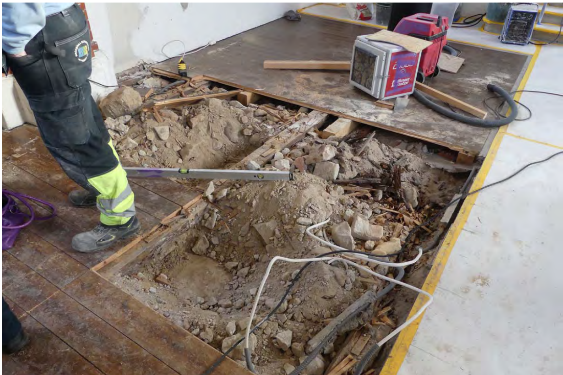
Golvet av brädor låg på golvbjälklag av trä direkt i golvfyllningsmaterial av jord och byggskerot. Under fyllningen låg ett hårdare packat material som inte rördes.
