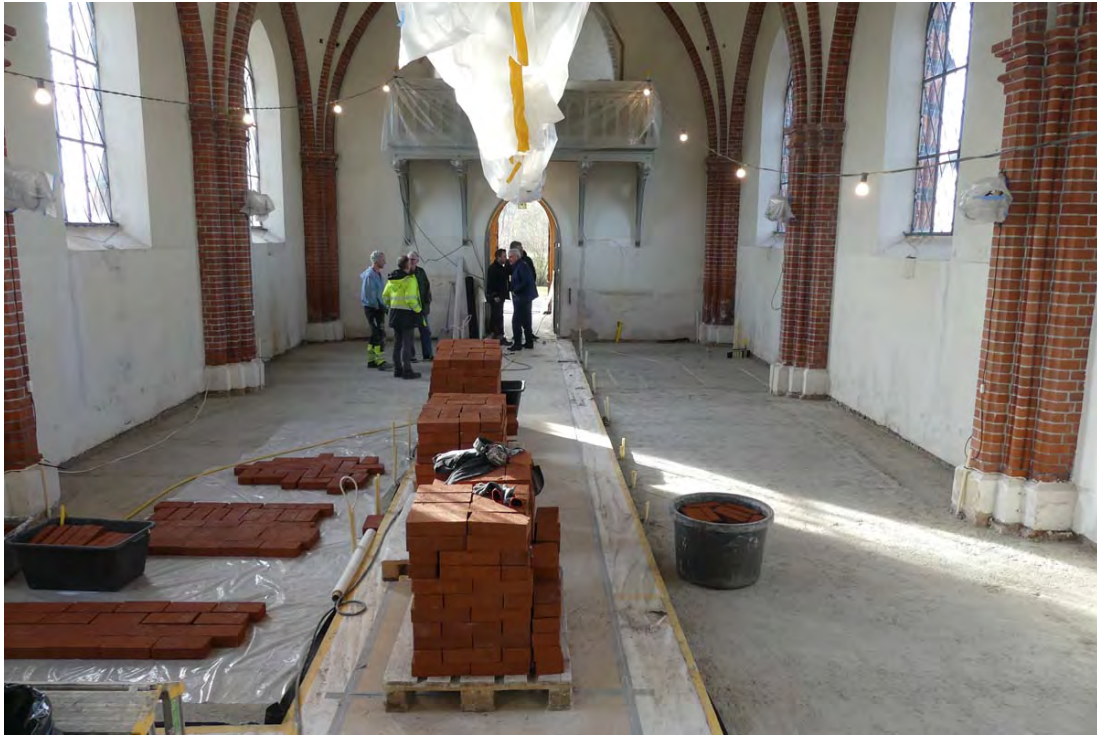
Kyrkorummet efter bortgrävning av gammal golvfyllning samt nytt bärlager av makadam och kalkbetong.
