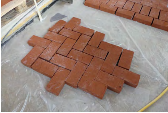
Utprovning av olika mönsterläggning.
