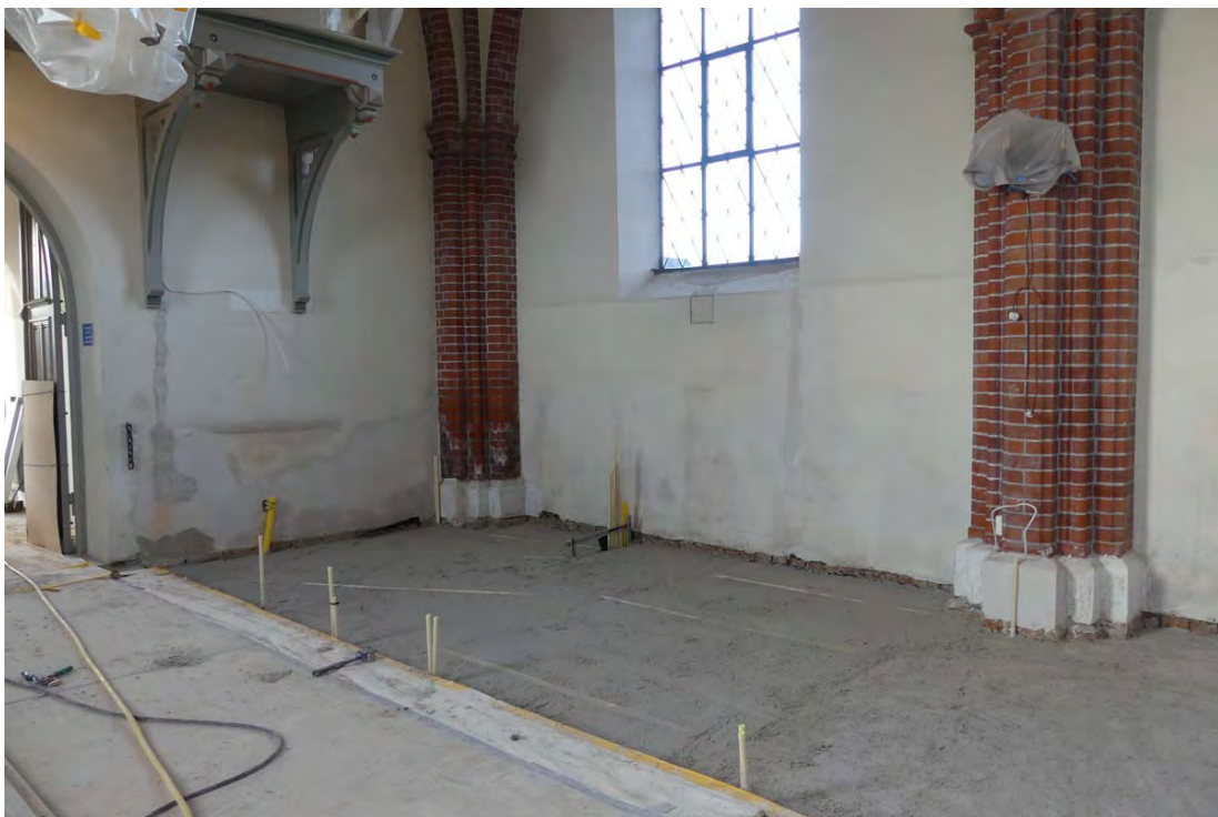
Ledning till värme och el drogs i rör golven bärlager. Rör till framtida luft-luftvärmepump lades ned.
