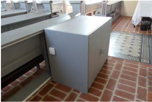
Nya bänkradiatorer samt nytt skåp till styrning för värme, ljus och ljud. På sidan av skåpet sitter givare till värme i långhuset. I vapenhuset målades golvet och ytterdörren lackades om.
