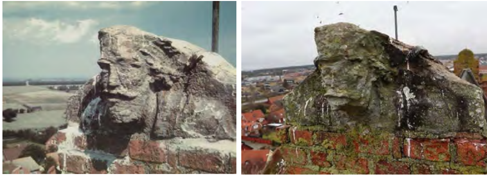
Kalkstensskulpturen på tornets topp, fotograferad på 1960-talet respektive 2018. Nedbrytningen hade gått så långt att beslut fattades att montera ner skulpturen. Fotografierna har tillhandahållits av Kalle Melin, Knadriks Kulturbygg AB.
