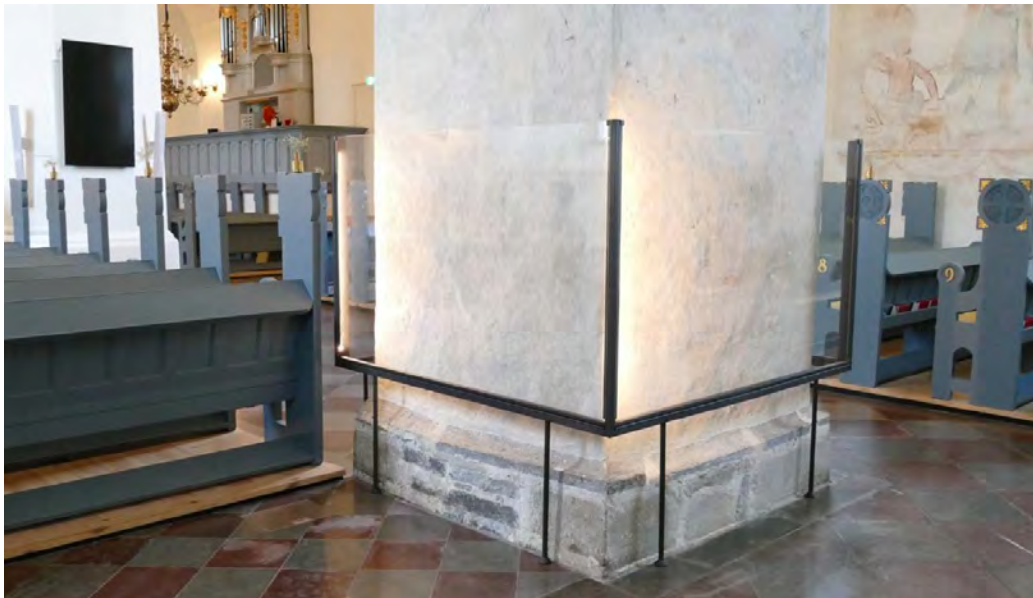
Den övre bilden visar korförlängningens södra vägg där trabes, istället för att placeras på golvet, har monterats på en special-tillverkad konsol över den äldre läktarbarriären. Den nedre bilden visar glasinklädnaden kring den västra långhuspelaren, vilken tillkommit för att tillgängliggöra inskriptioner på pelaren – utan att riskera att dessa kommer till skada.
