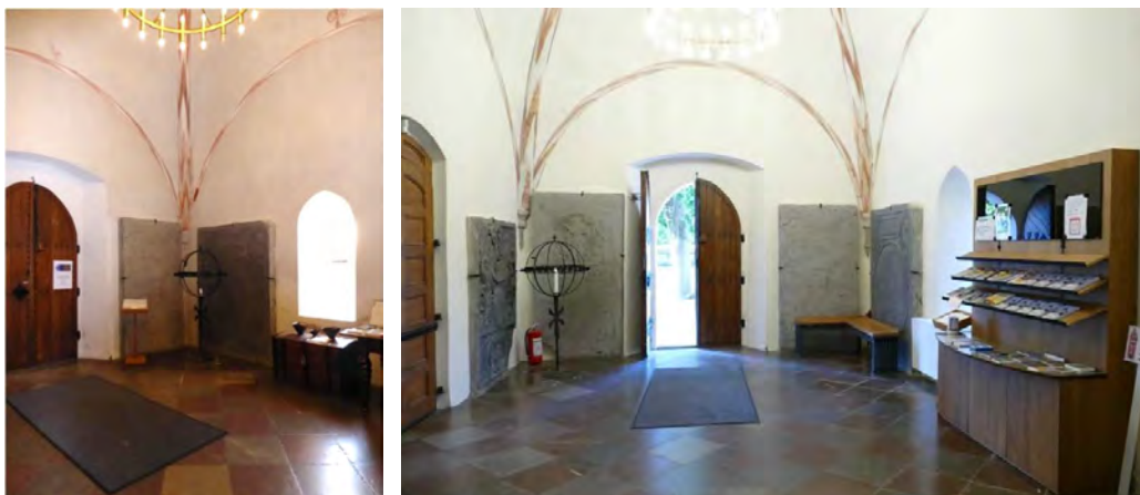
I vapenhusets södra del har en bänk installerats. Bänken är ett komplement till uppvärmingen och är egentligen en radiator, försedd med en sits av ek.
