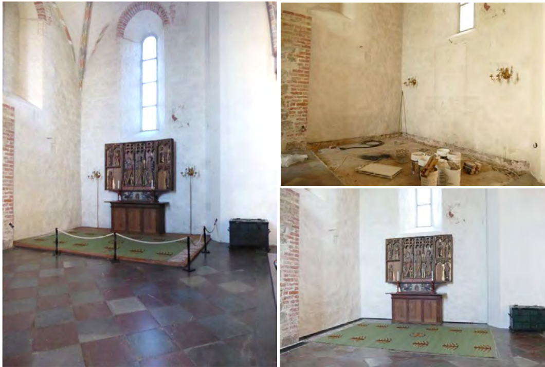
Till vänster långhusets nordvästra hörn före renoveringen; Mariaaltaret är placerat på ett trägolv. Överst till höger visas samma utrymme under pågående renovering när trägolvet rivits och förberedelser görs för VVS samt för gjutning inför läggning av kalkstensgolvet. Längst ner till höger visas utrymmet efter renoveringen; väggarna är rengjorda av konservator, skador efter lampeterna är retuscherade, nedsänkta golvkonvektorer löper längs yttermuren, med undantag för platsen för Mariaaltaret. Trägolvet har ersatts av kalksten.
