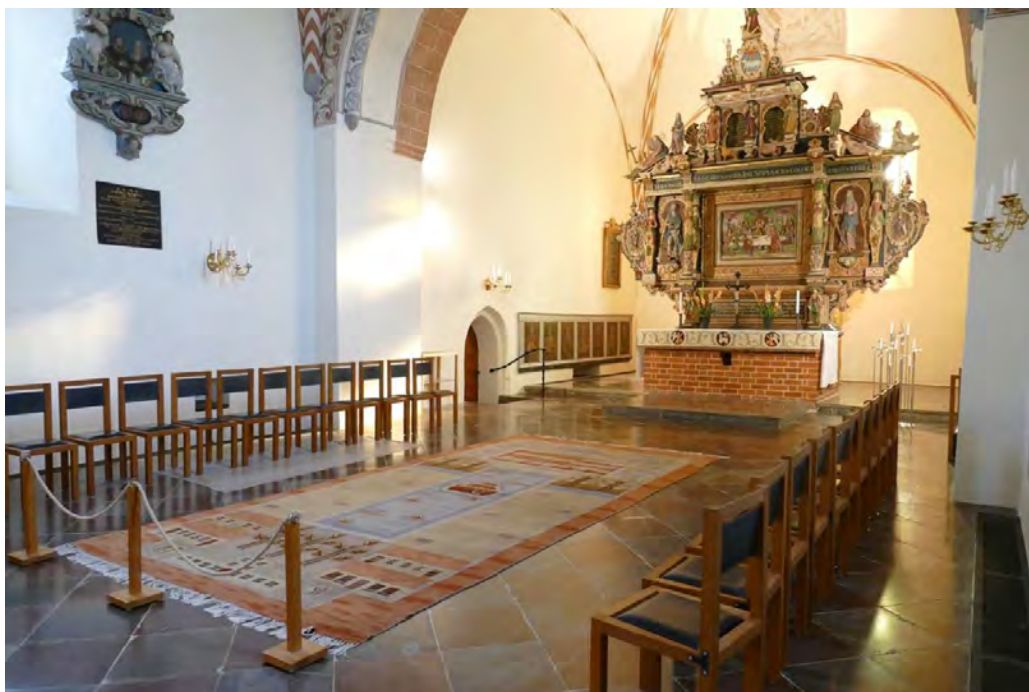
Koret efter avslutad renovering. Den övre bilden visar korförlängningens nordöstra hörn där en gravhäll lyfts upp till golvnivå. Längsmed väggen syns de nedsänkta konvektorgravarna täckta med metallgaller. Den nedre bilden ger en överblick över hela koret efter renoveringen. Under den borte stolsraden syns gravhällen över den så kallade Prästgraven.
