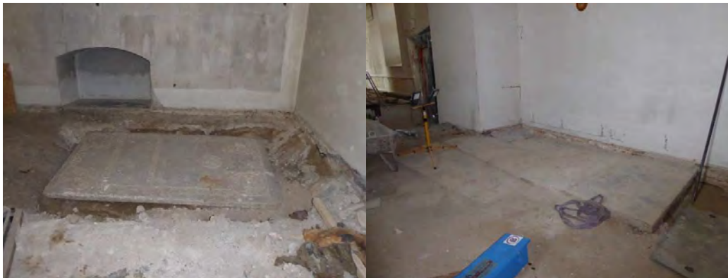
I korets nordöstra hörn återfanns en grav med gravhäll daterad 1610. Under hällen låg en rund träpinne som sannolikt har använts för att rulla hällen på plats. Till höger korets nordvästra hörn där flera sammanpusslade gravhällar fanns under 1900-talets kalkstengolv.
