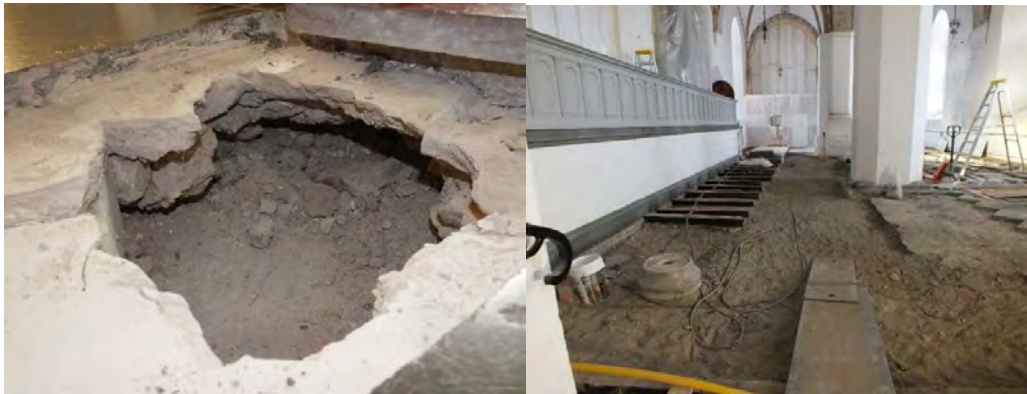
Förundersökningar av golvet visade sig att marken under golvgjutningen sjunkit av okänd anledning. Till höger en utblick över långbuset efter att kalkstengolvet med tillhörande gjutning avlägsnats.
