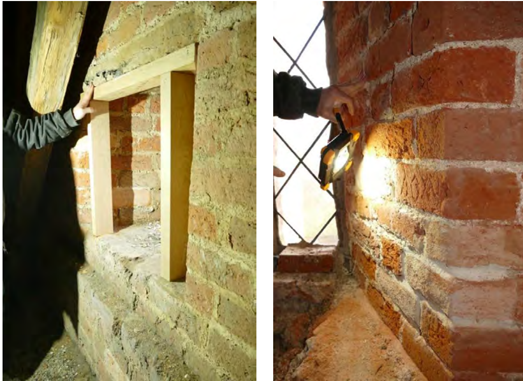
På vinden ovan koret finns två fönsteröppningar och båda har åtgärdats i projektet. Bilden till vänster visar en stämpling med ekvirke som gjorts i den norra fönstersmygen för att stötta en spräckt kalkstensskiva som utgör övre karm i öppningen. Bilden till höger visar en inristning i en av tegelstenarna i södra fönstersmygen. Här vittrar och sandar tegelstenen i stor omfattning. Stenen har bytts ut respektive konsoliderats.
