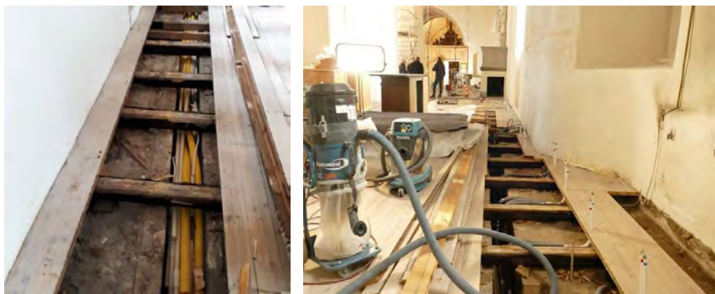
Ett äldre schakt för el och VVS-installationer kunde återanvändas vid renoveringen. Här visas det sydvästra bänkkvarteret under pågående installation.
