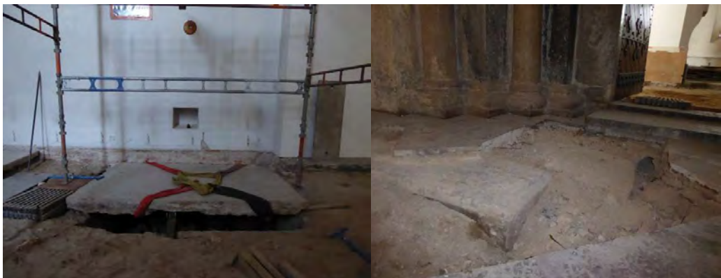
Gravhällen över den så kallade prästgraven vägde 2,6 ton och en specialanordning fick användas för att flytta hällen medan gravkammaren grävdes ut. Till höger golvet i vapenbuset i samband med grävning för VVS, flera äldre, bearbetade stenar återfanns. Under nuvarande tröskel mellan vapenbus och långbus låg vad som förmodas vara en äldre tröskelsten, med spår av ålderdomlig kilspräckning.
