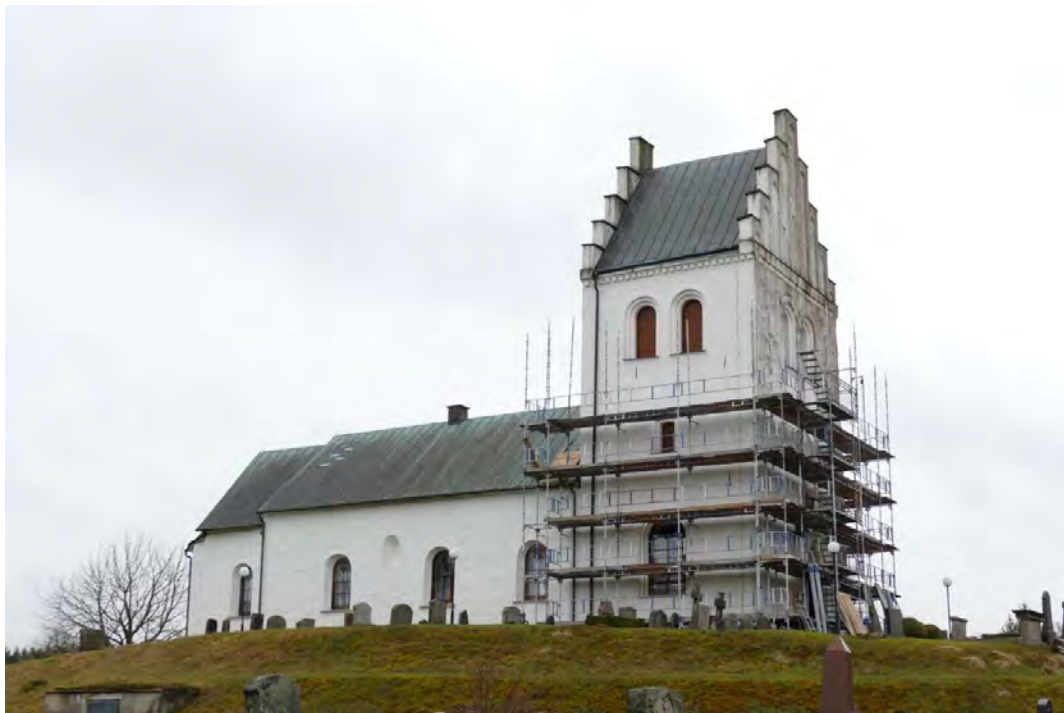
Den övre bilden visar kyrkans södra och västra fasader. Den nedre bilden visar norra respektive västra fasaden. Den norra tornfasaden putsades om i sin helhet år 2007 och är i synbart bättre skick än övriga sidor.
