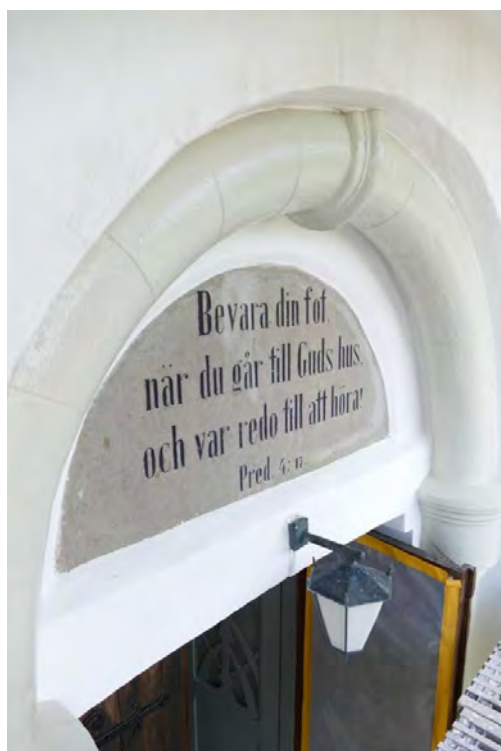
De övre bilderna visar det runda fönstrets på tornets västra fasad under, respektive efter, renovering. Ett nytt plätbleck som täcker de tre murade sprängen ska säkra vattenavrinningen. De nedre bilderna visar västporten efter avslutat renovering. Pelarna och rundbågen har målats i en svagt grön linojefärg liksom tidigare, puts-skador och handledare har reparerats och dörrbladen ojlats.
