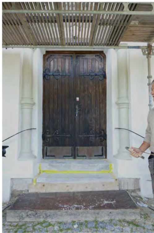
De övre bilderna visar det runda fönstrets på tornets västra fasad under, respektive efter, renovering. Ett nytt plätbleck som täcker de tre murade sprängen ska säkra vattenavrinningen. De nedre bilderna visar västporten efter avslutat renovering. Pelarna och rundbågen har målats i en svagt grön linojefärg liksom tidigare, puts-skador och handledare har reparerats och dörrbladen ojlats.
