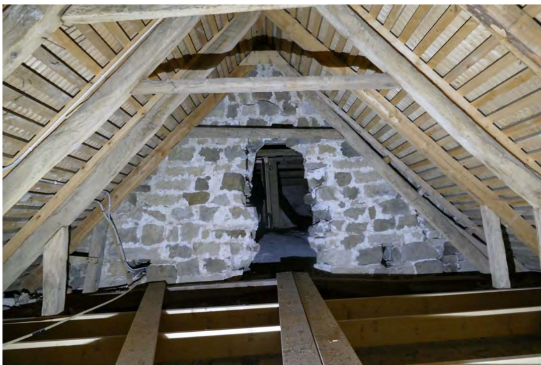
Korvinden sett mot väster med ingången från långhusvinden. Golvet i korvinden består av ett träbjälklag med brädor.
