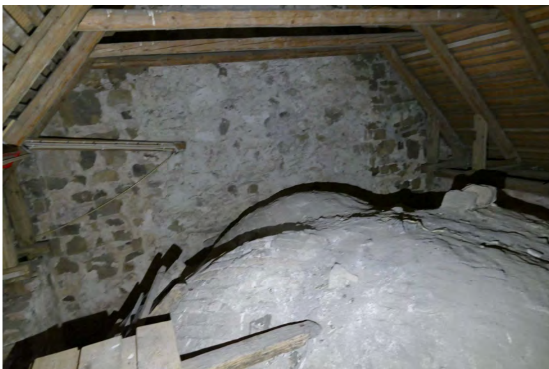
Långhusvinden sett mot väster före åtgärderna.
