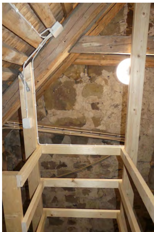
Elinstallationer gjordes huvudsakligen på nytt virke. Till vänster strömbrytare till belysning innanför ingång till vapenbusvinden. Till höger eluttag och ny belysning monterade på ny landgång.
