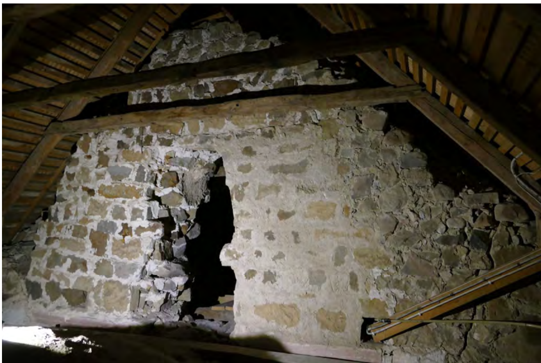
Ingång till korvinden sker genom en sekundärt upptagen öppning i gaveln mot öster. Befintlig håltagning i muren (till böger i mur) kunde användas för eldragning till korvinden.
