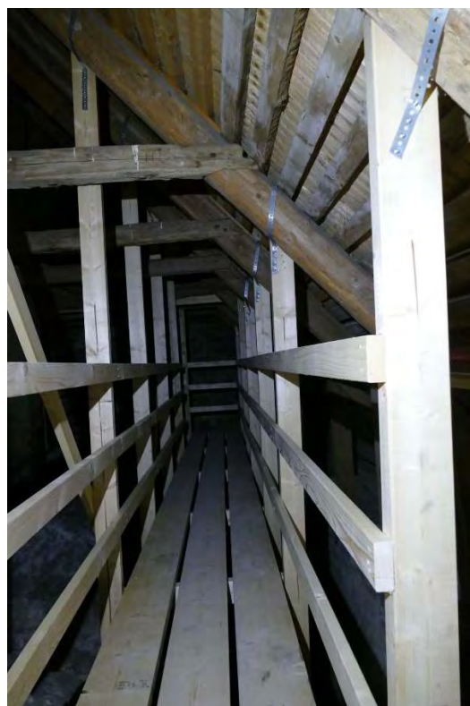
Landgången hängdes upp genom järnband och infästning i taklaget behövdes därmed inte.
