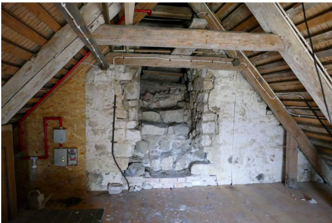
Ingång till långhusvinden sker från vapenbusets vindsplan genom en muriöppning i södra långhusmuren. En steg av sten tjänade tidigare som trappa.
