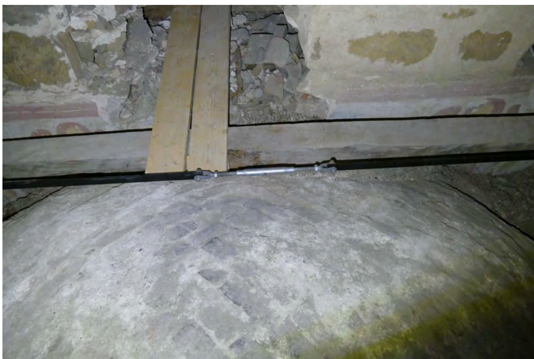
Spännskruv i mitten av järnstaget.
