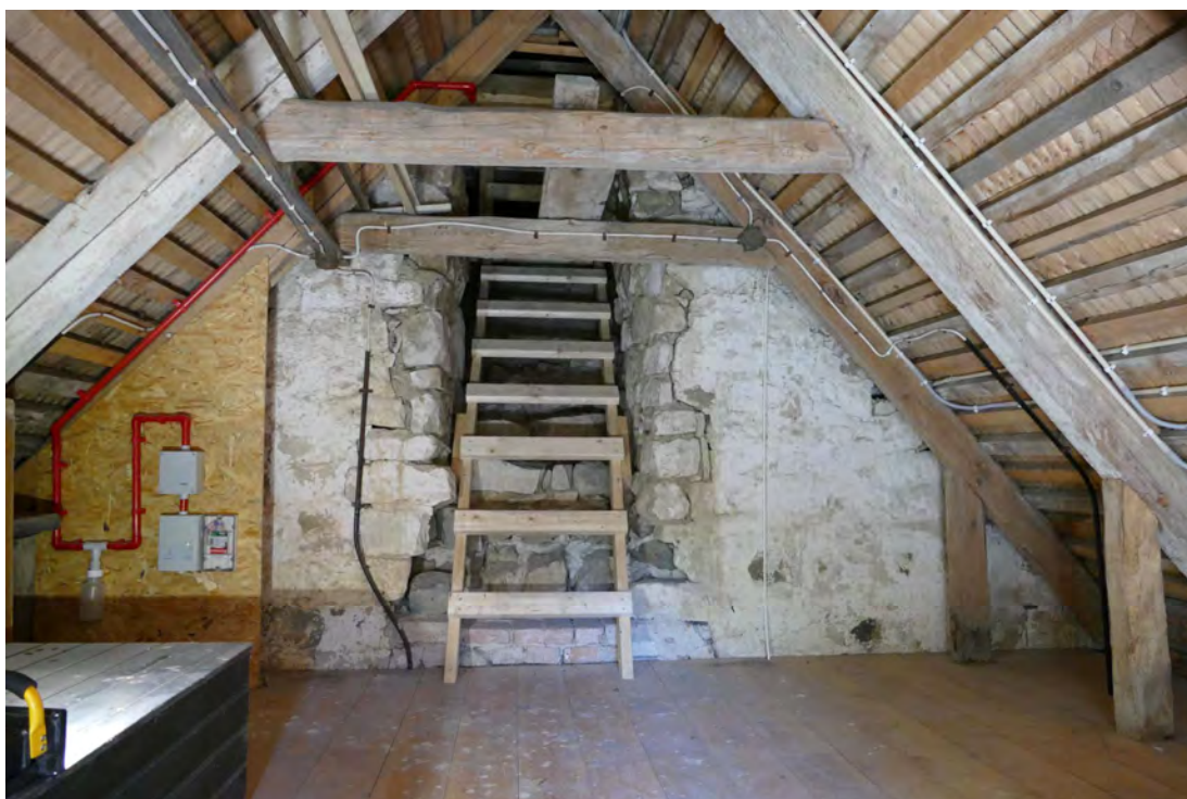
En ny trappa av brädor monterades till den nya landgången på långhusvinden.
