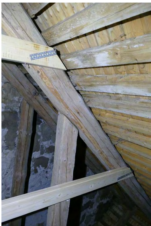
Landgången hängdes upp genom järnband och infästning i taklaget behövdes därmed inte.
