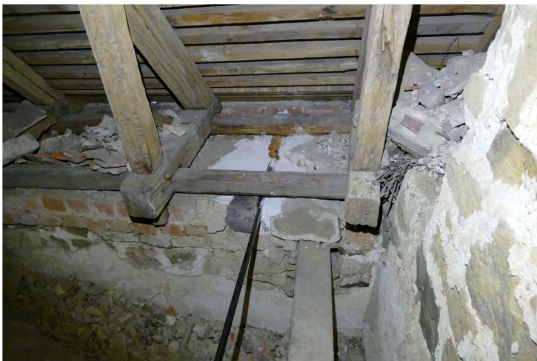
Ett dragstag monterades mellan norra och södra sidorna intill en äldre dragbjälke Dragjärnet lades över krönet och böjt ned på fasadsidorna. Viss ommurning fick göras vid montering av staget (vitt bruk i bild)
