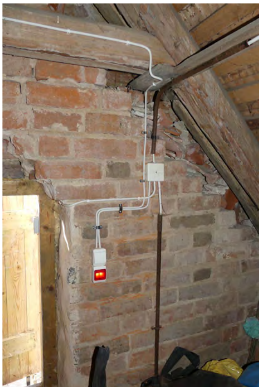
Elinstallationer gjordes huvudsakligen på nytt virke. Till vänster strömbrytare till belysning innanför ingång till vapenbusvinden. Till höger eluttag och ny belysning monterade på ny landgång.
