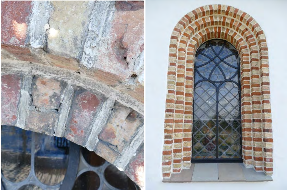
Fönstrens omfattningar visade på många foglagningar och på de norra fönstren fanns vit färg vilket troligen är ett äldre utförande. Fönstrens smideskonstruktion målades och kompletterades med nya fönsterbleck.
