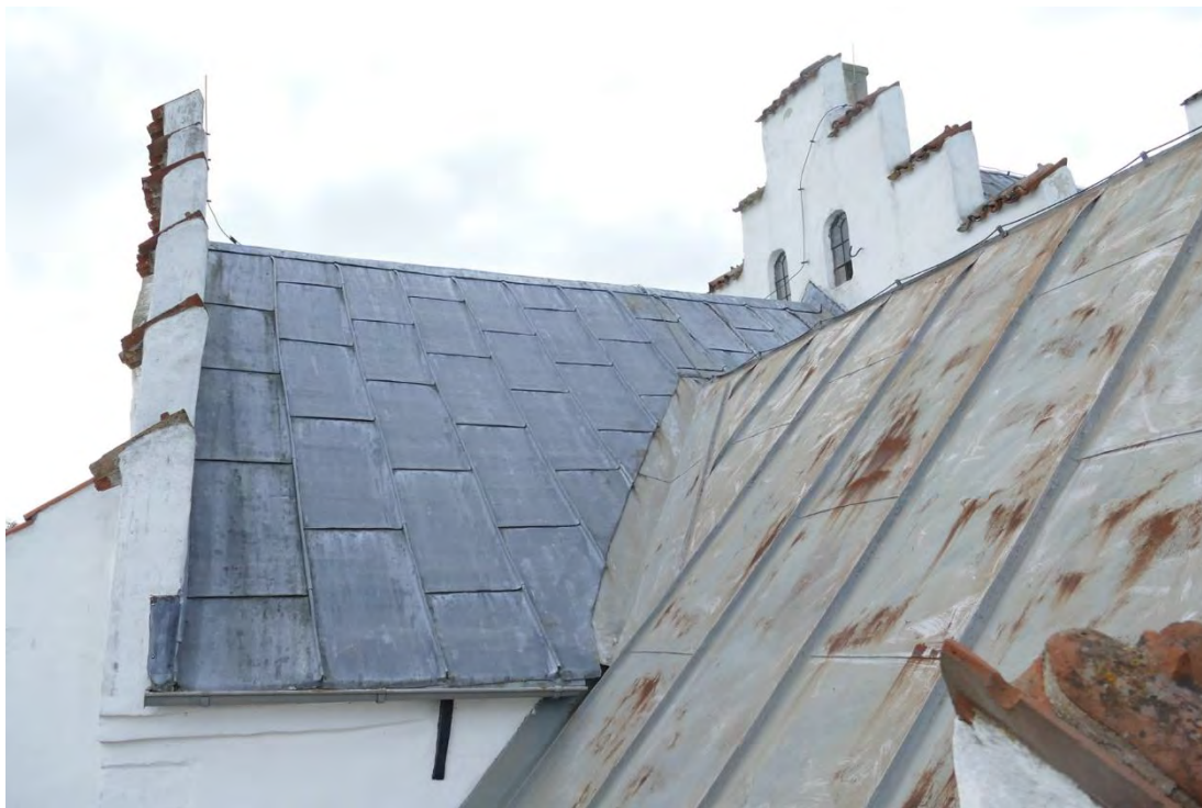
Bjällerups kyrkas kortak (t. v.) lagt med valsad bly och sakristitak (t. h.) lagt med galvad plåt, september 2018.
