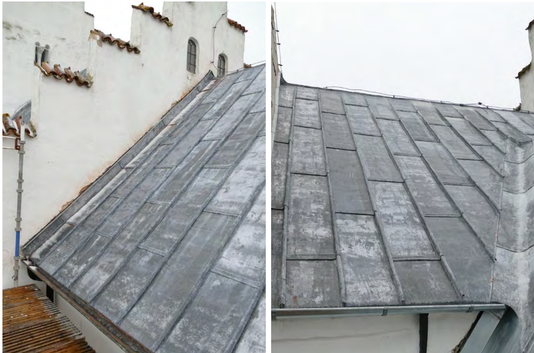
T. v: Korets södra takfall, efter omtäckningen med gjutet bly. På den näst bortre skivan närmast takfoten finns plåtfirmans namn och årtal ingjutet. T. h: Korets nordöstra tak, efter omtäckningen.
