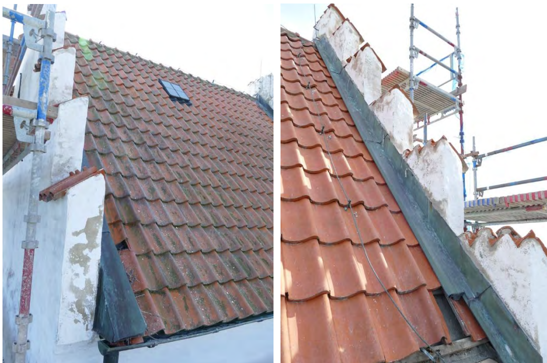
Torntaket före omläggningen. Fönstret togs bort och plåten som på ett par ställen gick upp över trappgavlarna ersattes.
