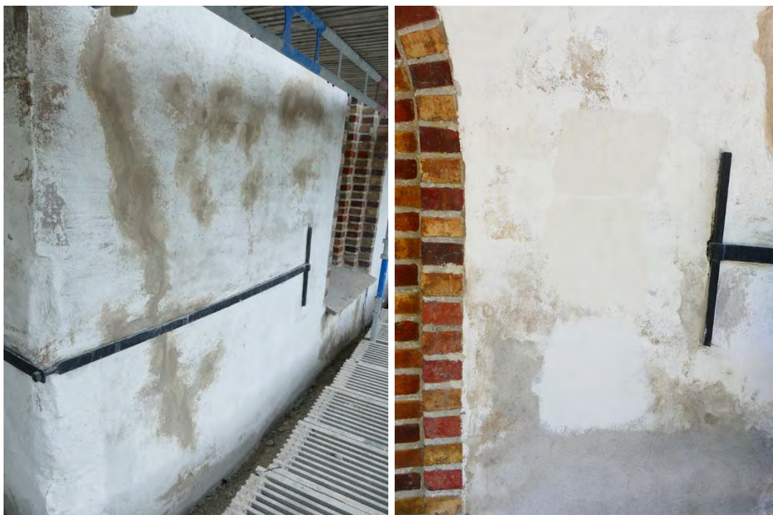
T. v: Tornets nedre del efter rengöring och putslagning. T. b: Uppstrukna färgprover med silikatfärg i tre nyanser av brutet vitt varav den nedre, Keim kulör nr 9870, valdes.
