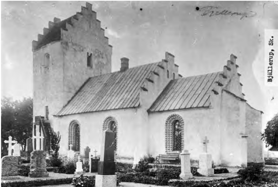
Bjällerups kyrka, odaterat foto. Koret och långhuset har varit täckta med bly sedan lång tid. Korettakets blytak ser ut att ha samma utseende som taket hade fram till september 2018. Foto Riksantikvarieämbetet.
