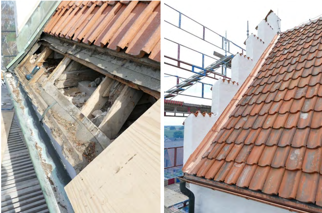
T. v: I det sydvästra hörnet där sparränder och murrem rötskadats vid tidigare takläckage gjordes en lagning med nytt virke. T. b: Det nylagda torntakets anslutningsplåt är smäckrare än den förra och klippt efter pannorna.
