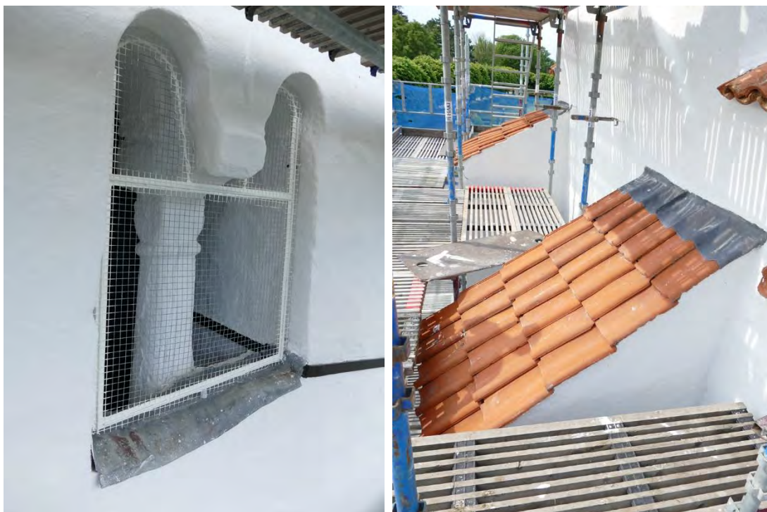
T. v: En av de medeltida kolonetterna som bevarats i tre av tornets ljudöppningar. T. h: Avtäckningen på kortets två strävpelare kompletterades med ny blyplåt.
