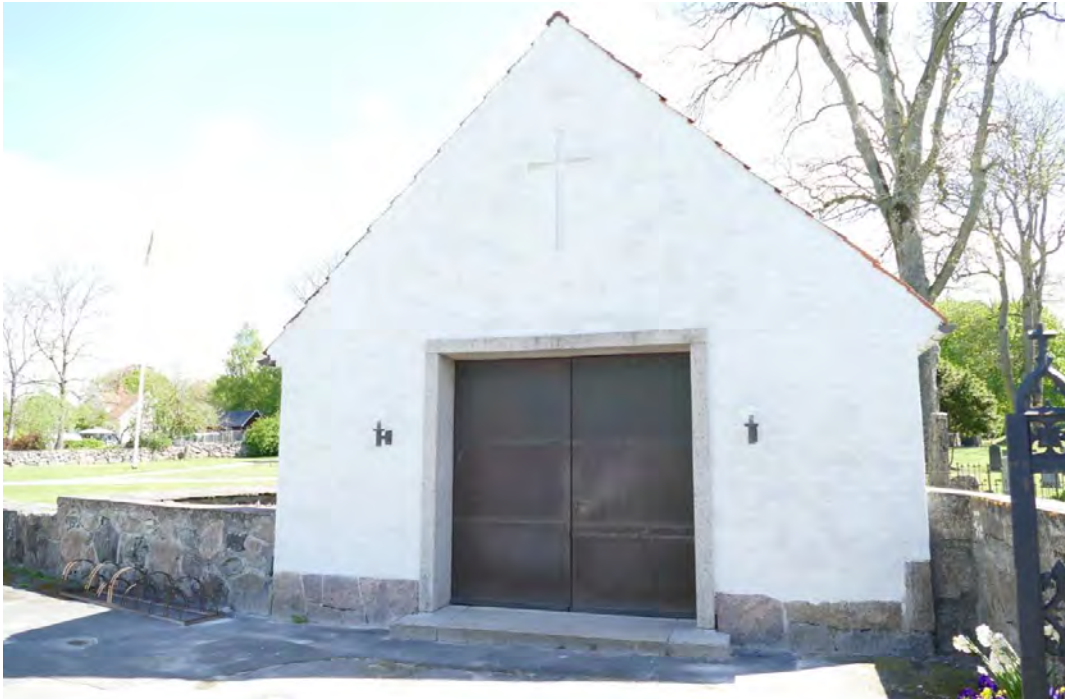
Bårbusets västra fasad efter färdigställd fasadrenovering.
