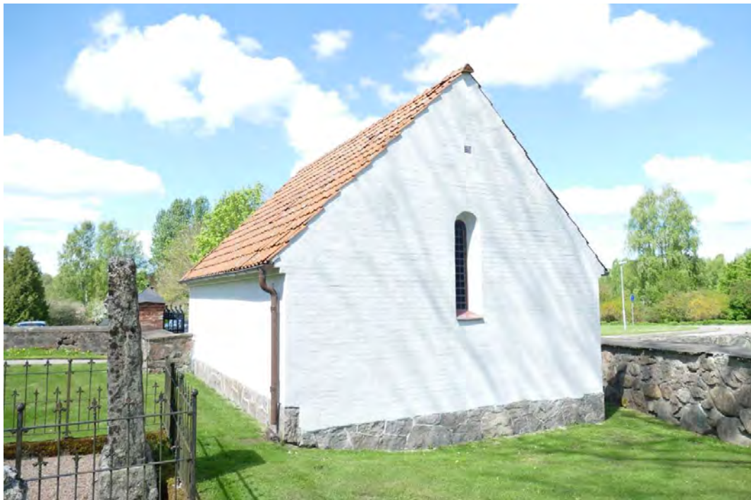
Bårbusets södra och östra fasader efter färdigställd fasadrenovering.
