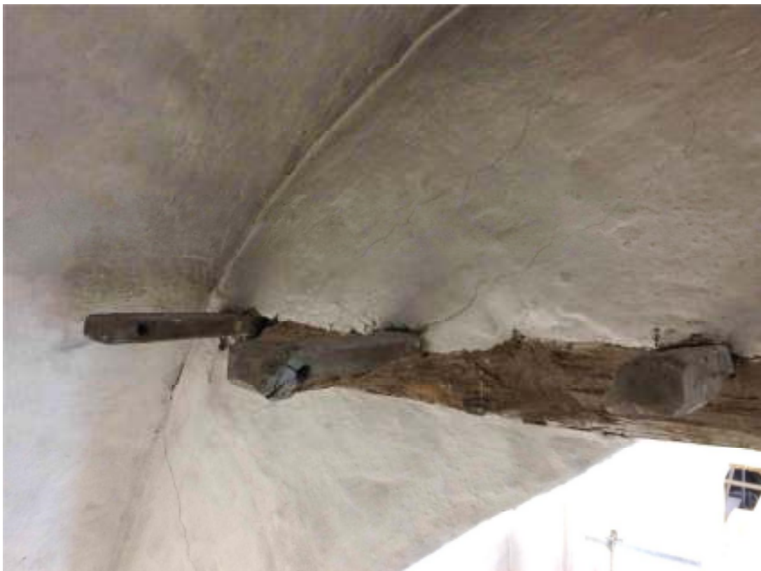
Båda bilderna ovan visar den bevarade, medeltida upphängningsanordningen för primklockor som sitter inmurad i valvbågen, mellan koret och absiden. Bjälken och de tre dubbarna är av ek. Håltagningarna i dubbarna vittnar om att här sannolikt hängt två klockor. Regionmuseet erfar att den bevarade konstruktionen är sällsynt, om inte unik i landet.
