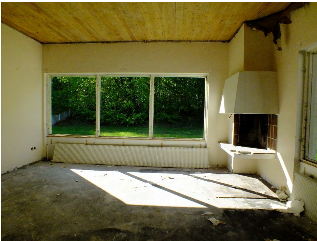
Ett av vardagsrummen strax innan rivningen fullbordades. Besöket mitt under pågående rivning möjliggjorde en studie av ljusflöden.
