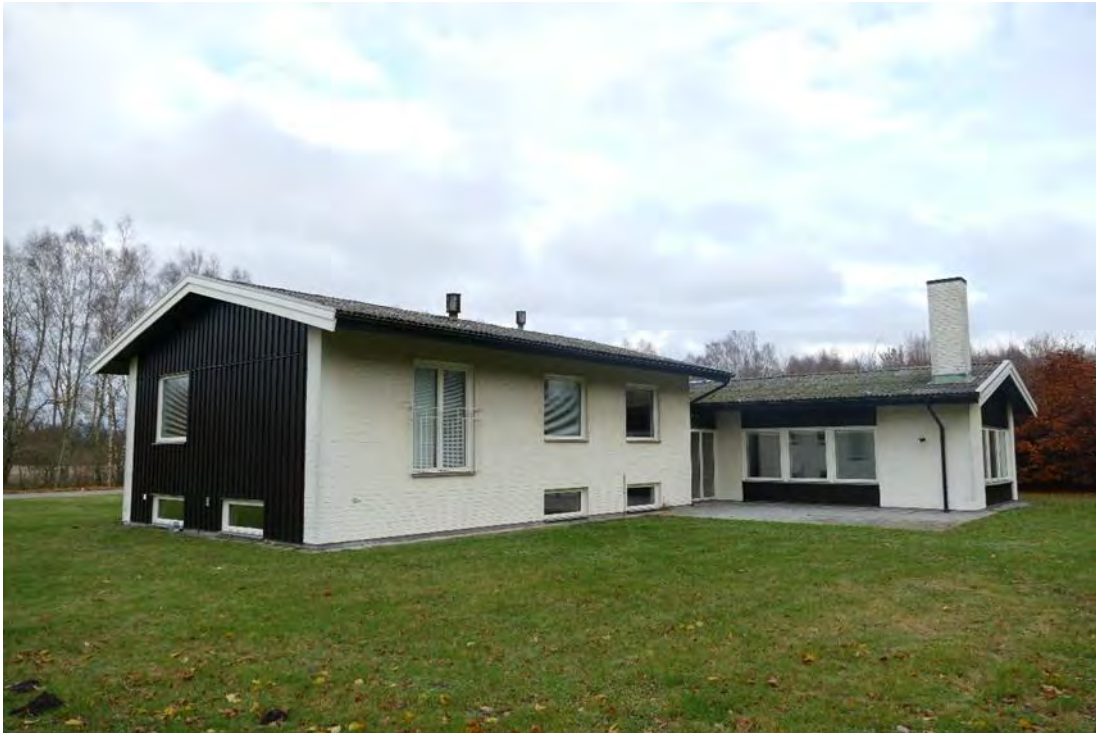
Villan söderifrån. Här syns funktionsuppdelningen, sovrumssavdelning i den lite bögre byggnadskroppen och sällskapsutrymmen i den lägre.
