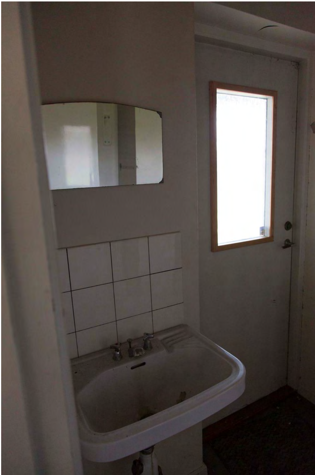
Interiör från en av villornas grovkök. Detaljerna är enkla med välgjorda, allt ifrån handfat, parti med skyddande kakel, till köksingångens dörr med ljusinsläpp.
