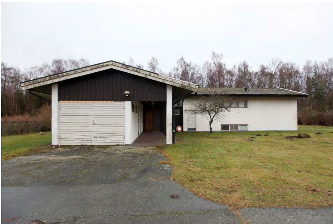
Exteriört byggdes tjänstemannavillorna identiska med garagelängornas gavlar ut mot Garvarevägen. Till höger syns buskroppen som inrymde sovrumssavdelning på övre plan och källarvåningen där det fanns tvättstuga, el- och värmecentral, förråd och hobbyrum.
