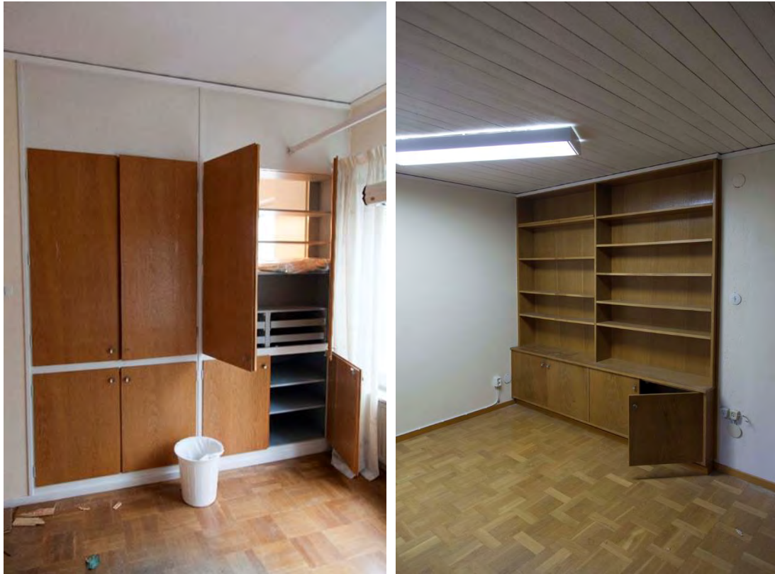
Till vänster serveringskåp, nåbara från såväl kök som matsal, ett exempel på arkitektonisk och funktionalistisk ambition i interiören. Till höger en inbyggd bokhylla i ett av villornas vardagsrum. I ett par av villorna var denna del av vardagsrummet avdelad med vägg till ett separat allrum/ tv-rum. Den snedställda armaturen är sentida, sannolikt monterad då villan inte längre användes som bostad.
