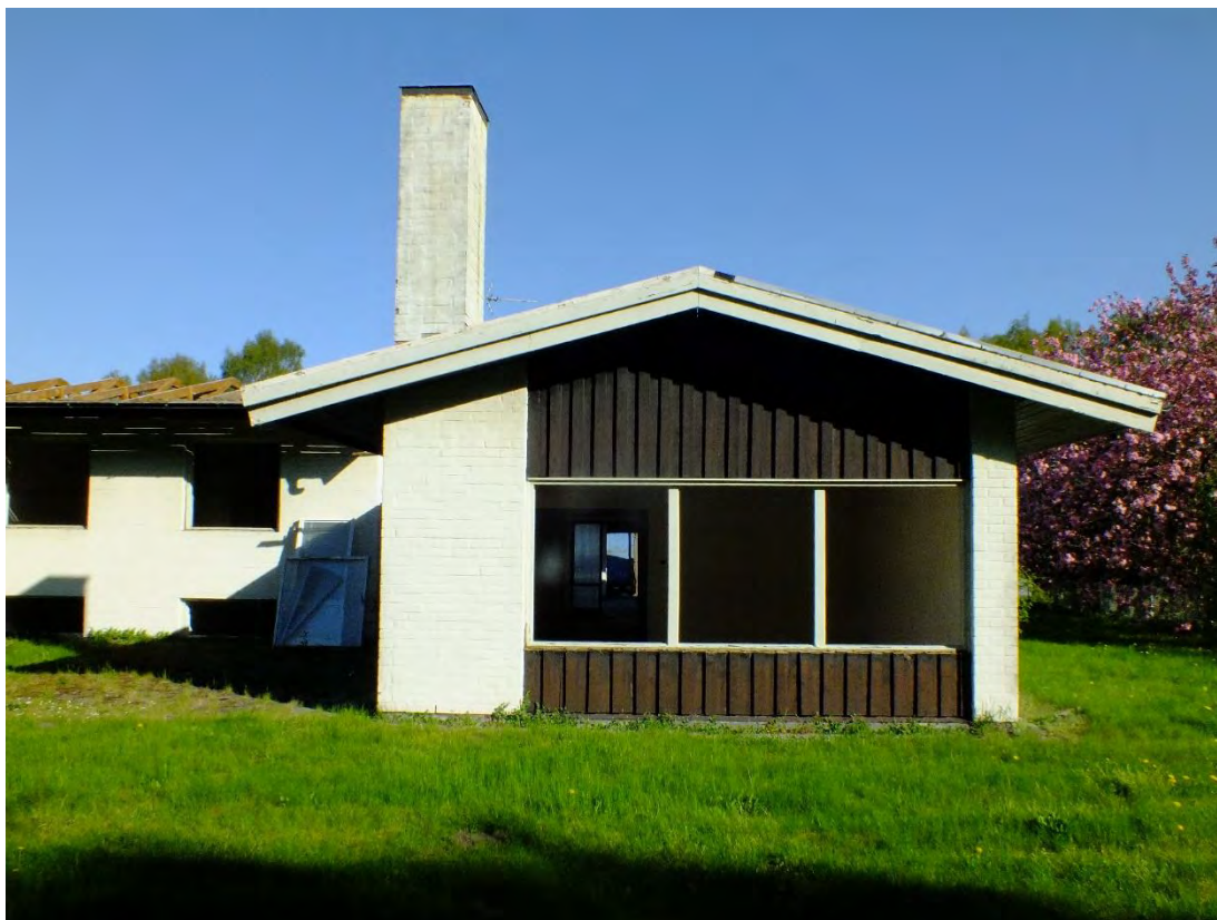
Gaveln på en av tjänstemannavillornas vardagsrum. Till vänster i bild syns sovrumsdelen, strax innan takstolarna demonterades.
