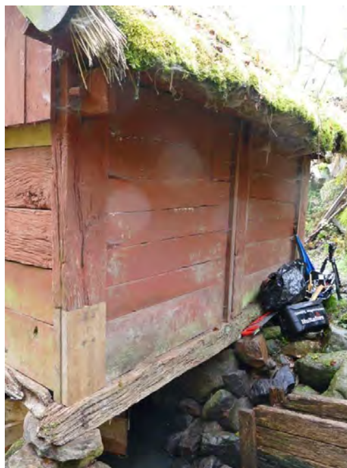
En ny del i den norra stolpen lusades i. Fotträna som ser slitna ut kunde dock bevaras. Foto Jens Ingvad. T. v: I samband med att båleplanken sattes tillbaka kunde väggen göras tätare genom att en ny smalare del fällas i längs upp. De invändiga golvlankan skyddas numera av väggen. Stengrunden under stolpen kompletterades med en sten så att skvaltän kom i våg.
