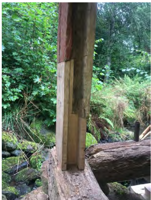
En ny del i den norra stolpen lusades i. Fotträna som ser slitna ut kunde dock bevaras. Foto Jens Ingvad. T. v: I samband med att båleplanken sattes tillbaka kunde väggen göras tätare genom att en ny smalare del fällas i längs upp. De invändiga golvlankan skyddas numera av väggen. Stengrunden under stolpen kompletterades med en sten så att skvaltän kom i våg.
