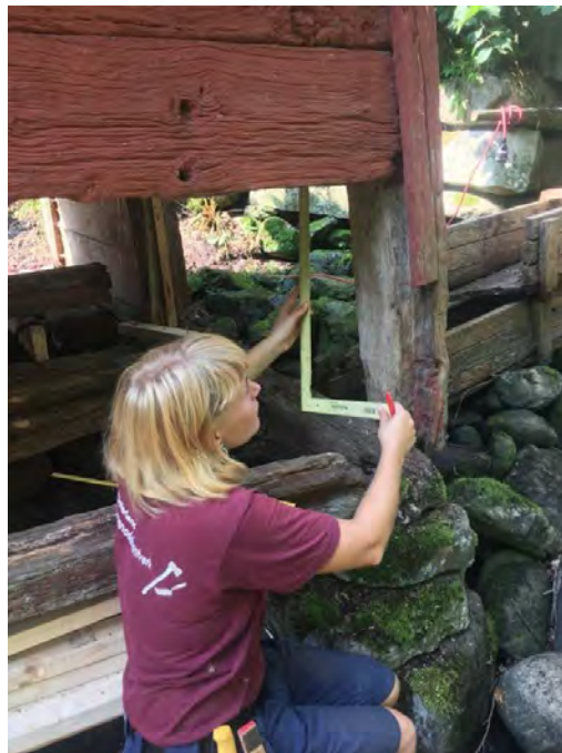
Stolpen i möllans norra hörn var fäst i syllan med ett smalt järnband. T. b: De nedre båleplanken togs ner och stolpen mättes upp. Foto Jens Ingvad.
