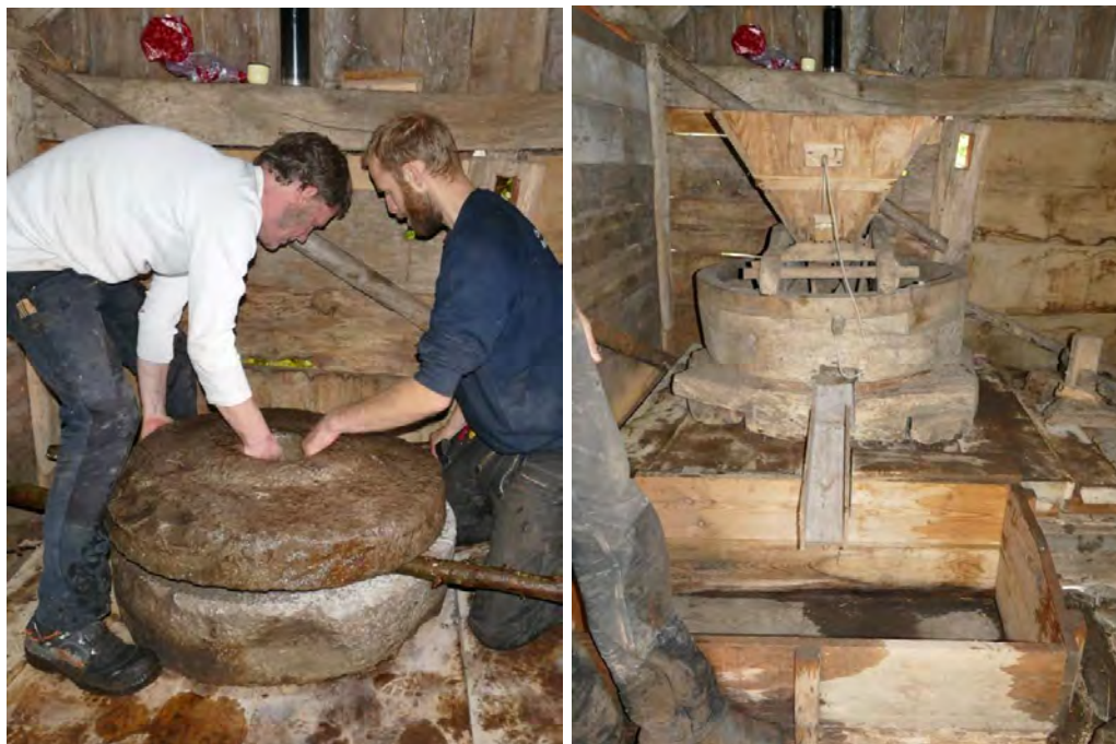
Löparen kommer på plats. T. h. ses kvarnhuset som dammades av och återanvändes. Golvet lades nytt likt det förra med grova plank. Hävstången som återanvändes skymtar till höger.
