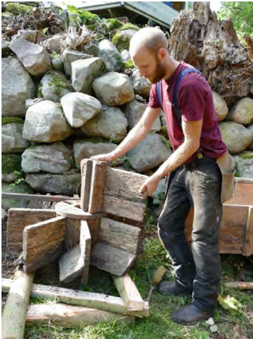
T. v: Det befintliga skovelhjulet underst och det som timmerman Jens Ingvad håller i är från 1970. T. h: Det nya skovelhjulet tillverkades av virke från den ek som stått intill möllan. Foto Jens Ingvad.
