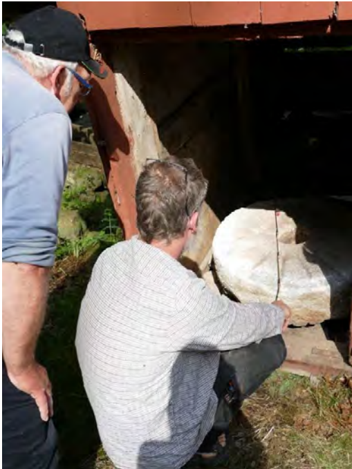
Kvarnstenarna (liggaren t.v. och löparen t. h.) togs ut och undersöktes. I löparen sitter fyrgrenskorset som driver stenen. Det gamla lagret, träklossen, som håller axeln på plats och som sitter i liggaren, ses på löparen.
