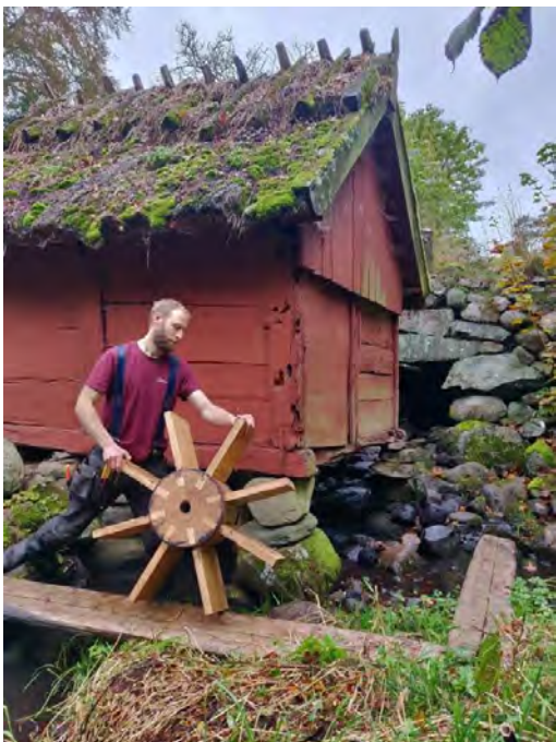
T. v: Det nya skovelhjulet. Foto Jens Ingvad. T. h: Det nya skovelhjulet efter att det kommit på plats. Järnbandet och axeln som driver kvarnstenarna återanvändes och justerades hos smed.
