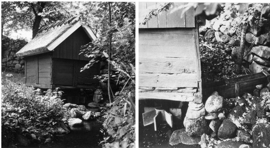
Efter att skvaltån återuppbyggs och fått nytt skovelhjul. Foton från 1970 respektive 1981, Regionmuseet Kristianstad.
