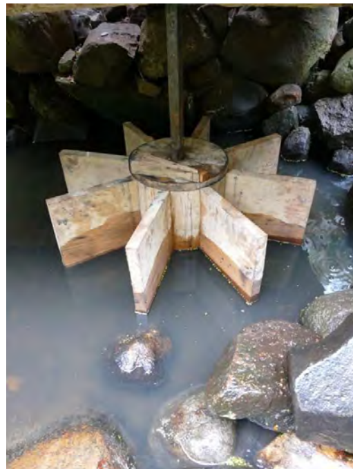
T. v: Det nya skovelhjulet. Foto Jens Ingvad. T. h: Det nya skovelhjulet efter att det kommit på plats. Järnbandet och axeln som driver kvarnstenarna återanvändes och justerades hos smed.
