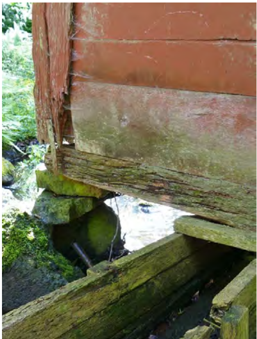
Stolpen i möllans norra hörn var fäst i syllan med ett smalt järnband. T. b: De nedre båleplanken togs ner och stolpen mättes upp. Foto Jens Ingvad.
