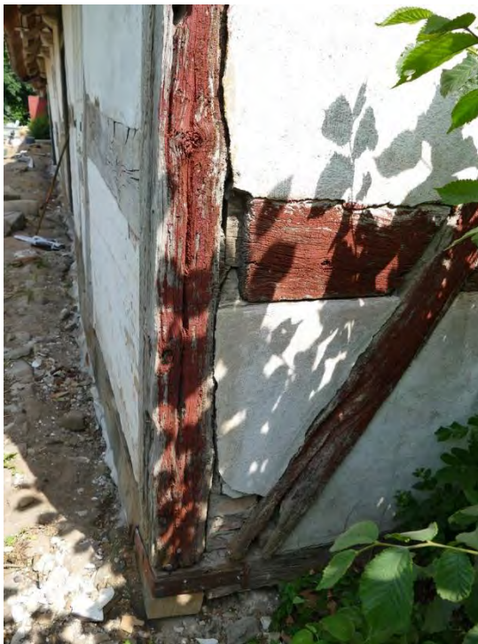
På den södra gaveln, närmast den västra fasaden, ersattes en del av snedstyvan. Även lösbulen som glidit ur sitt läge fylles i med nytt virke.
