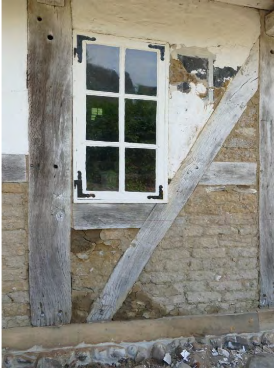
På den västra fasaden lossnade en del av kalkfärgen kring det lilla brygghusfönstret varmed ett gammalt blindfönster kom fram. T. b. ses en del av samma väggarum efter att lagningarna gjorts. De smala springorna tätades med tjärat lindrev.
