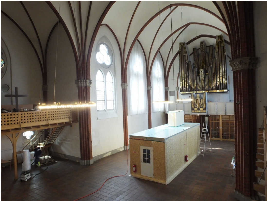
Vy från norra sidoläktaren över södra sidoläktaren, långhuset och orgelläktaren. Bilden är tagen i april 2018 då kyrkorummet har tömts inför renoveringen. I fönsteröppningarna närmast orgelläktaren sitter fortfarande gardinuppsättningarna som demonterades i samband med renoveringen för att sedan ersättas av solskyddstextiler. Mitt i rummet står en specialbyggd bod där en del av de kyrkliga inventarierna förvarades under renoveringen.
