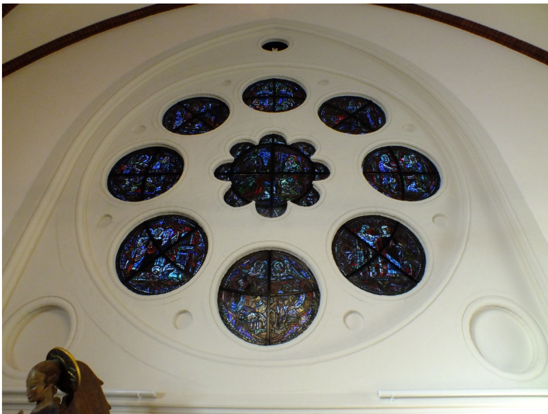
Rosettfönster i norra korsarmen efter ommålning och rengöring av fönsterglasen invändigt, november 2018. Nederst sitter ett par nya värmerör i samma modell och på samma plats som de gamla.
