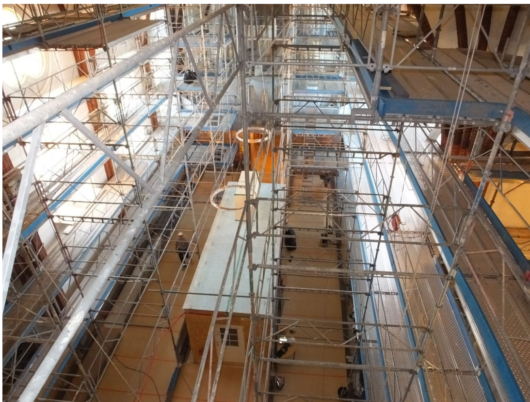
Ett enormt ställningsbygge föregick själva renoveringen. Juni 2018.
