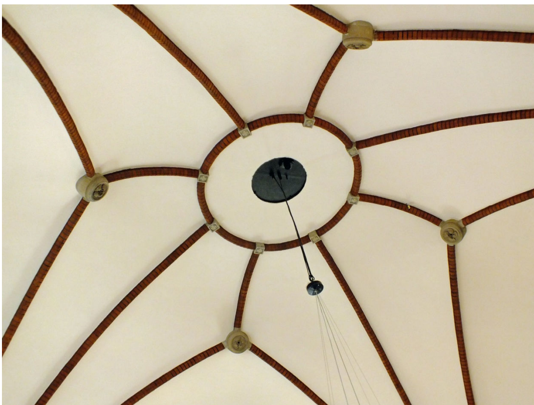
Mittkorsets valvkappa efter renovering, november 2018. Under putsen döljer sig troligen delar av de ursprungliga takmålningarna.
