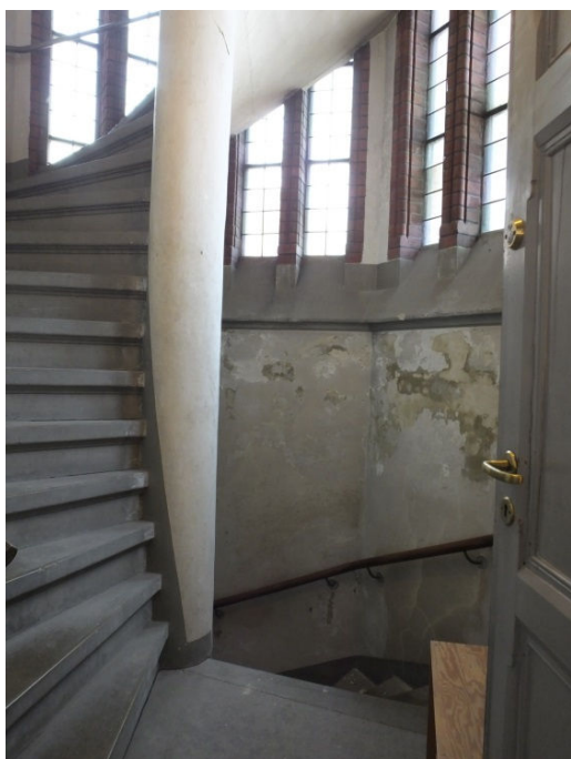
Norra torntrappan inför renovering, april 2018. Under senare vita och gråa färger fanns tydliga färgspår efter en äldre färgsättning med en mossgrön kulör.
