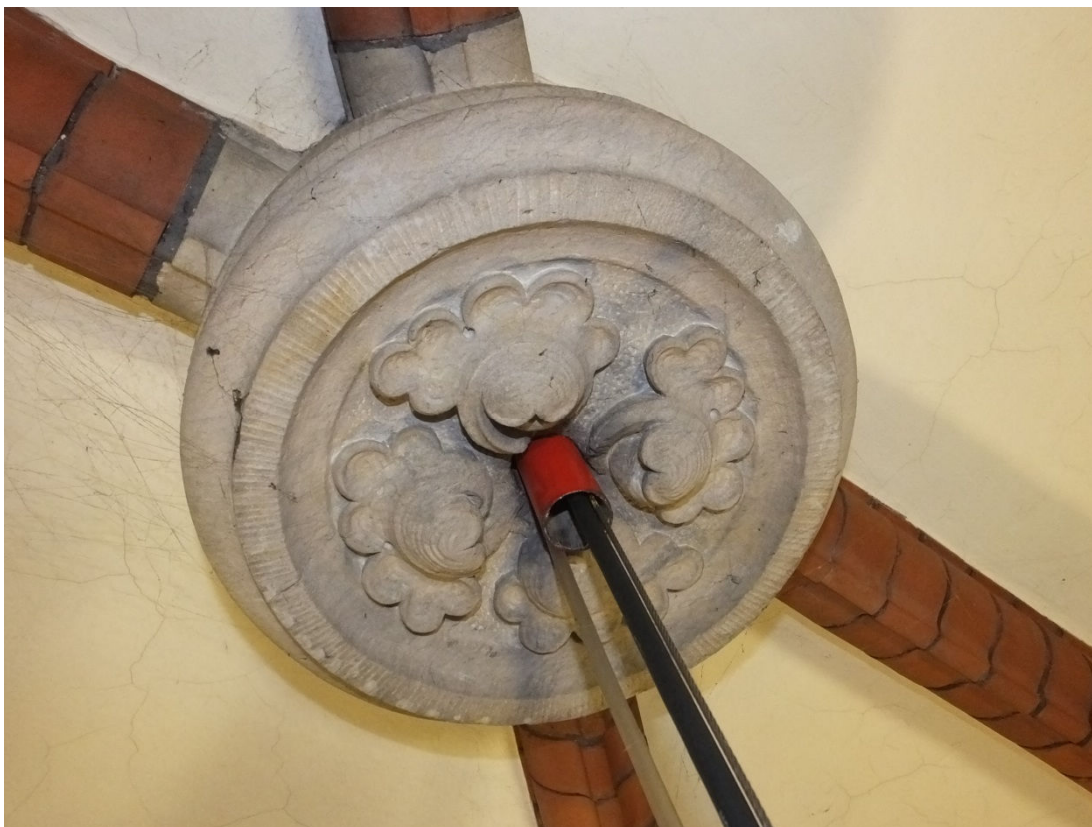
Dekorativ slutsten i gjuten och ytbuggen betong längst upp i valven. Stenarna var i gott skick men täckta med ett tunt lager av damm och spindelväv. Inför rengöring juni 2018.
