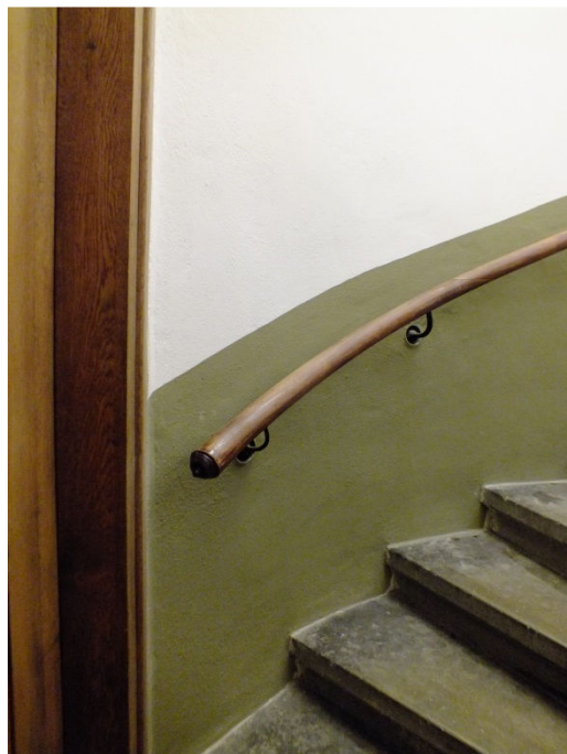
Efter samråd med beställare beslöts att torntrappan skulle få en mörkare bröstning med den ursprungliga tidstypiska kulören som i övrigt inte finns bevarad i kyrkan.
