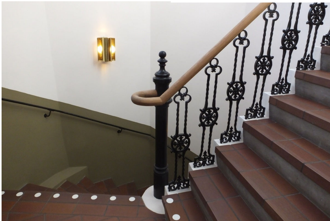
Södra torntrappan efter ommålning, november 2018. Även i södra torntrappan använde man sig av den ursprungliga kulören för en målad bröstning.
