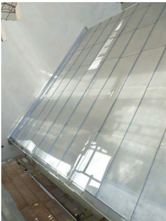
Kortakets södra takfall. T. h: I det sydöstra hörnet gick taket ut en bit över gavelmuren vilket löstes med en smal plåtskiva. Takfotens sida är plåtklädd.
