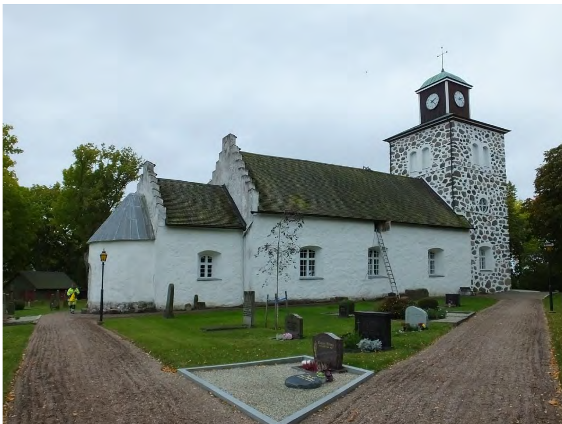
Tåstarps kyrka, september 2016. Långhusvinden nås via en lucka på den norra sidan.
