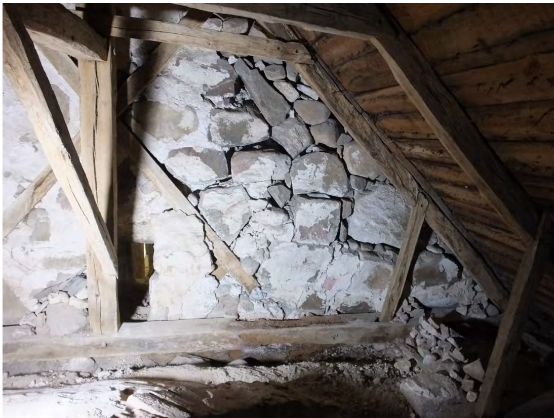
Den östra korgaveln som vetter inåt koret (mot väster). I denna gavel finns delvis ett ursprungligt taklag från 1100-talet bevarat. Den södra delen av murverket var i dåligt skick och fick muras om.
