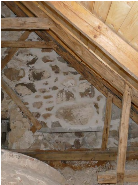
T. v: Vid nedplockningen av korgaveln kunde man se hur snedsträvan anslöt till den bakom-/underliggande delvis bevarade bindbjälken (se föregående sida). T. h: Samma gavel efter att den återställts. En järnbalk murades in i syfte att avlasta och bevara den medeltida konstruktionen med bindbjälken.
