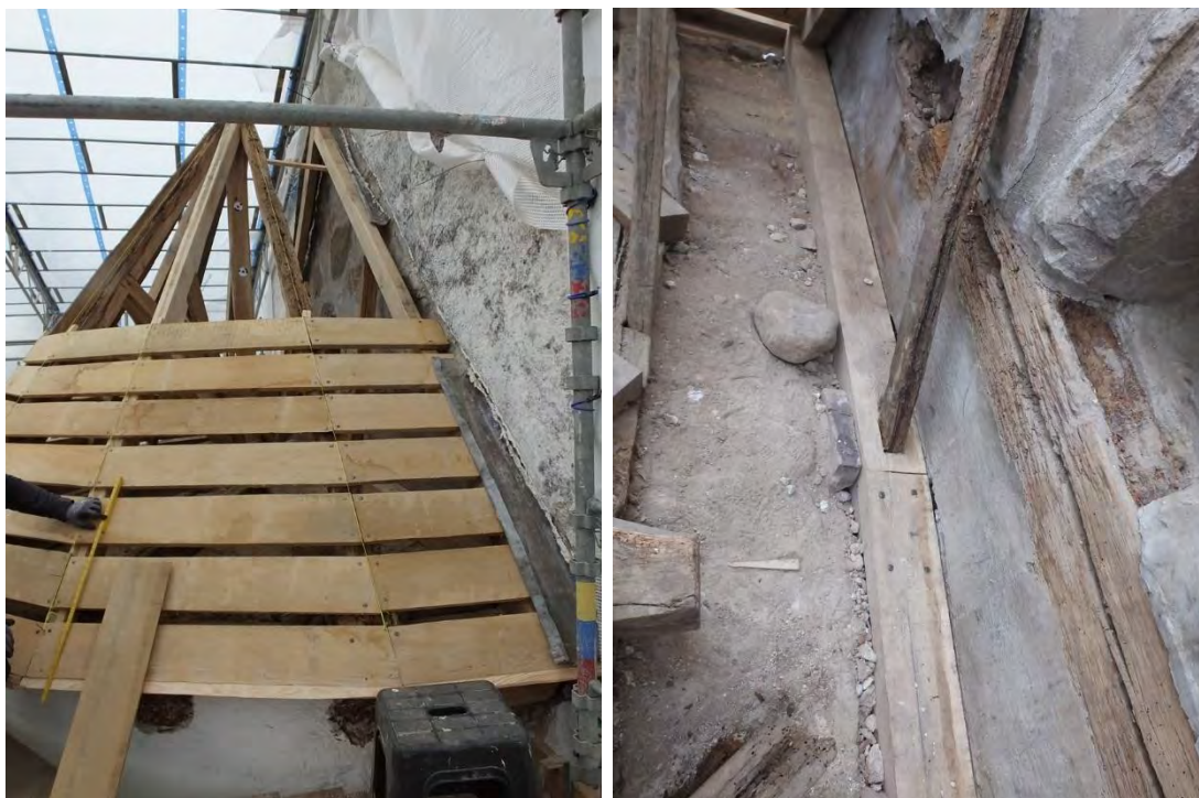
T. v: Underbrädningen med brädor av fur spikades på sparrarna. Till höger ses en ny, skarvad bindbjälke med en återanvänd, medeltida stötta.
