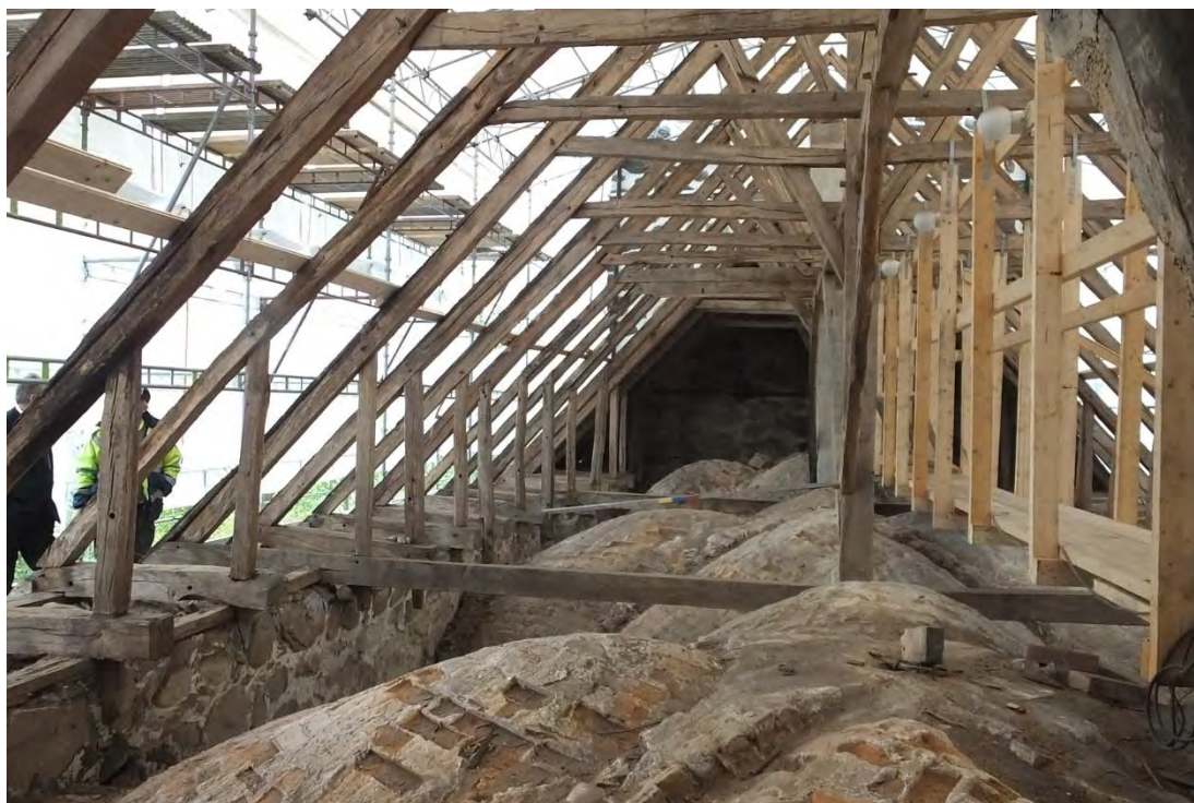
Bild tagen över långhuset i maj 2018 efter att taket tagits ner och innan lagningarna av taklaget påbörjats.
