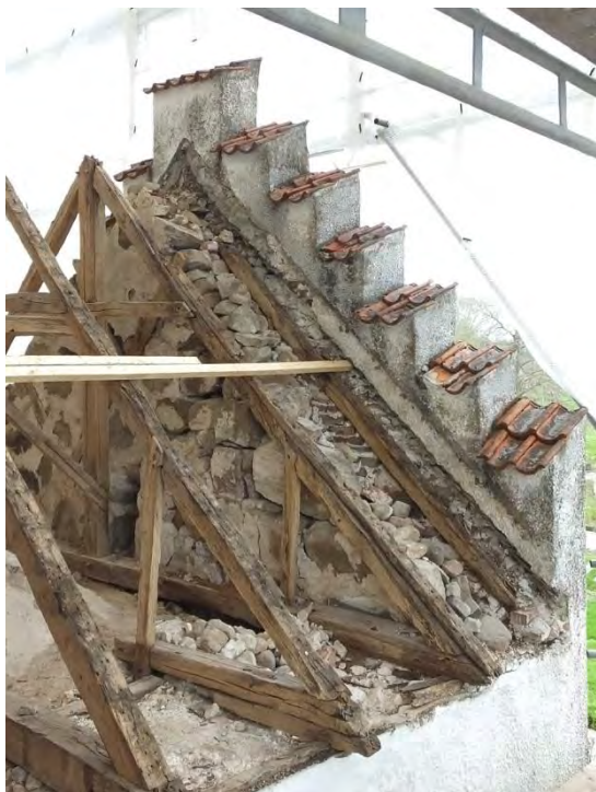
Den östra korgaveln efter att taket tagits ned. Bjälken uppe på gavelmuren ersattes med en ny. T. h. ses den största delen förmultnade bindbjälken som fanns under den nuvarande och som hört till den äldsta konstruktionen.
