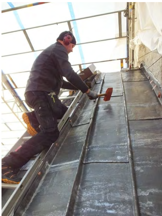
T. v: Falsarna på skivtäckningen slås och t. h. ses de nygjutna skivorna efter att taket lagts klart.
