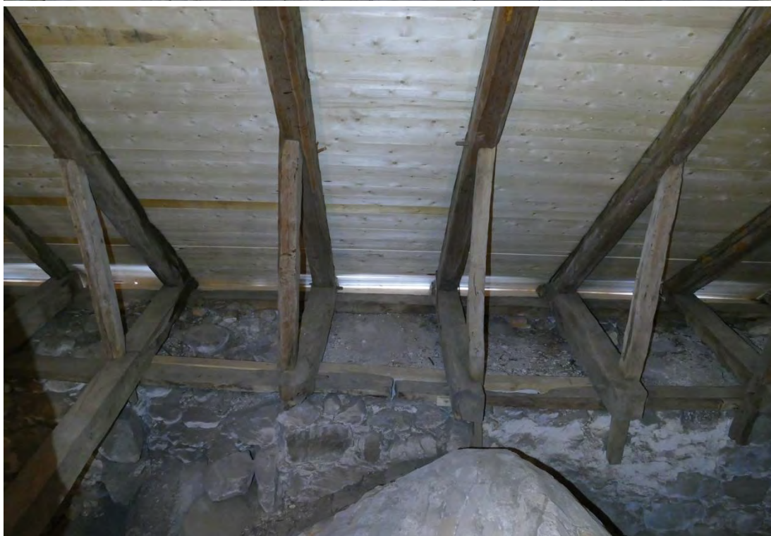
Lagningar av remstycken på norra (längst upp) och södra sidan (ovan) i långhuset. På bilderna skymtas också de järn som förstärker takstolarnas knutpunkter mellan sparrar och stickbjälkar.
