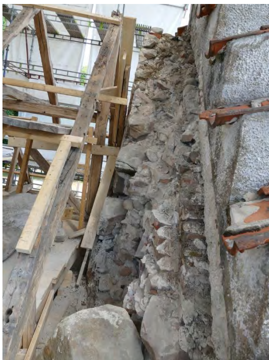
T. v: Den östra korgaveln efter att den yttre skalmuren som inte var fast förankrad i resterande murverk. T. h. ses den provisoriska plattform som uppfördes och de stora grästenar som plockades ner vid återställandet.
