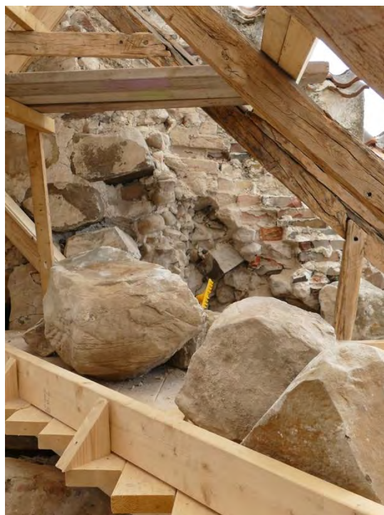
T. v: Den östra korgaveln efter att den yttre skalmuren som inte var fast förankrad i resterande murverk. T. h. ses den provisoriska plattform som uppfördes och de stora grästenar som plockades ner vid återställandet.
