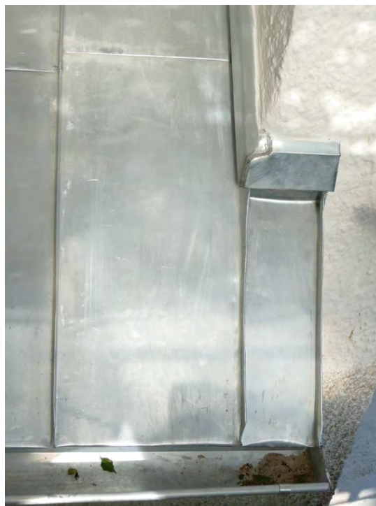
Kortakets södra takfall. T. h: I det sydöstra hörnet gick taket ut en bit över gavelmuren vilket löstes med en smal plåtskiva. Takfotens sida är plåtklädd.
