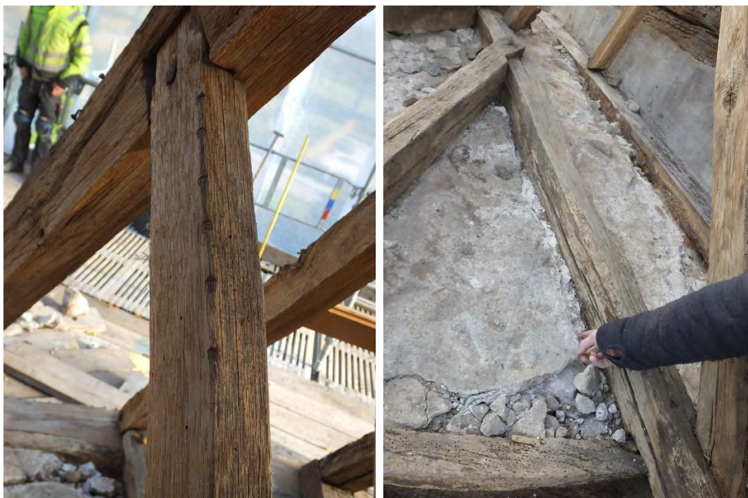
T. v: Märkningen med numrering på de ursprungliga stöttorna. T. h: Gjutningen över valvet bedömdes som ursprunglig. I nedre delen av bilden syns det fint rundade remstycket, se vidare nedan.
