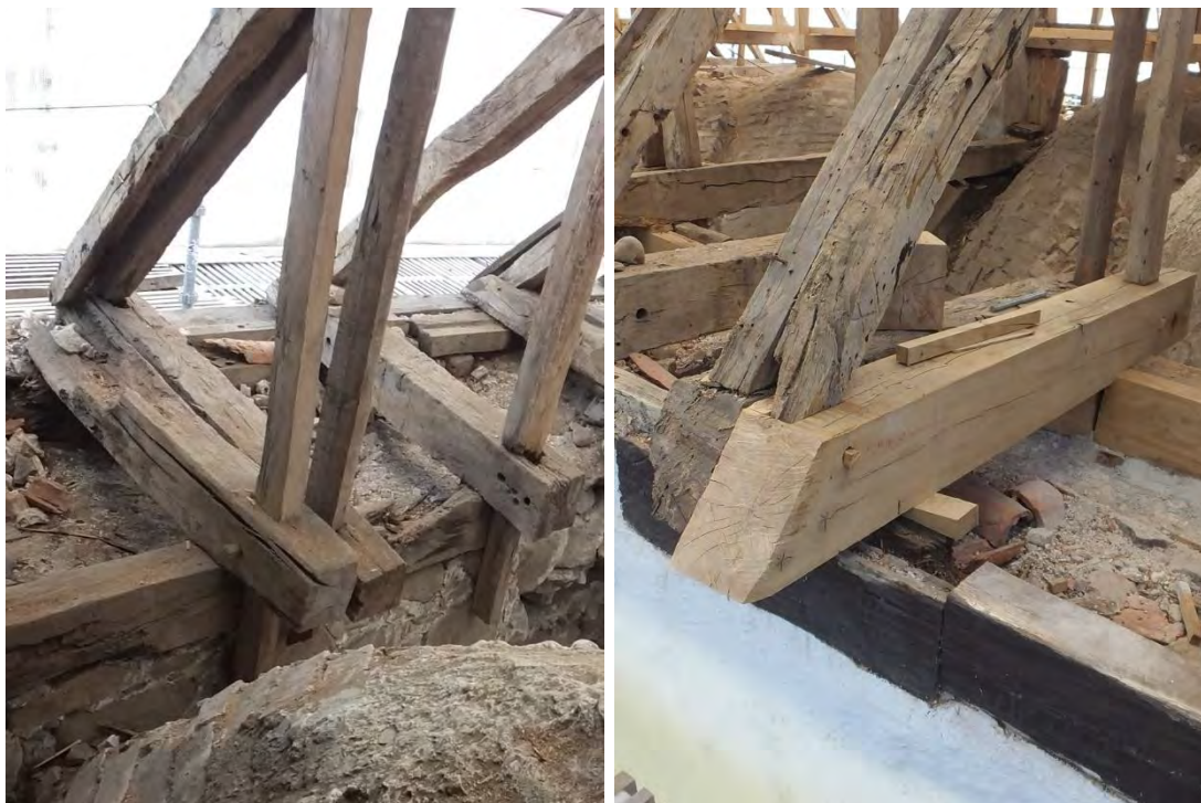
Ersättning av skadad stickbjälke på den norra sidan av långhuset, vid takstol med märkningen XI.
