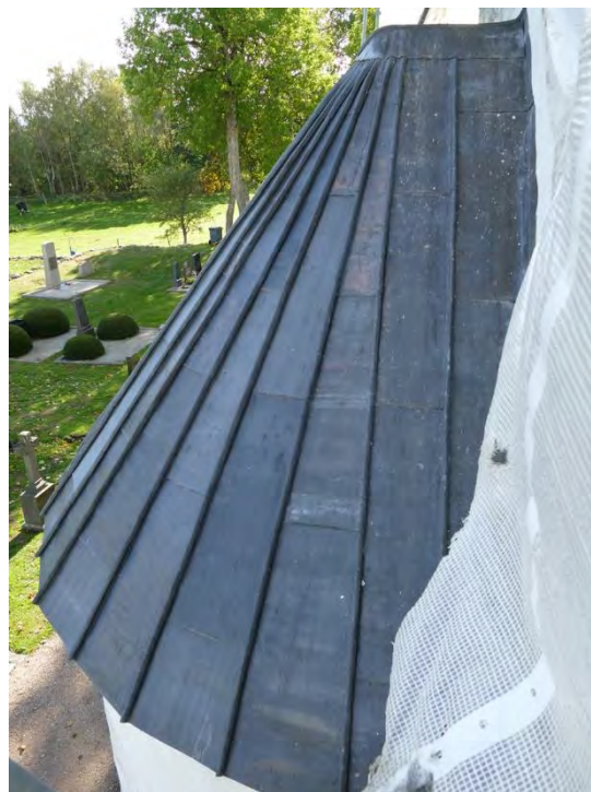
T. v: Falsarna på skivtäckningen slås och t. h. ses de nygjutna skivorna efter att taket lagts klart.
