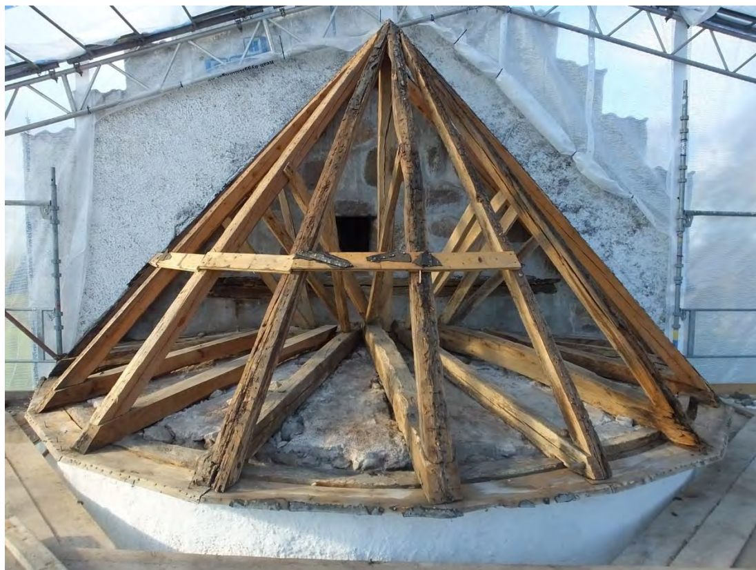
Absidens taklag före byte av skadade delar. Taklaget dokumenterades och det gjordes även en 3D-modell.
