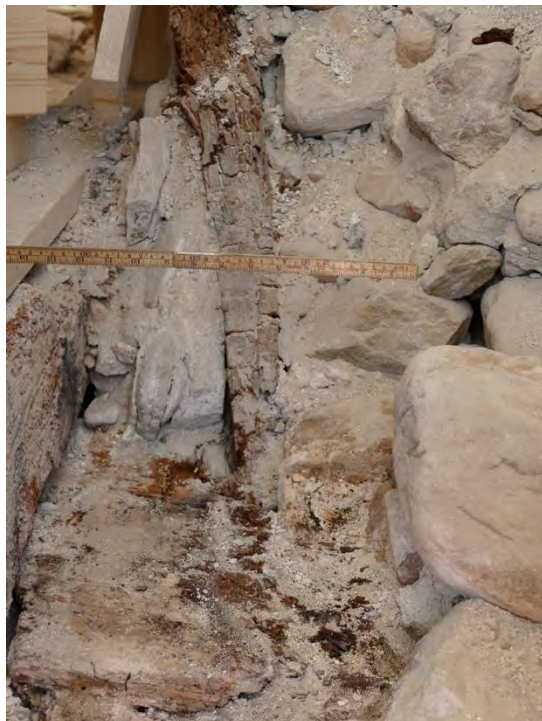
T. v: Vid nedplockningen av korgaveln kunde man se hur snedsträvan anslöt till den bakom-/underliggande delvis bevarade bindbjälken (se föregående sida). T. h: Samma gavel efter att den återställts. En järnbalk murades in i syfte att avlasta och bevara den medeltida konstruktionen med bindbjälken.
