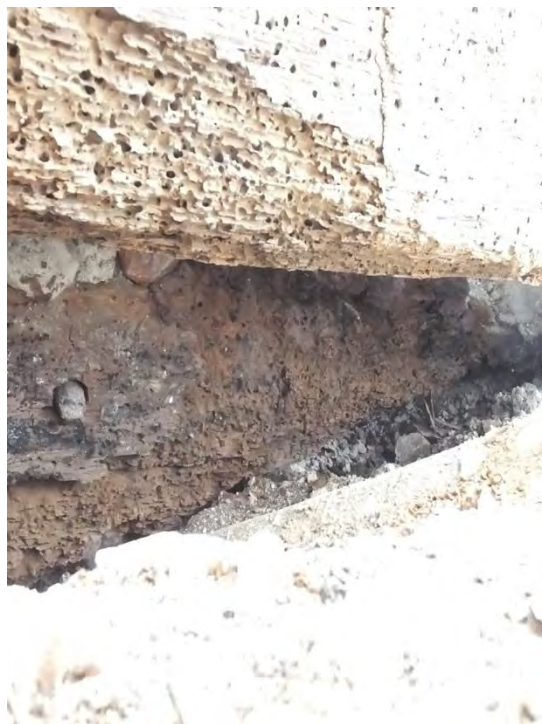
Den östra korgaveln efter att taket tagits ned. Bjälken uppe på gavelmuren ersattes med en ny. T. h. ses den största delen förmultnade bindbjälken som fanns under den nuvarande och som hört till den äldsta konstruktionen.
