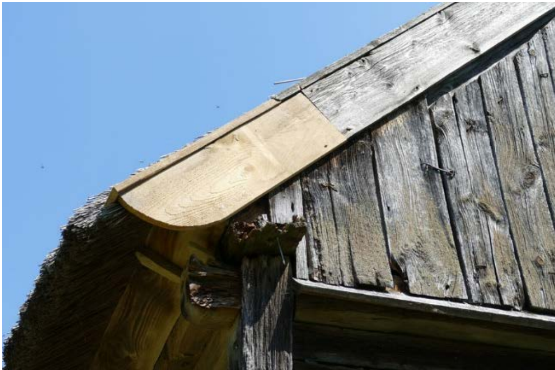
Del av logens östra gavelsida, takfall åt söder. Här har både en del av vindskeivan och solbrädan skarvats och lagats i med friskt virke.
