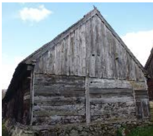
Bild 1: Stallets södra gavel med rötskadad solbräda, till höger i bild skymtar logens sydvästra hörn med samma skadebild. Bild 2: Logens östra gavel med skadad solbräda och vindskiva.
