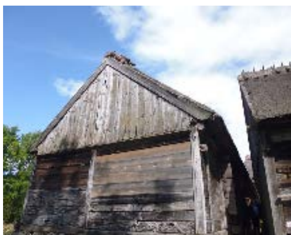
Bild 1: Stallets södra gavel med rötskadad solbräda, till höger i bild skymtar logens sydvästra hörn med samma skadebild. Bild 2: Logens östra gavel med skadad solbräda och vindskiva.
