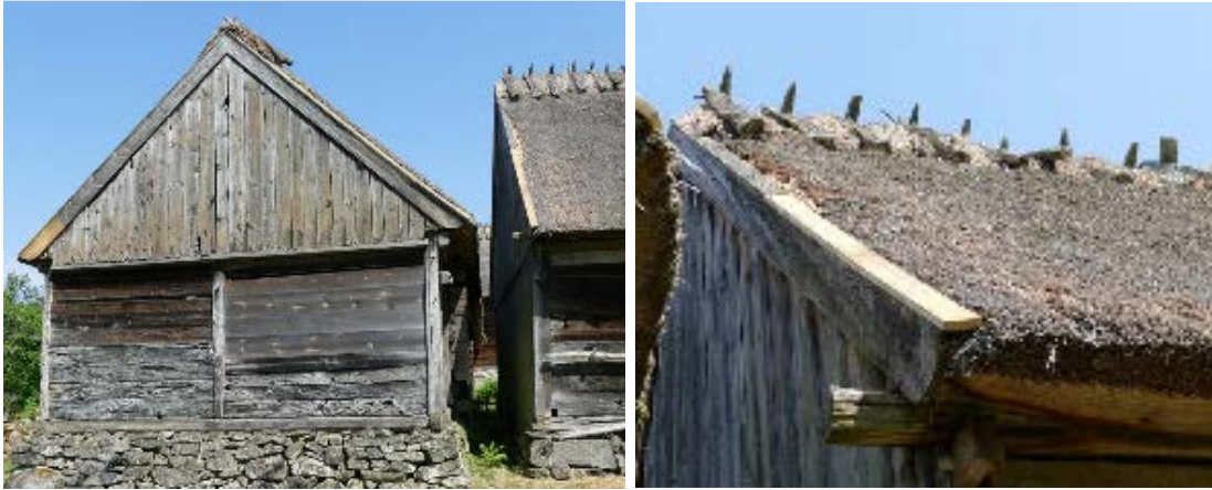
Bild 1: Stallets södra gavel sedan solbrädan har ersatts. Bild 2: Logen sedan solbrädan i sydväst har skarvats och lagats i med ny bit friskt trä.
