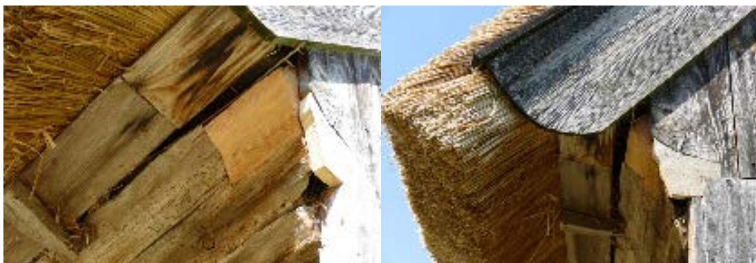
Ilagning invid takfoten i det sydöstra börnet av stugdelen samt tätning av hålrum.
