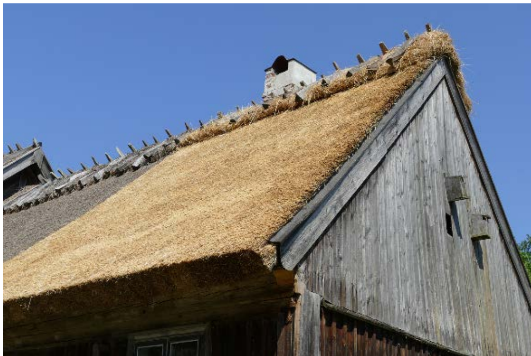
Ett sti återstod att lägga om på boningshuset södra takfall.
