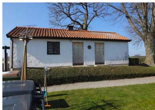
Personalbyggnadens östra fasad som vetter in mot norra kyrkogården. Till vänster på bilden syns uppställningsplats för verktyg och återvinningstunnor.
