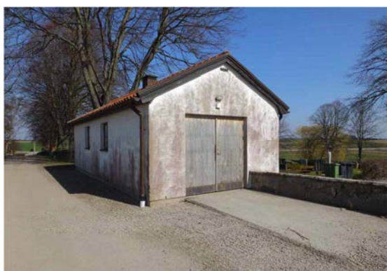
Personalbyggnaden sedd från parkeringsplatsen. Portarna har stående panel som varit oljad. Fasaden är försedd med kvastad putsyta.
