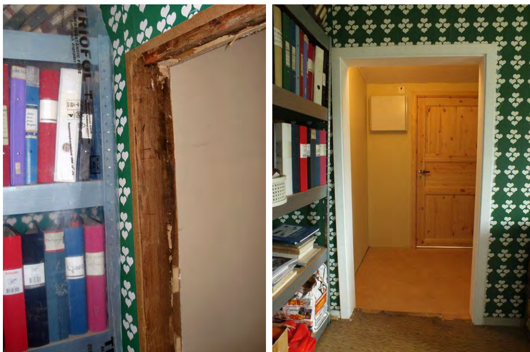
Till vänster en detalj av arkivhyllan, som i samband med toaletbyggnationen fick skyddas med byggplast. Till höger interiörbild från arkivet och in i den hall som skapats utanför den nya toaletten. Från hallen nås också ett mindre utrymme, vilket även det kommer användas för arkivets räkning.
