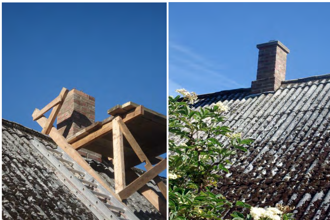
Till vänster syns skorstenen under det att renoveringen pågick. Till höger är arbetet med skorstenen just avslutat.
