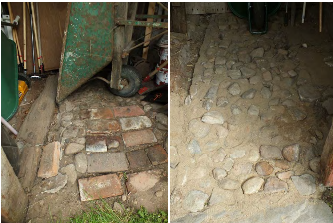
Till vänster: Foto inifrån husets förrådsdel där stenläggningen var kompletterade med tegel. Till höger, samma utrymme efter att avloppgrävningen genomförts och stenen återlagts. Här valde man att istället för tegel leta upp passande stenar för att få en helhet.
