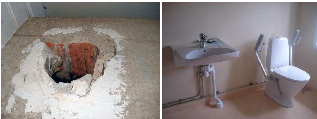
Till vänster, håltagning för den nya toalettens avlopp. Till höger toalett och handfatt på plats. Foton: Torgel Hagelin, ansvarig för Byggdelen i projektet.
