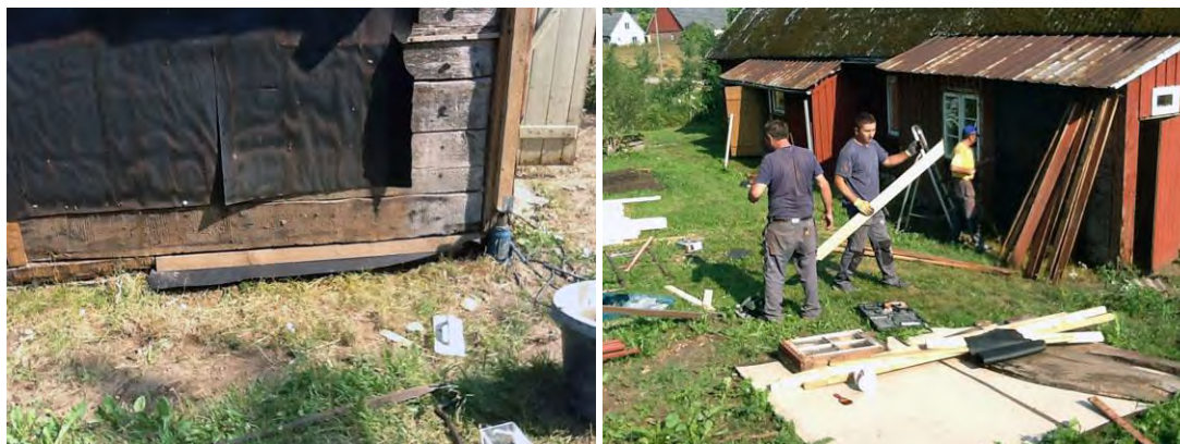
Till vänster detalj av skapade ytterväggen på baksidan av huset, där man här tagit bort panelen och frilagt timmerstommen. Till höger pågår arbetet med att såga till de nya panelbräderna.
