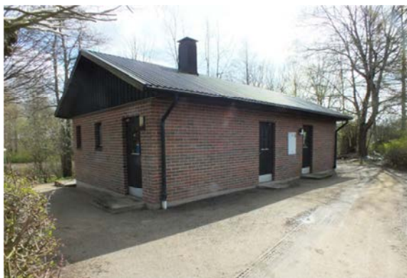
På bilderna ses kyrkogårdens respektive begravningsplatsens servicebyggnader. Den senare bör vara uppförd i början av 1970-talet i samband med renovering av begravningsplatsen. Servicebyggnaden på kyrkogården har troligen uppförts något senare.
