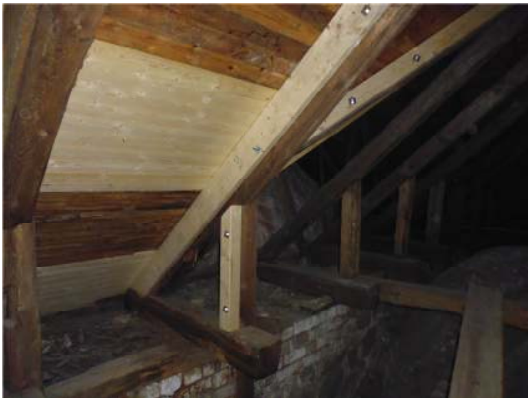
Fig. 2. Bytt underbrädning och förstärkning av sparrar, vapenhusets östra takvinkel.
