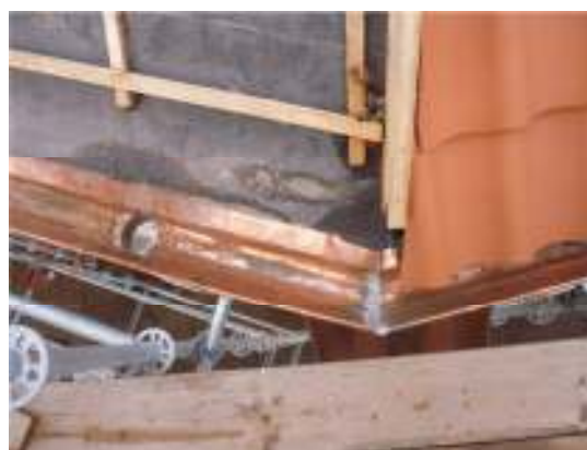
Fig. 4. Takvinkel i koromgången.
