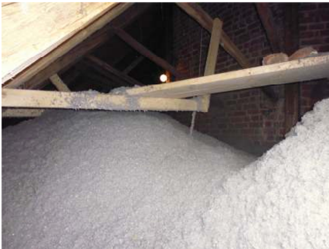
Fig. 5. Cellulosaisolering på vinden ovanför sidoskeppen och koromgången.
