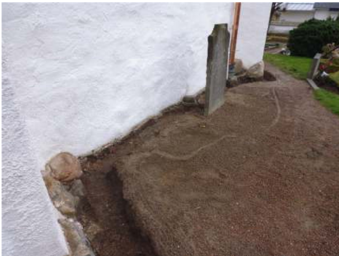
Fig. 11. Den grävda rännan längs med kyrkans grund, innan återfyllning med singel.
