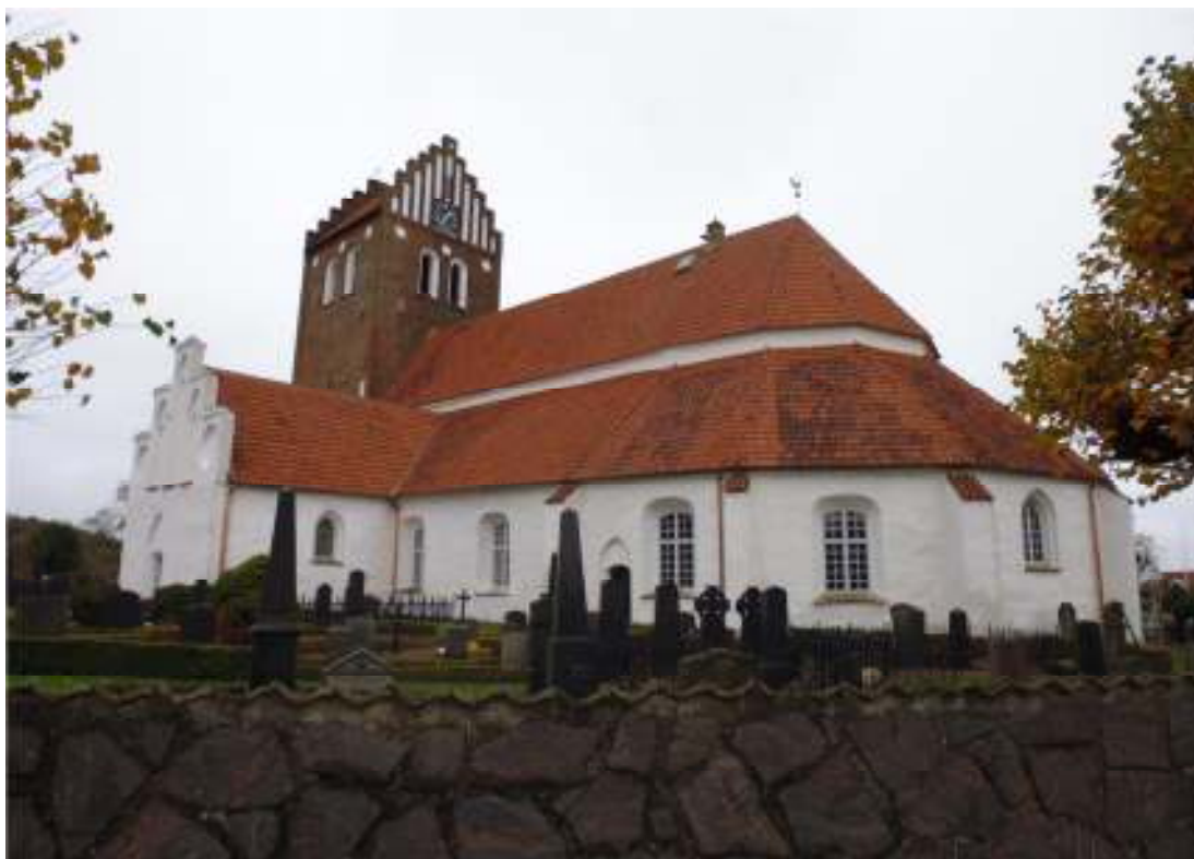
Fig. 9. Kyrkan efter arbetet. Vy mot nordväst.
