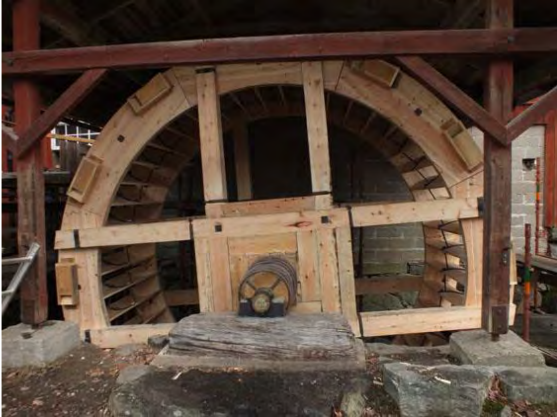
Det nya vattenhjulet i sin helhet. Bilden togs våren 2014, då det ännu återstod kringarbeten att göra.
