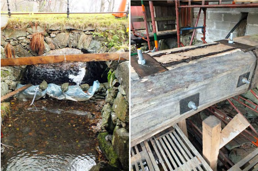
Till vänster föreningens arbete med att hålla så mycket som möjligt av det vatten, som trots allt finns i vattenrännan, borta under det att åtgärderna pågick. Sandsäckarna hade Osby Räddningstjänst lånat ut. Till höger visas skarvningen av vattenhjulets axel.
