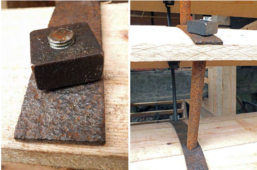
Detaljer av hur vattenhjulets delar fogas samman med hjälp av järnbeslag, skruvar och muttrar. Så långt det varit möjligt har äldre järn renoverats och återanvänts. Delar som saknats eller varit i för dåligt skick för att återanvändas, har kompletterats med nytillverkade i samma material och dimensioner.
