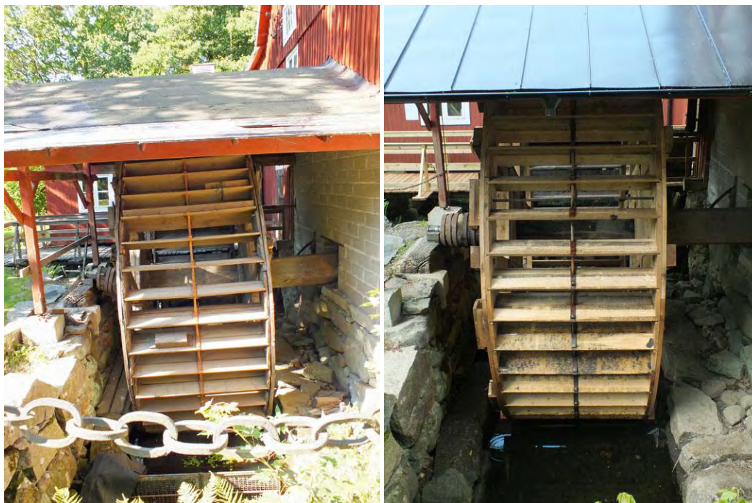
På bilden till vänster framgår att axeln i det äldre vattenhjulet är knäckt, vilket gör att nålen hänger på kanten av blocket där den är förankrad. Till höger syns det nytillverkade vattenhjulet. Här är axeln renoverad, vilket innebär att den befinner sig i våg. Nålen är förankrad och centrerad i axeln, vilket gör att nålen idag angör blocket i en stabil position.
