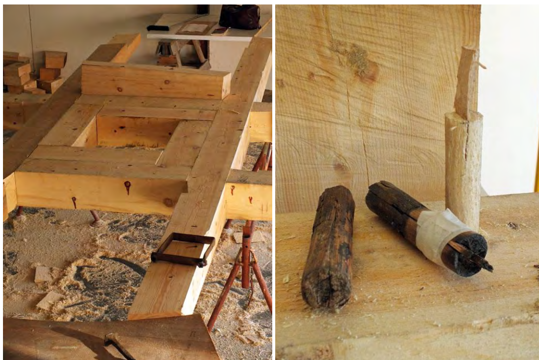
Virket till vattenhjulet är av fur som vuxit i Norrland. Bröderna Nilssons snickerifabrik i Osby har sågat och levererat virket. Till höger syns träplugg från det gamla vattenhjulet och intill dem en nytillverkad. Det är Birger Olsson, från hembygdsföreningen, som svarat för tillverkningen av nya träpluggar.
