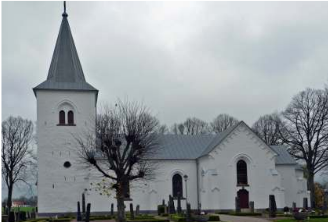
Västra Broby kyrka efter fasadrenoveringen, november 2014.
