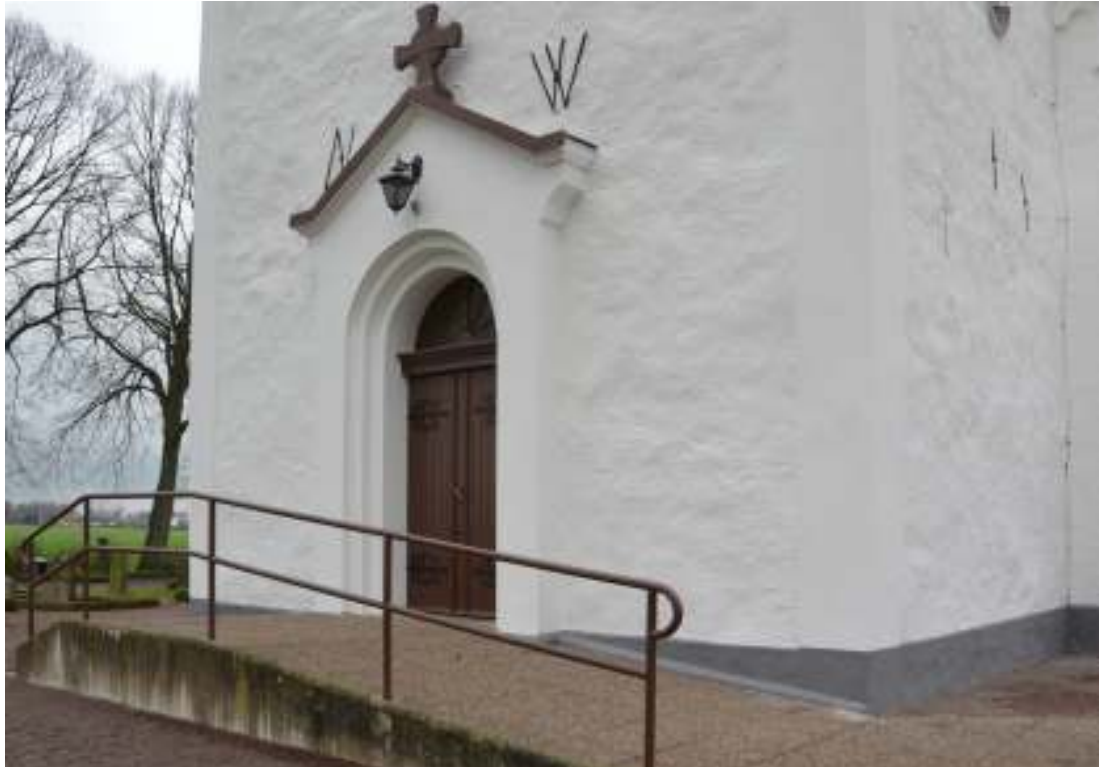
Tornet med västportalen efter renoveringen, november 2014.
