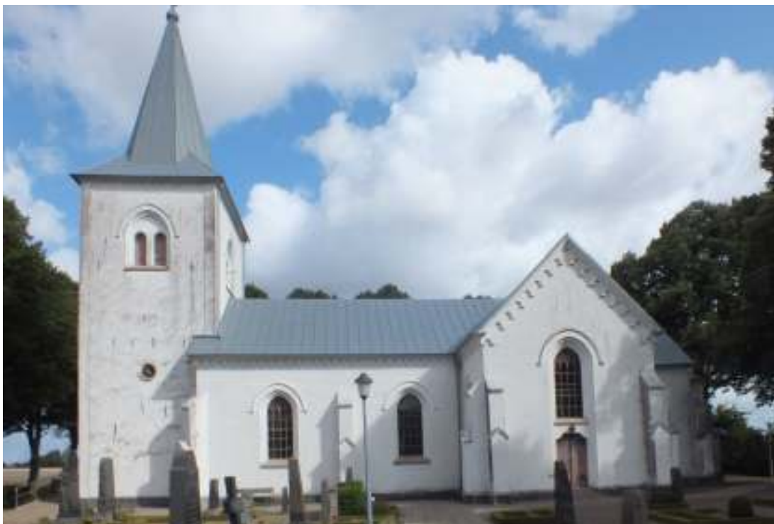
Västra Broby kyrka före fasadrenoveringen, augusti 2014.
