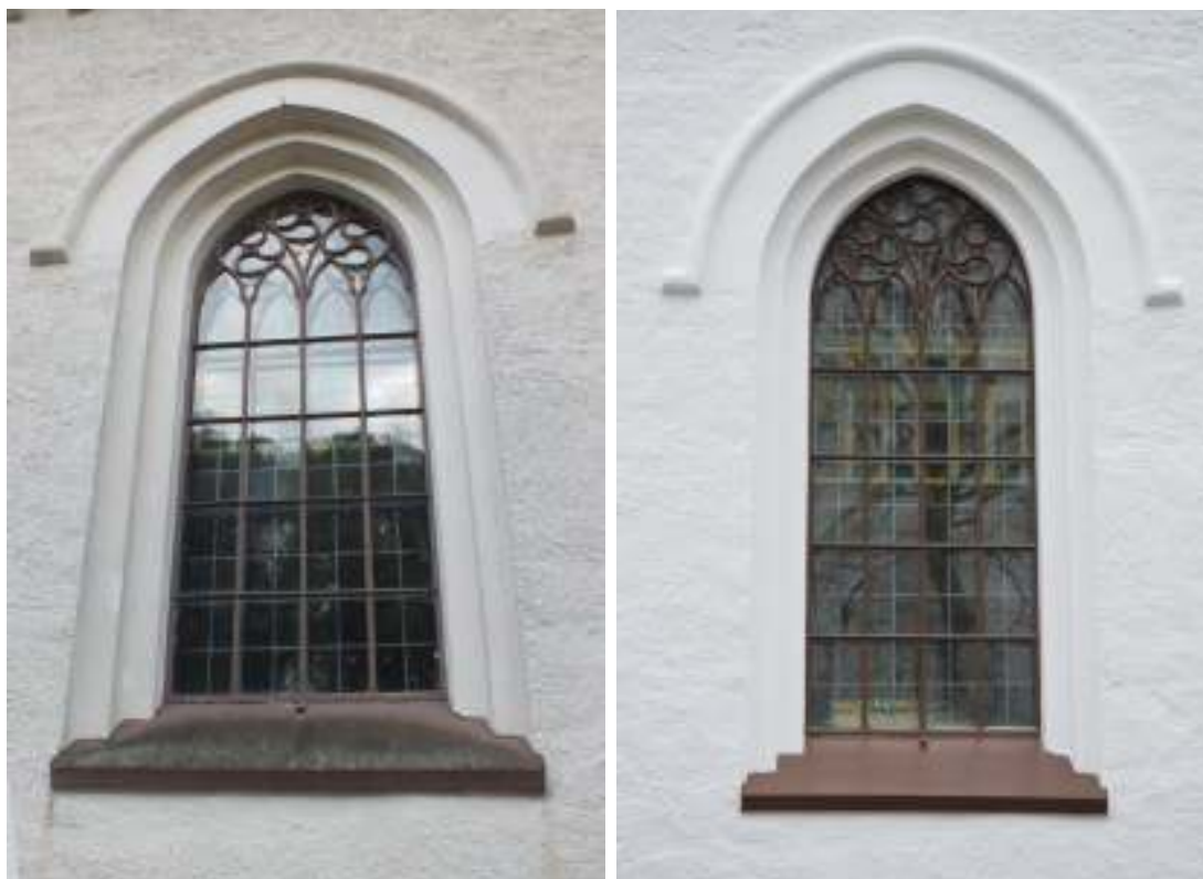
Ett av fönstren på den norra långhusfasaden, före och efter rengöring och målning med brun linoljefärg.
