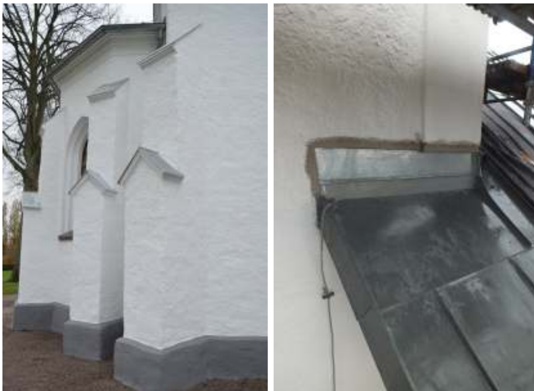
T.v: Vid absidens nordöstra sida ersattes tre plåtavtäckningar, den övre i mitten samt den vänstra nedre och den högra nedre avtäckningen är bytta. T.h: Anslutningen av långhusets takplåt vid tornets södra sida förstärktes med en ny.
