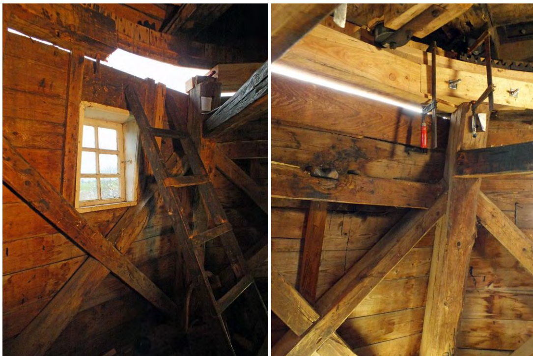
Detalj som visar hur hättans konstruktion fick öppnas för att möjliggöra renoveringen, byte av bockbuvudplankan. Utanpå bölet fanns tillfälligtvis en avsats, från vilken möllebyggarna kunde göra de exteriöra arbetena.
