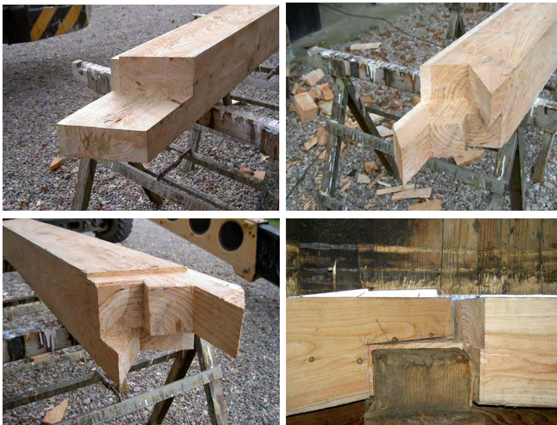
Ovan till vänster syns en blivande bockhuvudplanka. Ovan till höger syns samma plankan som nu har sågats till för att kunna kilas in i förhållande till ståndaren och den mötande bockryggspalken. Nedan till vänster syns samma plankan, som här vänts 180°. Nedan till höger syns hur viktigt det är att varje tillsågad vinkel på respektive bockhuvudplanka blir exakt rätt för att kunna få stabilitet i konstruktionen. Samtliga fyra foton har tagits av Bo Larsson, Föreningen Övraby mölla.
