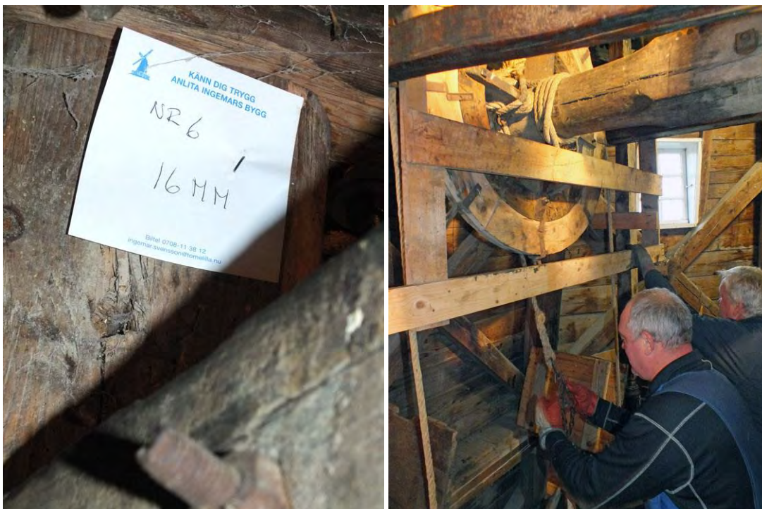
Till vänster en av flera lappar om hur mycket bockhuvudplankan skevade innan åtgärder med att få den i våg genomfördes. Då bockhuvudplankan består av totalt åtta plankor, gjordes många inmätningar. Till höger är möllebyggarna Ingemar Svensson och Stephan Malmberg i färd med att låsa hättans kronhjul inför arbetena i hättan.
