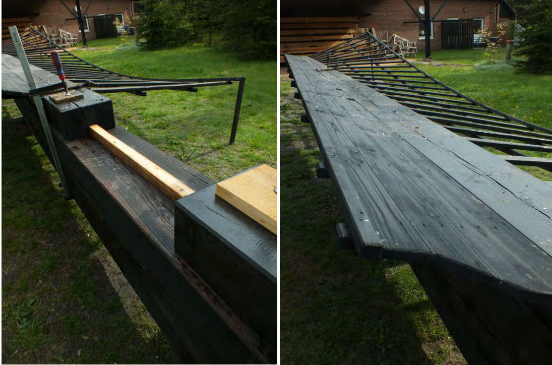
Till vänster nystruken vingbalk på tork. Till höger nystruken vinge med stormbräda och häckskeदार.
