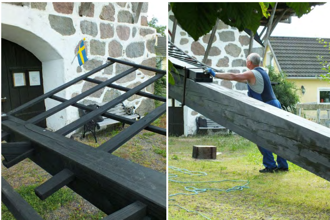
Till vänster detalj av vinge med bäckskedar. Till höger möllebyggaren Ingemar Svensson i samspråk med kollega uppe i möllan, för att tillsammans med kranföraren styra så att vingen hamnar i rätt läge.
