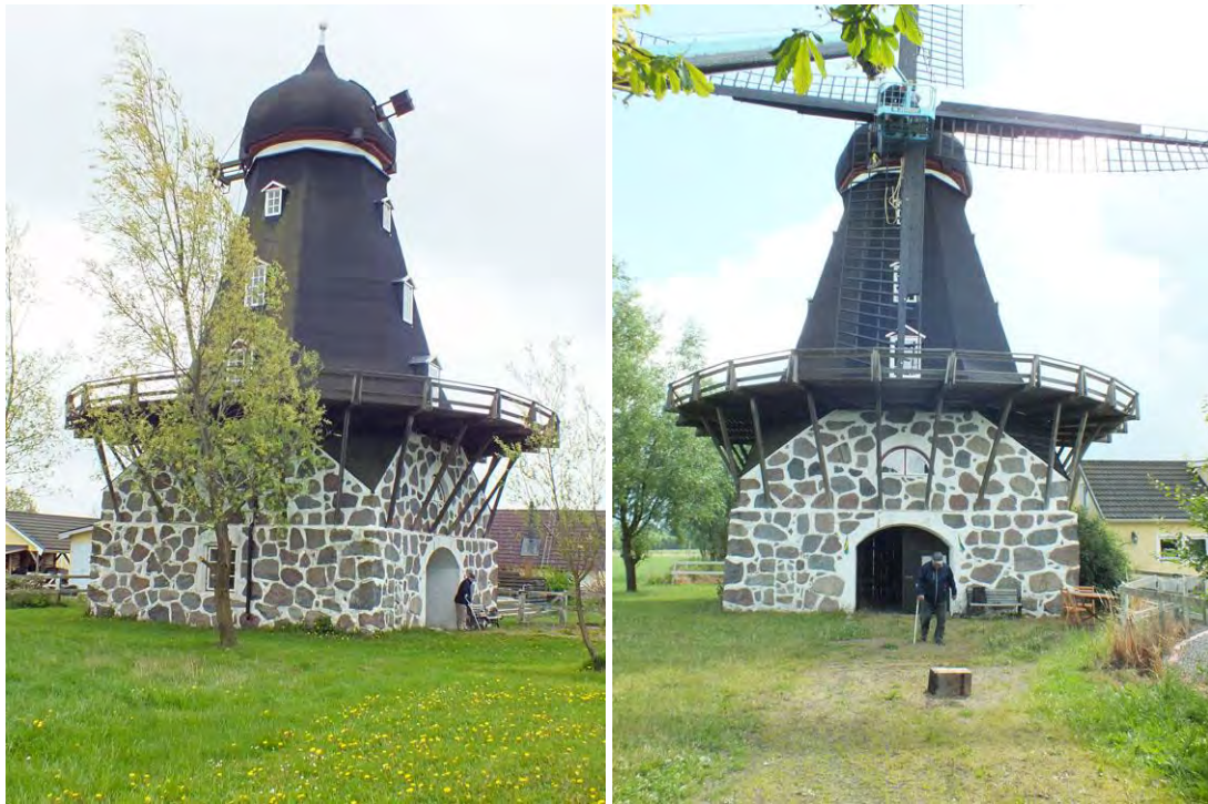
Fotot till vänster togs i början av maj, då Regionmuseet besökte möllan i samband med ett byggmöte. Fotot till höger togs den 2 juli när de fyra nytillverkade vingarna just hade monterats.
