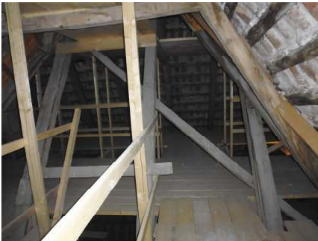
Västra slottslängans spångkonstruktion, sedd från anslutningen till södra slottslängan.
