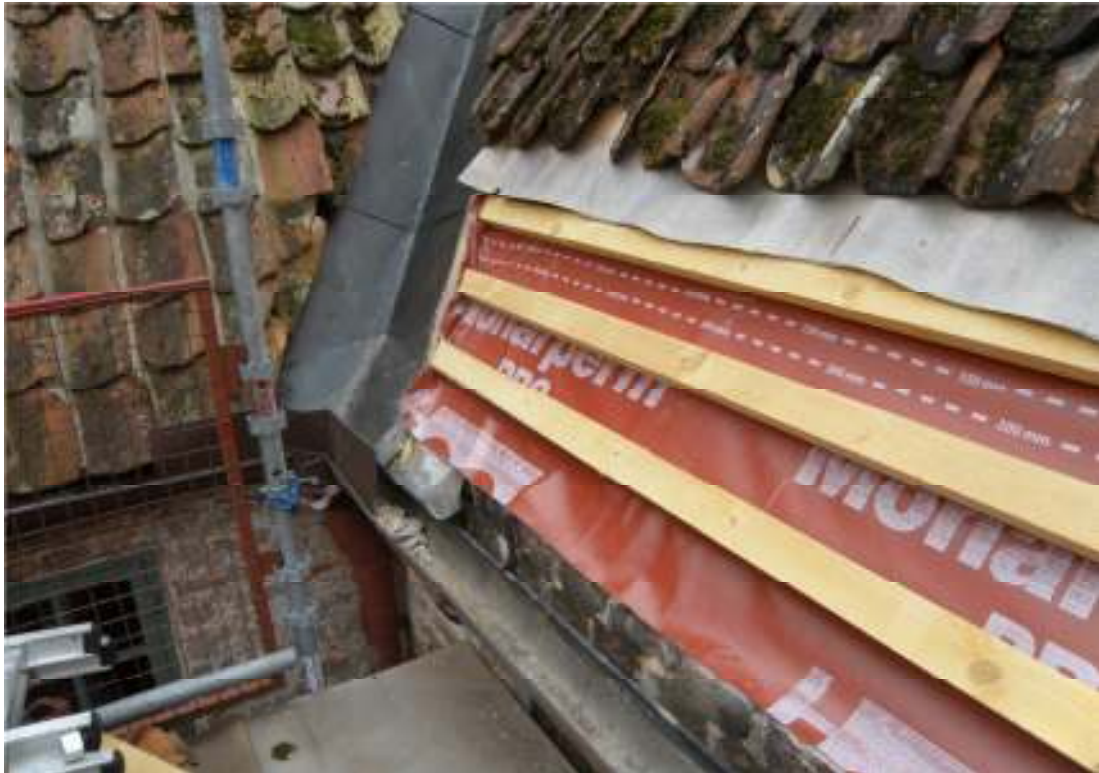
Fiberduken som skyddar takfoten mot inträngande vatten.
