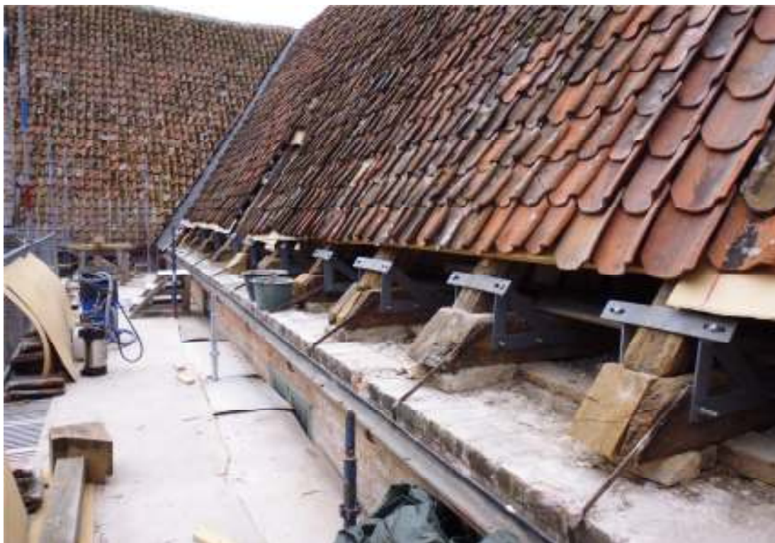
Västra slottslängan, östra takfallet. Samtliga sparrändar fixerade mot bindbjälkarna. Notera de smidda rännkrokarnas infästning i bjälkarna.
