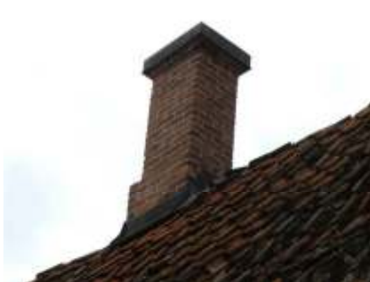
Södra skorstenen efter arbetet.
