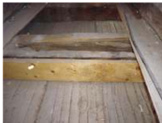
Förstärkt med påspikade reglar.
