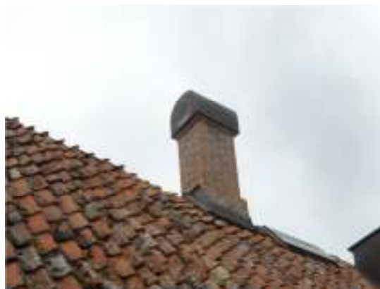
Norra skorstenen efter arbetet.
