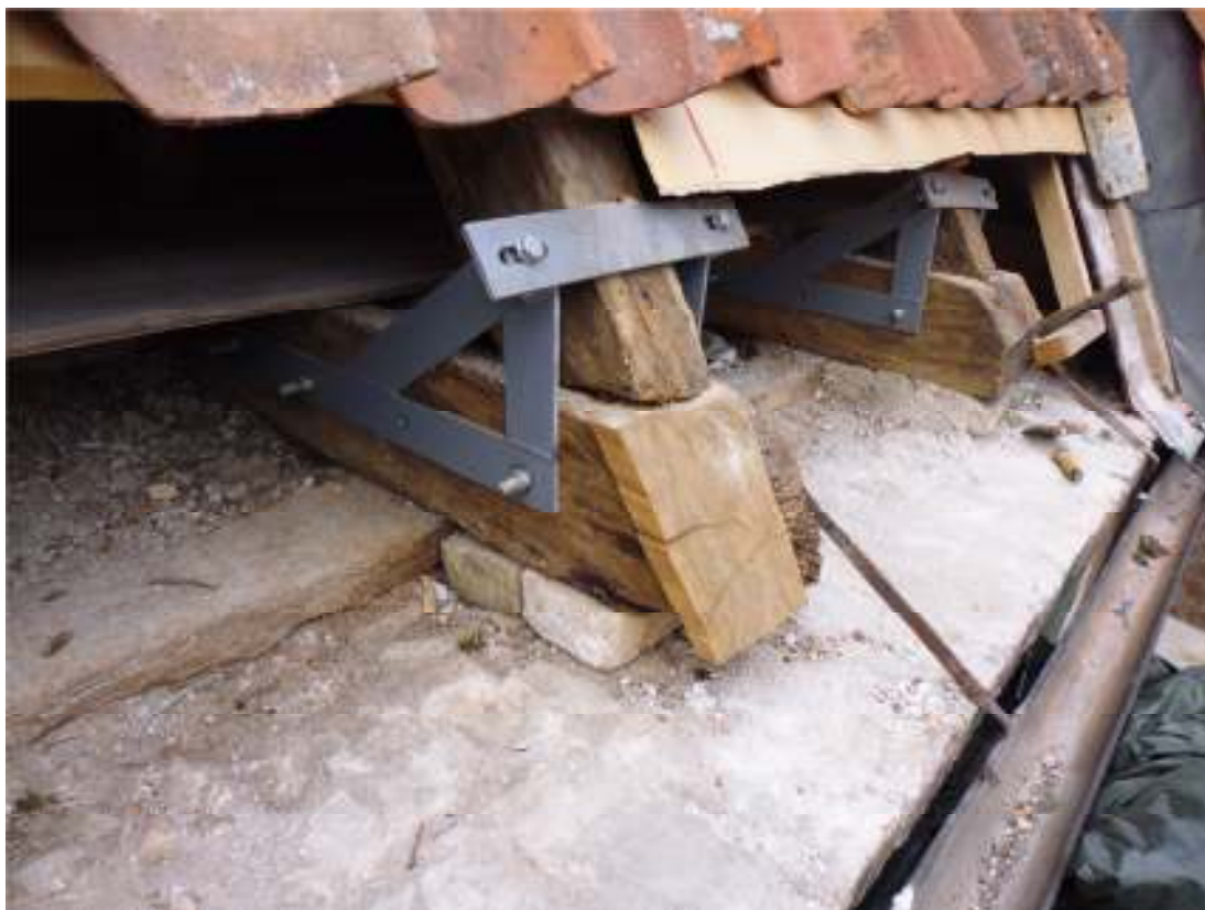
Säkring av sparrar/bindbjälkar på östra takfallet å västra längan. Notera iskarvad ekebit på den närmsta bindbjälkens ände.
