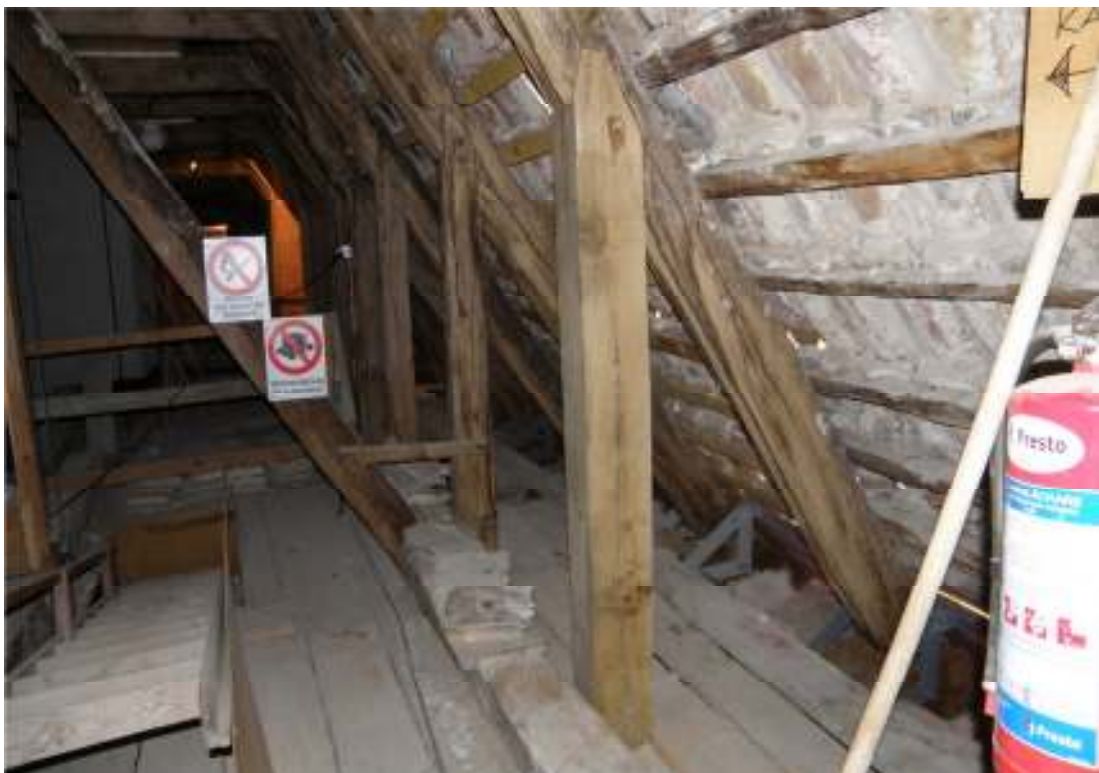
Nytt stödben av ek (mitt i bilden).
