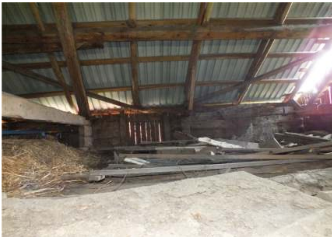
Bilder från före och efter förstärkningsåtgärderna på loftet samt i takkonstruktionen. Bilderna är tagna åt söder inne på loftet i den västra delen av byggnaden. Notera det blå spännbandet ovan till vänster i bild som på bilden nedan har ersatts av en vajer samt kompletterats med ytterligare en.
