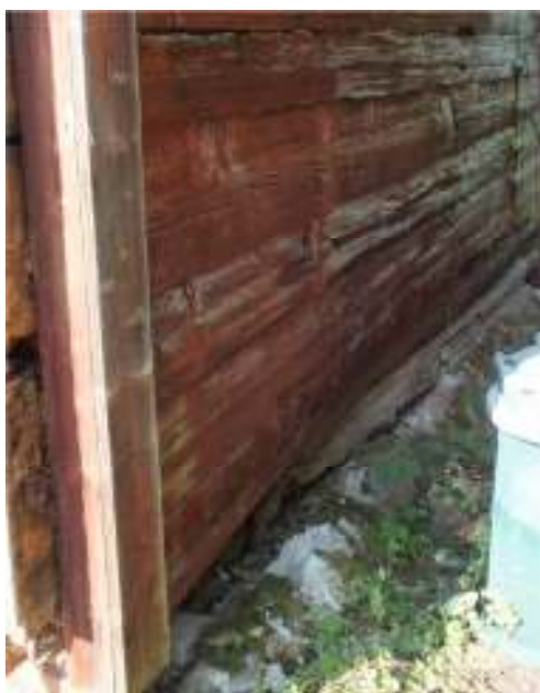
Detaljbild av fotträ och knutkedja i sydost följt av en bild över den östra kortsidan. Notera den kraftiga deformationen av de nedre timmervarven.
