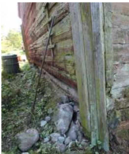
Detaljbild av fotträ och knutkedja i sydost följt av en bild över den östra kortsidan. Notera den kraftiga deformationen av de nedre timmervarven.
