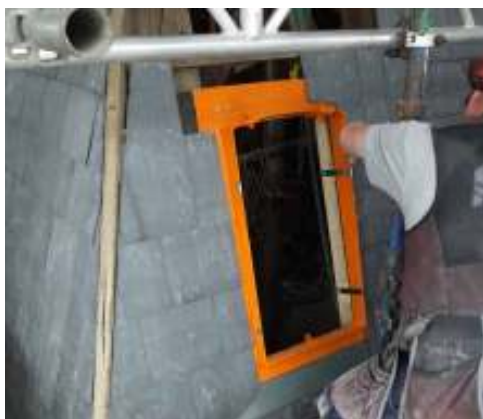
Ny taklucka på tornspiran utfördes med ny ram och plåtning. Notera ocksånockplåtens (plåten mellan takfallen) utförande.
