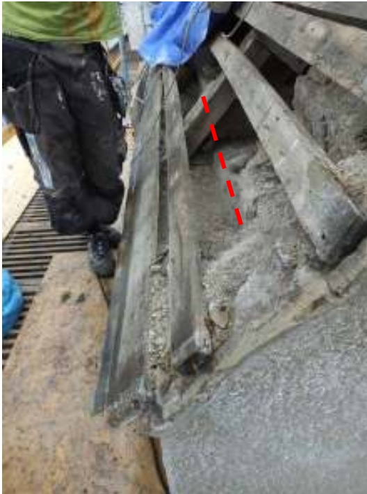
Röd linje anger insidans position för äldre förmodat remstycke. Till höger syns stickbjälkens sammanfogning med befintligt yttre remstycke av ek i södra kormurkrönet.
