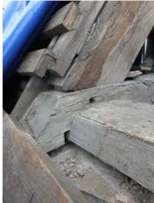
Röd linje anger insidans position för äldre förmodat remstycke. Till höger syns stickbjälkens sammanfogning med befintligt yttre remstycke av ek i södra kormurkrönet.
