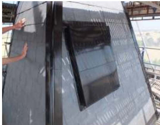
Ny taklucka på tornspiran utfördes med ny ram och plåtning. Notera ocksånockplåtens (plåten mellan takfallen) utförande.
