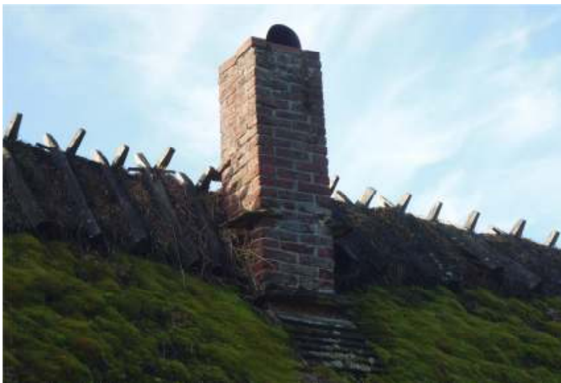
Fig. 3. Ryggningen kompletterad vid skorstenen på gården Per-Ols.
