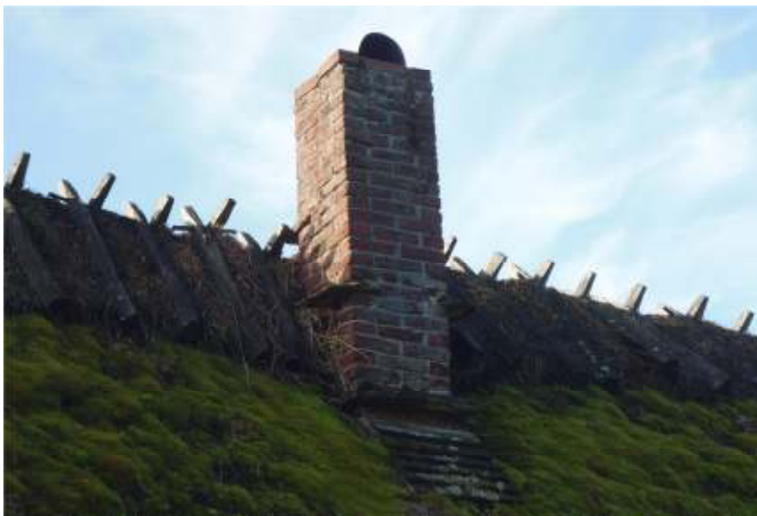
Fig. 3. Ryggningen kompletterad vid skorstenen på gården Per-Ols.
