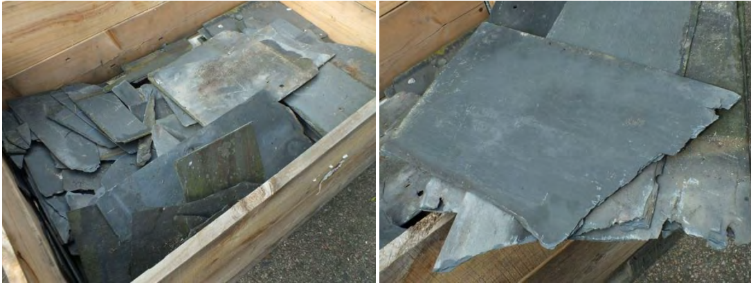
Entreprenören har tagit tillvara skifferplattor, för att bygga upp ett lager som kan användas vid kommande renoveringar.
