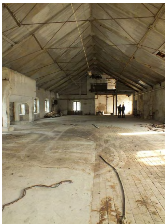
Överst till vänster har en del av holländeriets polonceau-takstol just skrapats och målats med rostskyddsfärg. Till höger syns samma parti efter avslutande målning i ursprunglig ljusgrå kulör. Under syns översiktsbilder inifrån holländeriet. Notera att golvet nu har torkat upp.
