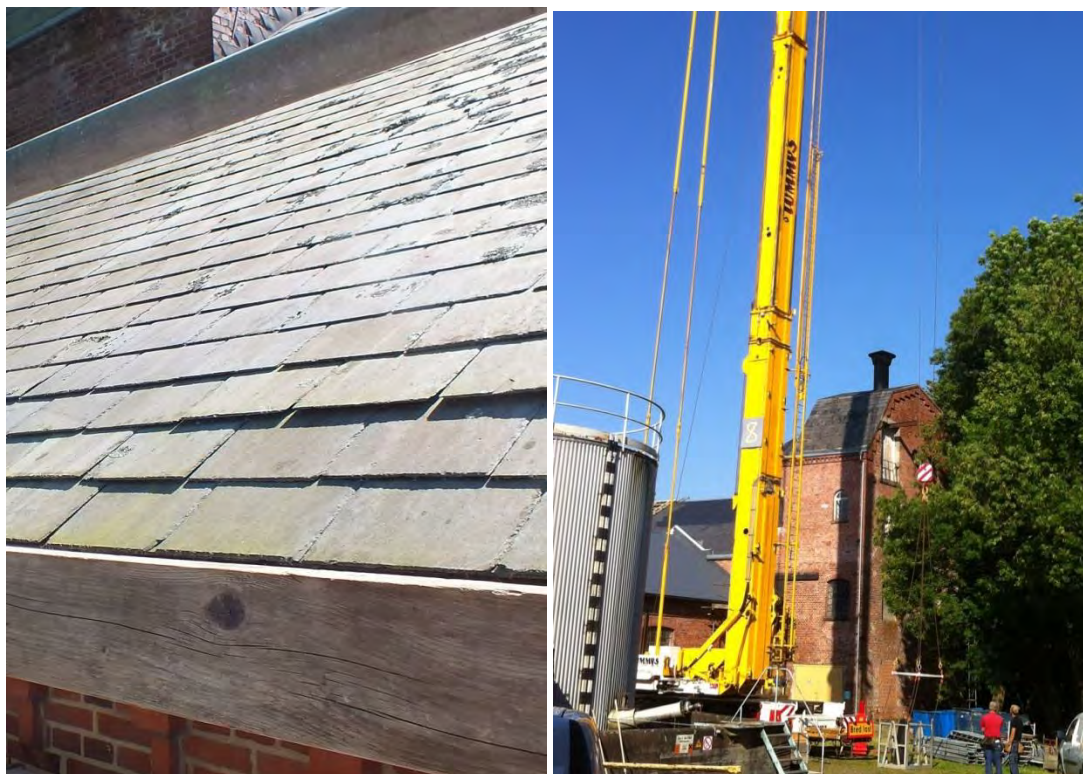
Skifferplattorna som ligger på brukets byggnader är omkring 8mm tjocka och måste hanteras varsamt för att inte knäckas. Vissa moment av takrenoveringen krävde hjälp av en kranbil. (Foto till höger taget av Thomas Gudmundsson, T. Gudmundssons Bygg.)
