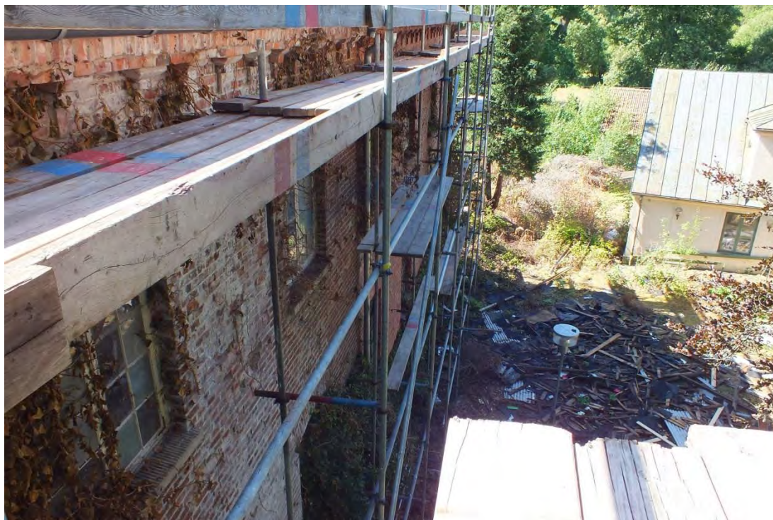
Lim- och hartstornet är högt men även holländeriet. Byggnadsställningen uppfördes i tre våningar.
