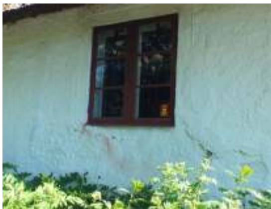
Den södra fasadens mellersta del. Vid ett av fönstren fanns ett större parti med bomsläpp. T. h. ses samma parti efter att nedknackning av putsen gjorts.
