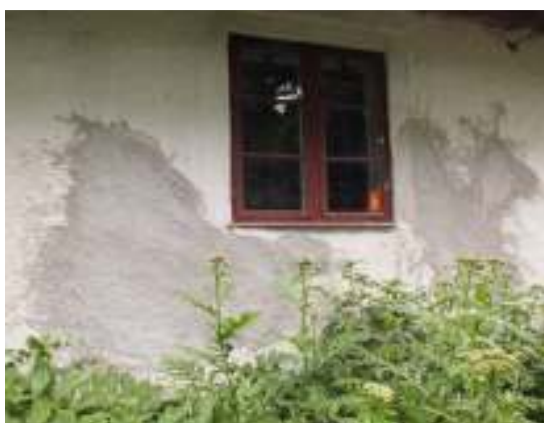
Den södra fasadens mellersta del. Vid fönstret (samma som ovan) gjordes två lite större lagningar. Ytan närmast fönstret brädrens liket tidigare utförande. T. h. ses samma fasad efter anfärgning.
