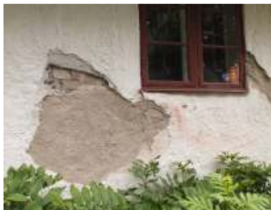
Den södra fasadens mellersta del. Vid ett av fönstren fanns ett större parti med bomsläpp. T. h. ses samma parti efter att nedknackning av putsen gjorts.
