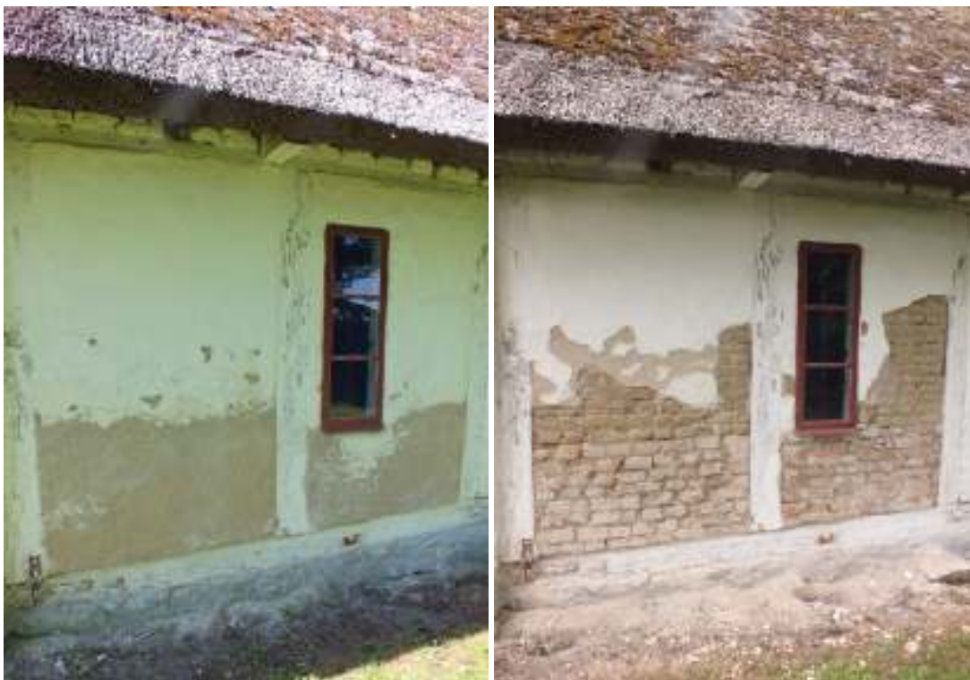
Norra fasadens korsvirkesdel. De två facken längst i öster var putsade med en puts som färgen inte fäste på varför den knackades ner så att stommens tegel och lersten blottades.
