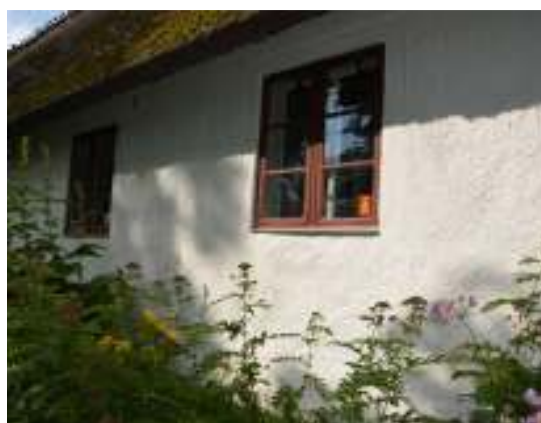
Den södra fasadens mellersta del. Vid fönstret (samma som ovan) gjordes två lite större lagningar. Ytan närmast fönstret brädrens liket tidigare utförande. T. h. ses samma fasad efter anfärgning.
