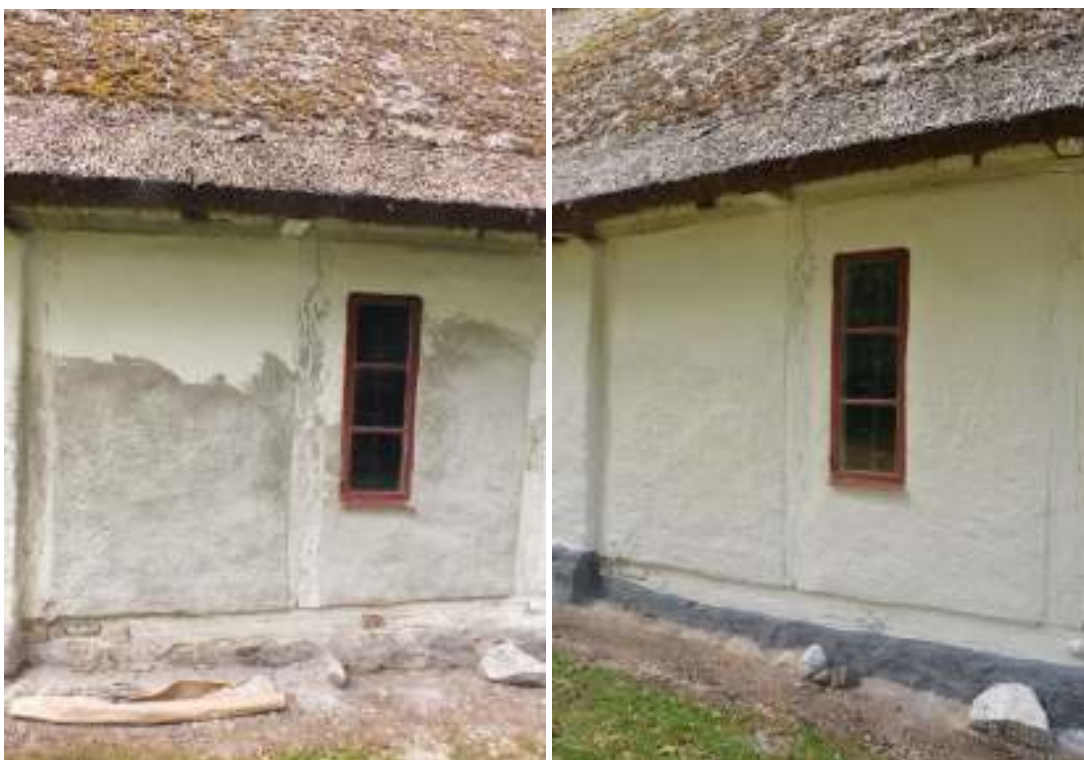
Norra fasadens korsvirkesdel. Facken putsades med kalkputs likt det tidigare utförandet och den omgivande putsen. Putsen kalkavfärgades sammanlagt sju gånger och grunden anvärgades två gånger med kimirök.
