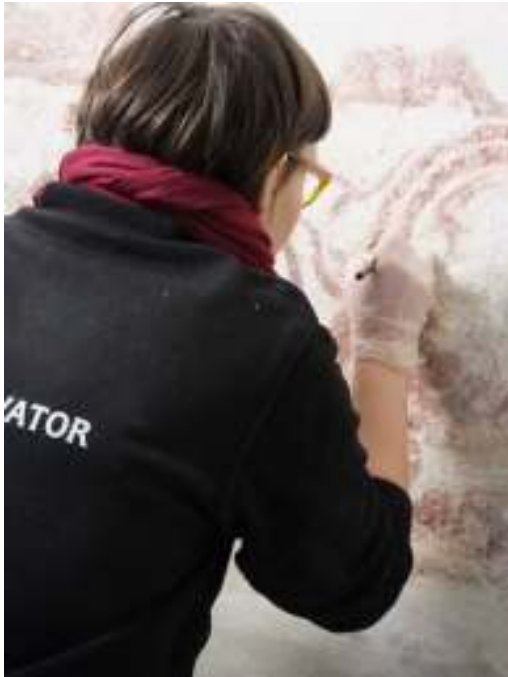
Bilden till vänster visar rengöring utav en av kalkmålningarna av Lilla Harriegruppen. Bilden till höger visar sprickbildning och mögelangrepp på kyrkans kalkputs.
