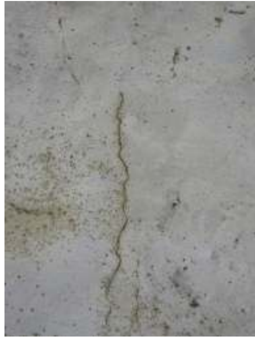
Bilden till vänster visar rengöring utav en av kalkmålningarna av Lilla Harriegruppen. Bilden till höger visar sprickbildning och mögelangrepp på kyrkans kalkputs.
