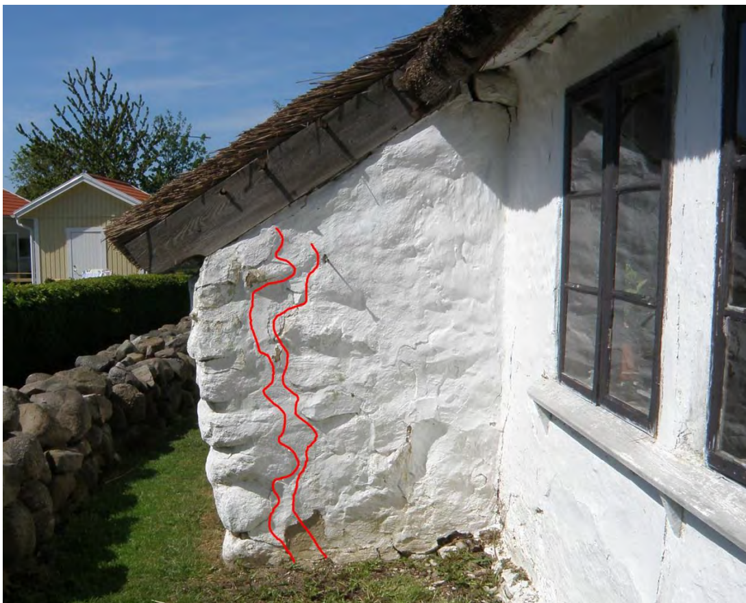
Fig. 5. Bakugnens östra sida. Röd markering visar exempel på område där stenmaterialet inte har någon större självbindande funktion.
