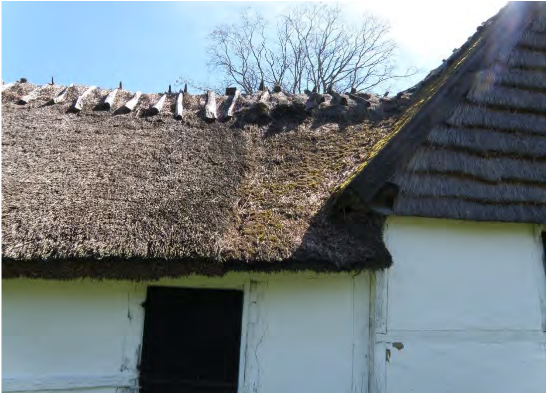
Fig. 6. Västra takfallets södra rännadal.
