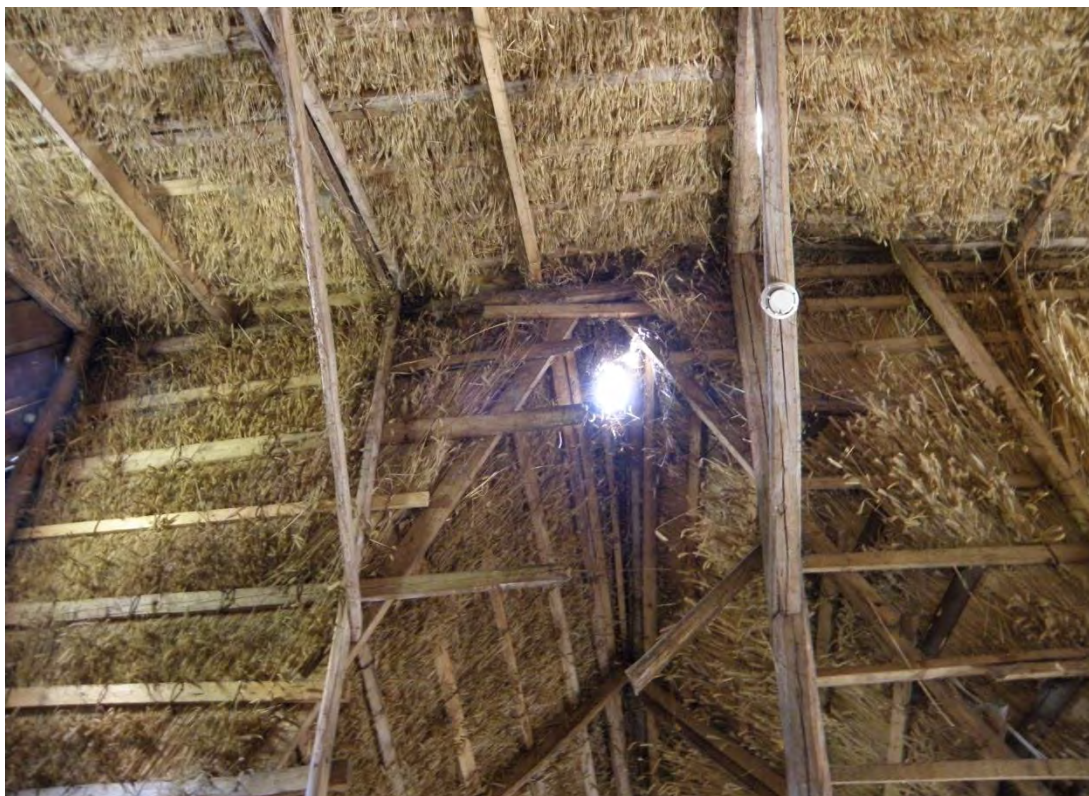
Fig. 9. Otätnock i vinkeln mellan norra- och östra längan.
