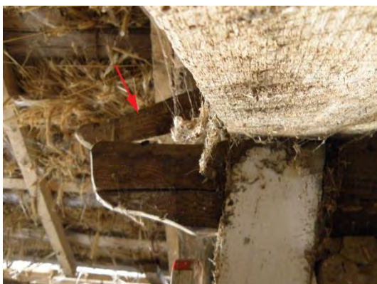
Fig. 12. Taktass i ursprungligt läge.
