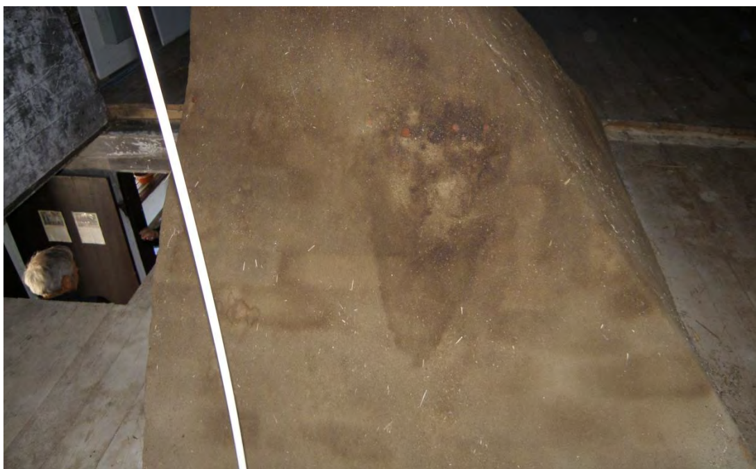
Fig. 4. Droppskador i lerputsens på murstockens västra sida.
