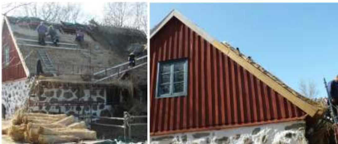
Bilderna visar pågående arbete med omläggning av det norra takfallet följt av en detaljbild av vindskivan sedan friskt virke har skarrats i.
