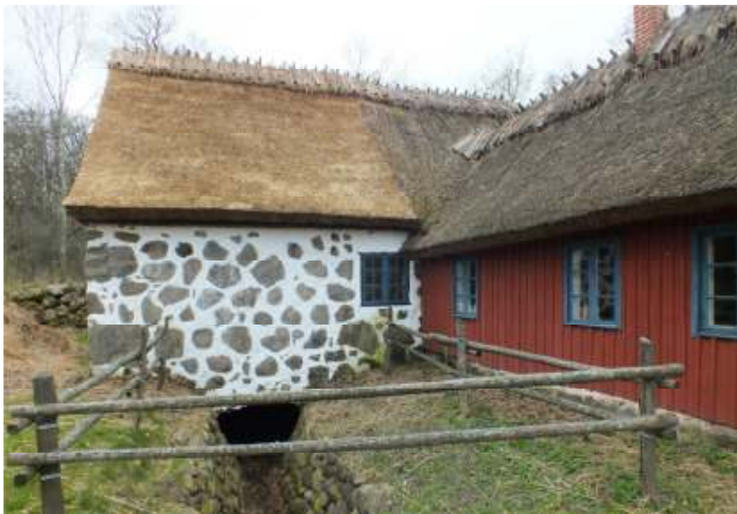
Kvarnbyggnadens norra takfall efter färdigställt arbete.
