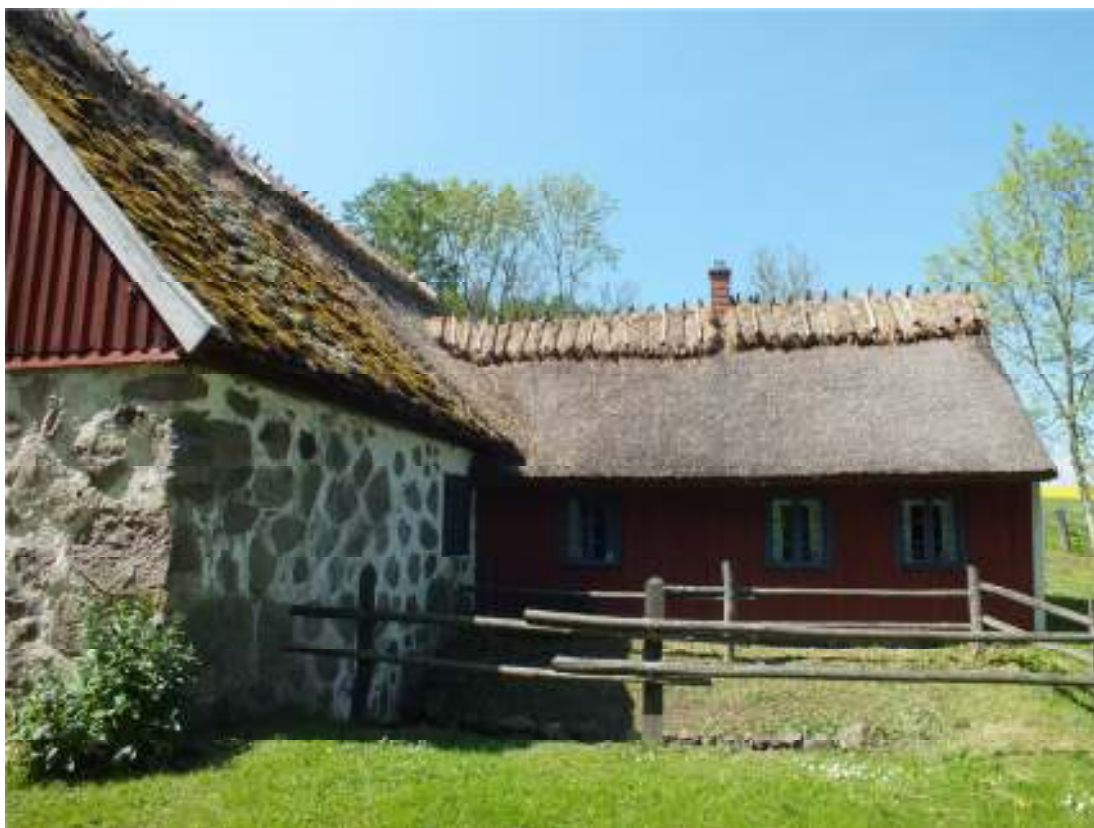
Vy mot väster med kvarnbyggnaden till vänster i bild och boningsdelen rakt fram. Notera den rika förekomsten av mossor på takfallet.
