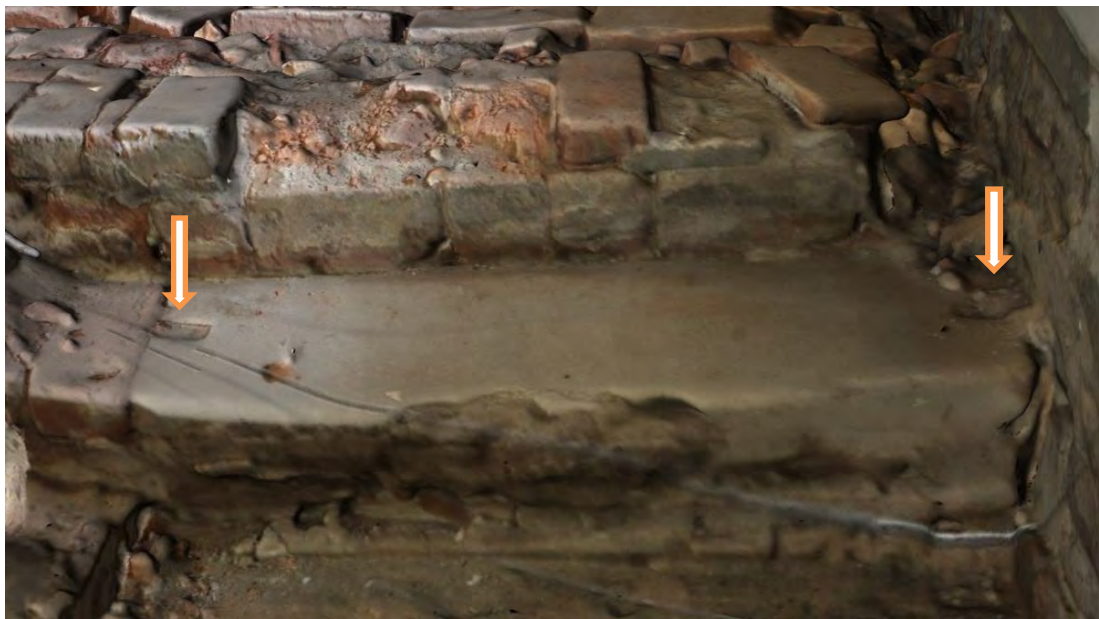
Fig. 11. Exempel på sandstensplattorna i trappnedgången. Notera urtagen på sidorna, vid pilarna. I de yttre kanterna finns knappt skönjbar räffelbuggning (syns enbart i släpljus).
