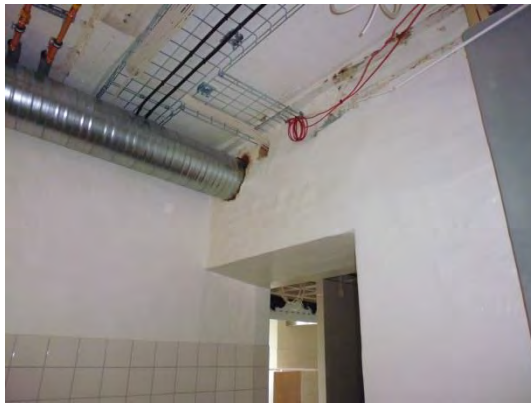
Fig. 3 och 4. Rörigenomförning i väggen mellan utrymmena Renseri och Rangering, före och efter taksänkningen. Muren vari röret går bedöms vara medeltida och har fram till cirka 1537–1685 utgjort södra gaveln i västra slottslängan.
