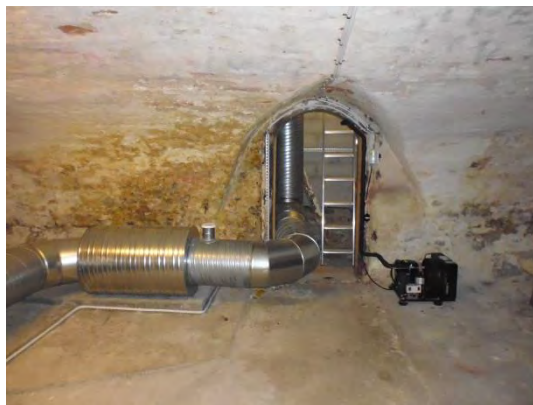
Fig. 2. Rörens sträckning ut ur källaren.
