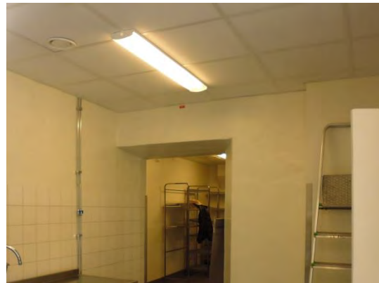
Fig. 3 och 4. Rörigenomförning i väggen mellan utrymmena Renseri och Rangering, före och efter taksänkningen. Muren vari röret går bedöms vara medeltida och har fram till cirka 1537–1685 utgjort södra gaveln i västra slottslängan.
