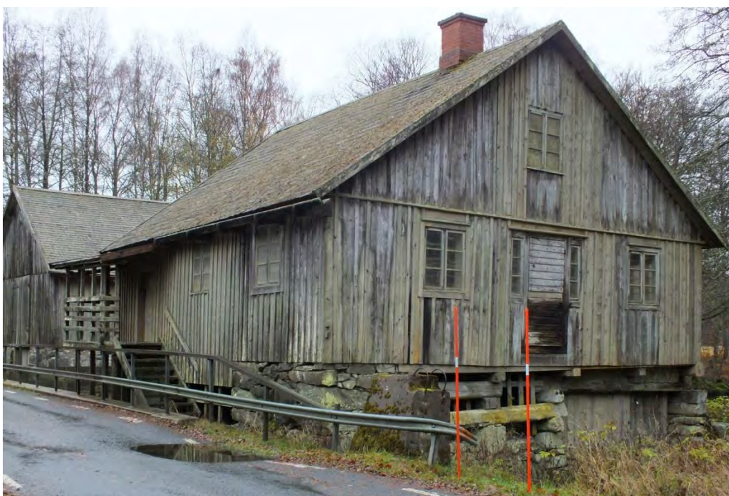
Det nordöstra takfallet innan arbetena påbörjades.
