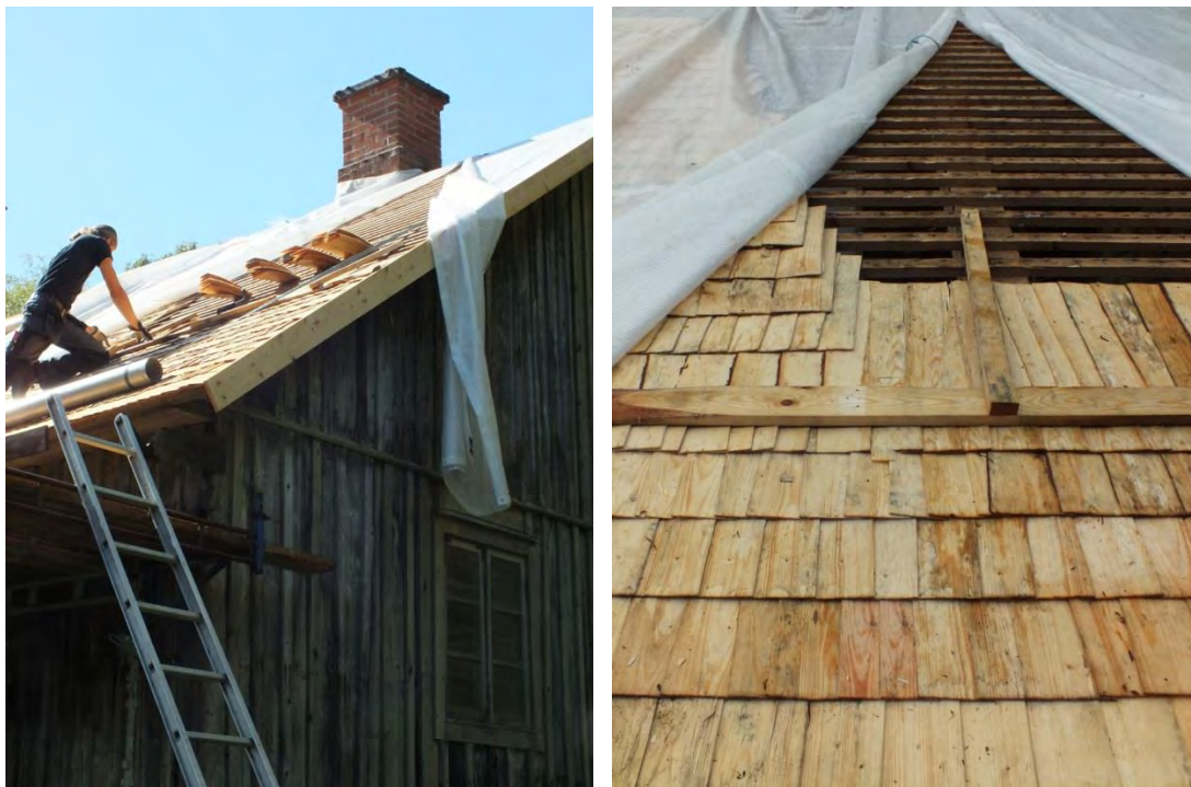
Bilderna visar det nordöstra takfallet under pågående arbete.
