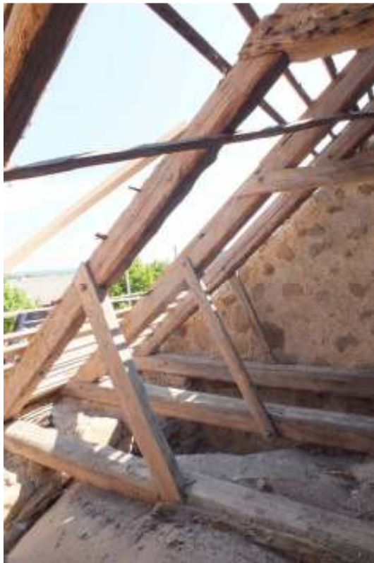
Takstolarna i koret sett från väster, den vänstra bilden mot norr och den högra mot söder. På norra takfallet var stormläkten kvar.
