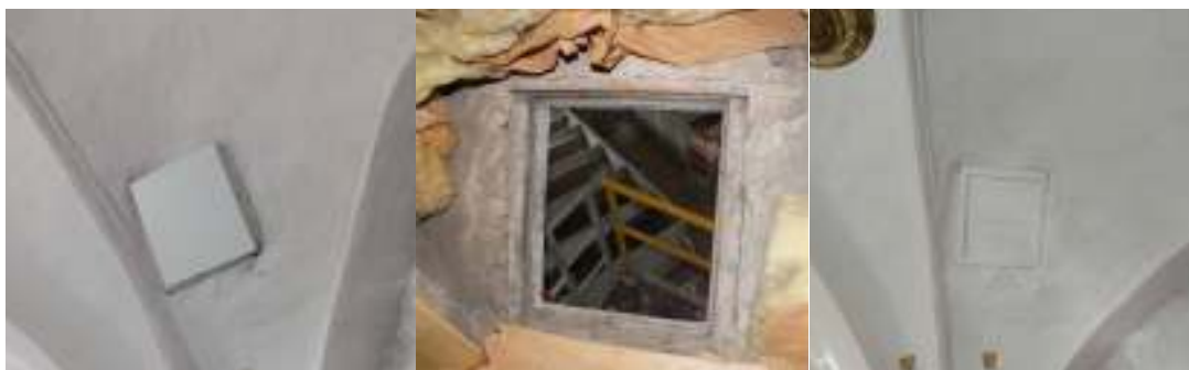
Takluckan till vinden, belägen i långhusets mittersta valtravés nordvästa valsvickel bestod före renoveringen av en träskiva som satt skruvad till en träram. Den befintliga luckan togs bort och ersattes av en ny som öppnas mot vinden. Till höger syns den gamla luckan, i mitten öppningen sedd från vinden och till höger den nya luckan sedd från långhuset.
