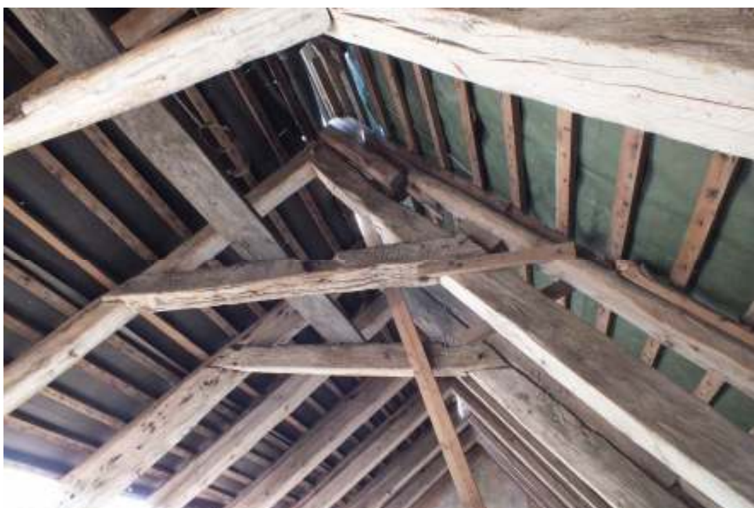
Takstol 9, 10, övre banband sett från öster. Äldre förtagning syns i 9:e banbandet. Lägg märke till den kraftiga påsalningen på norra sidan (högre sparren). Påsalningen förstärktes och bättrades i hela taklaget där så behövdes.
