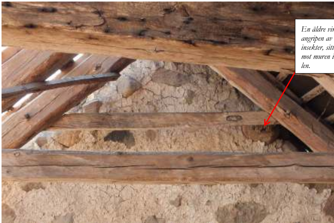
Korets övre hanband sett från väster. Hanbanden i tredje och första takstolarna från öster var av återanvänt virke.
