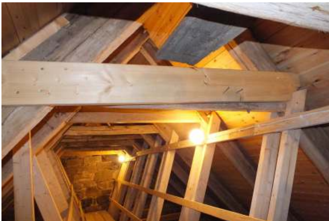
Övre hanband i takstol 7, förstärkt med en bräda.
