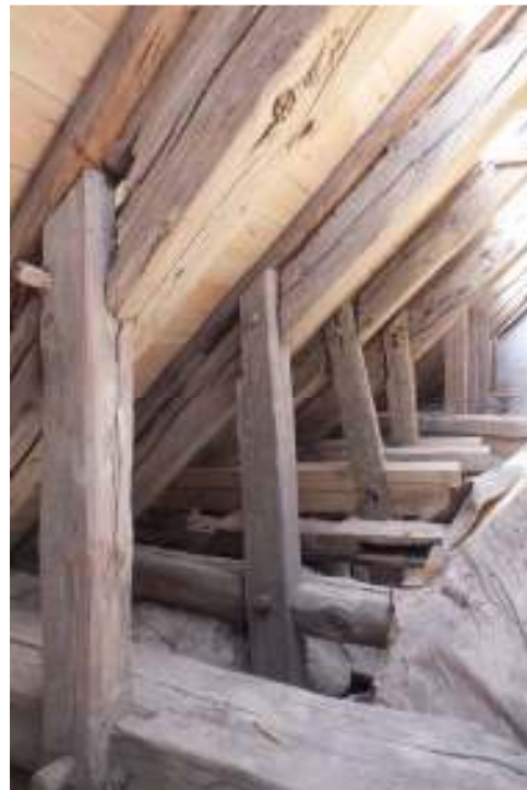
Till vänster: hanbandet i takstol 8 efter förstärkning med brädor. Till höger: takstolarna 7-10 södra takfallet med sjunde takstolens stödben och stickbjälke närmast i bilden.
