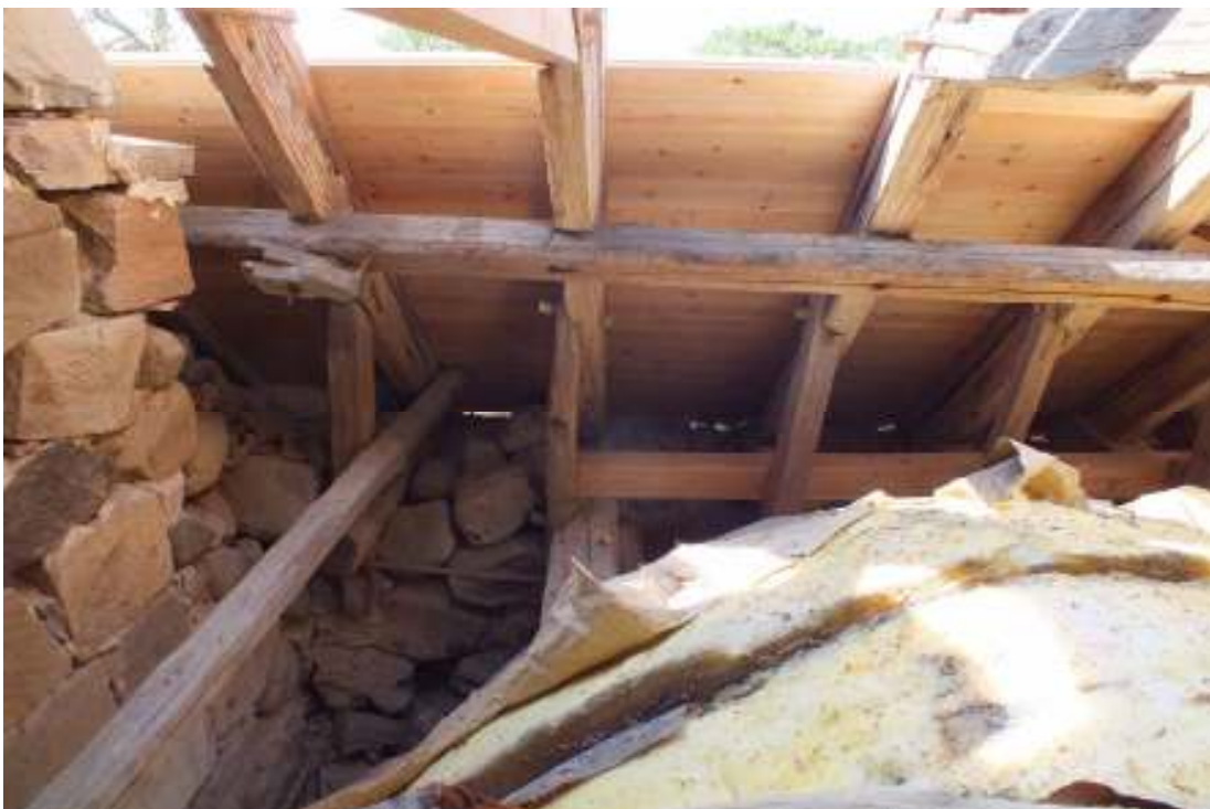
Takstolarna 1-4 i södra takfallet (takstol 1 längst till vänster i bild).
