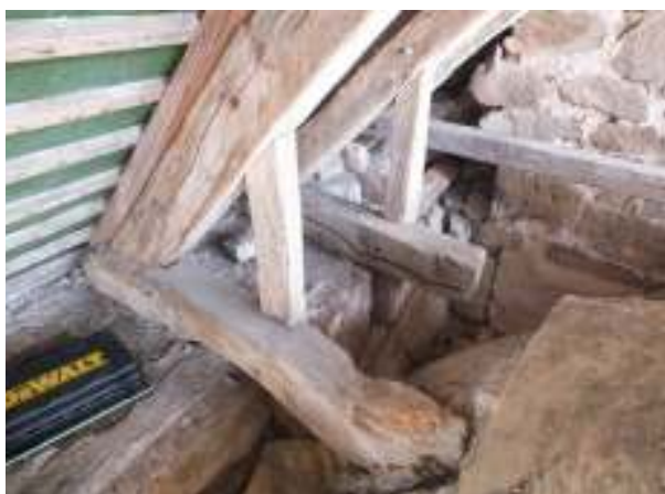
Takstolarna 1-3 norra takfallet, från väster. Före utförda åtgärder.
