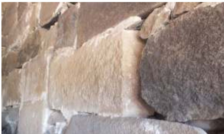
Långhusets gavlröste mot öster är uppmurat av återanvänd, kvaderbuggen sandsten med tydliga stenbuggarmärken.
