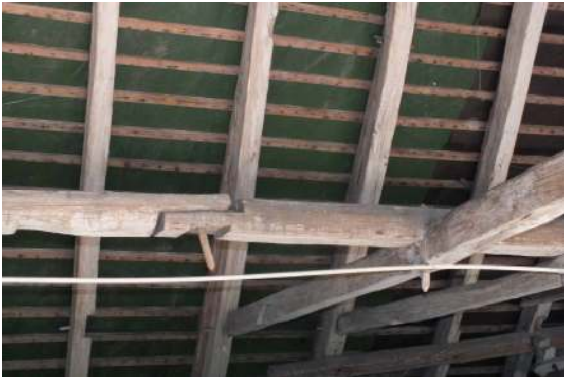
Hanbandet i 5e takstolen saknades men ett nytt fogades samman med takstolen och dymlades samman med styrbjälken. Bilden visar styrbjälken innan hanbandet är monterat. Sett från söder.
