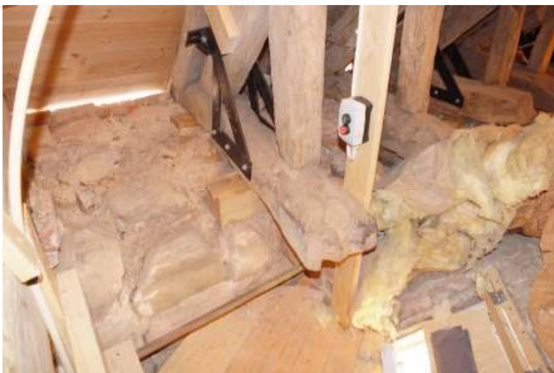
Förstärkning gjordes på norra sidan med järn i stickbjälken 10, närmast. Bakom takstol 9 skymtar takstol 8, också järnförstärkt. Nederst i bild syns den nya luckan till vinden och en liten plattform som ordnades framför luckan.
