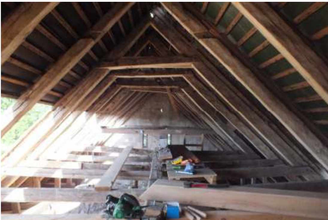
Långhusets taklag sett från öster. Taklagsrenoveringen skedde under mycket goda väderförhållanden under tidig sommar med mycket sol och värme och få regniga dagar.
