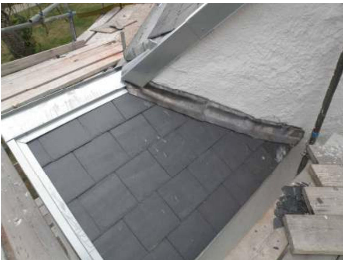
Samma vy efter omtäckning med ny skiffer och ny plåt. Blyplåt lades intill korets mursida. Vindskivor ochnockplåt har fått ett annorlunda utseende.
