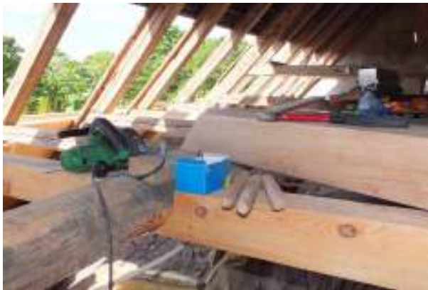
Hanbandet i 5e takstolen saknades men ett nytt fogades samman med takstolen och dymlades samman med styrbjälken. Bilden visar styrbjälken innan hanbandet är monterat. Sett från söder.
