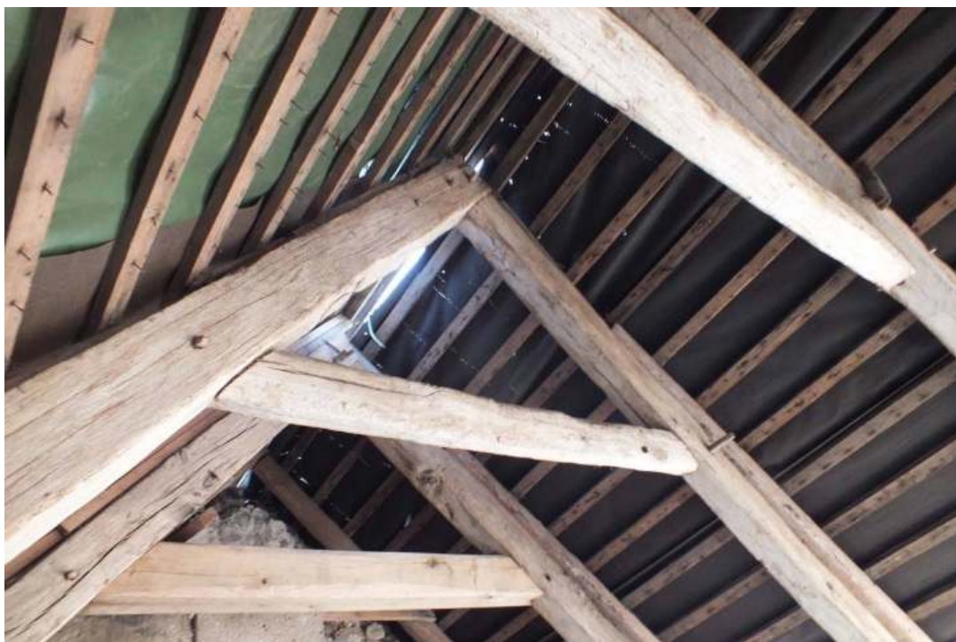
Övre hanband i takstolarna 1-3. Takstol 1 kompletterades med nytt hanband.
