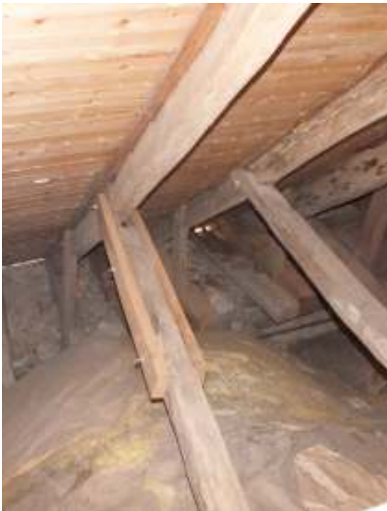
Till vänster: hanbandet i takstol 8 efter förstärkning med brädor. Till höger: takstolarna 7-10 södra takfallet med sjunde takstolens stödben och stickbjälke närmast i bilden.
