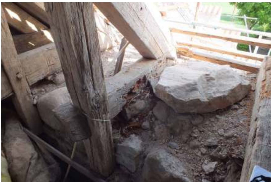
Sticbjälkar, stödben i takstol 6 och 7 (längst bak) norra takfallet.
