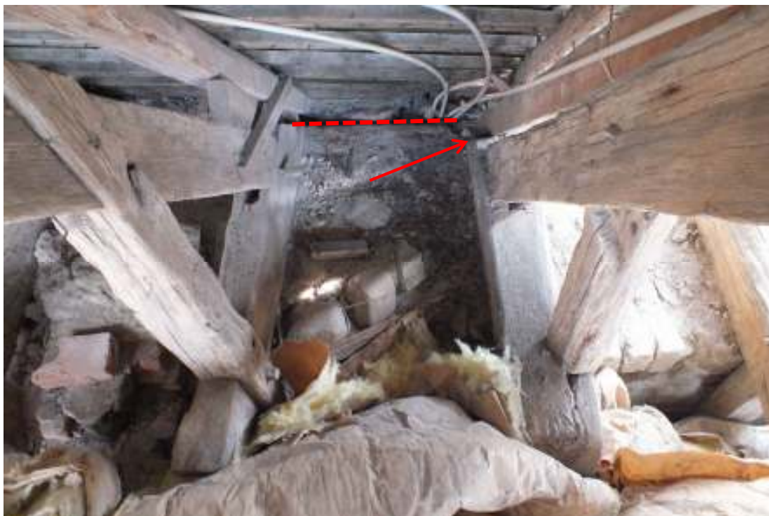
Bilden visar murkrönet sett ovanifrån i takstolarna 8 och 9, norra takfallet. Streckad linje visar ett remstyckes ytterkant mot norr. Pilen anger sticbjälkens nuvarande placering innanför remstyckets ytterkant.
