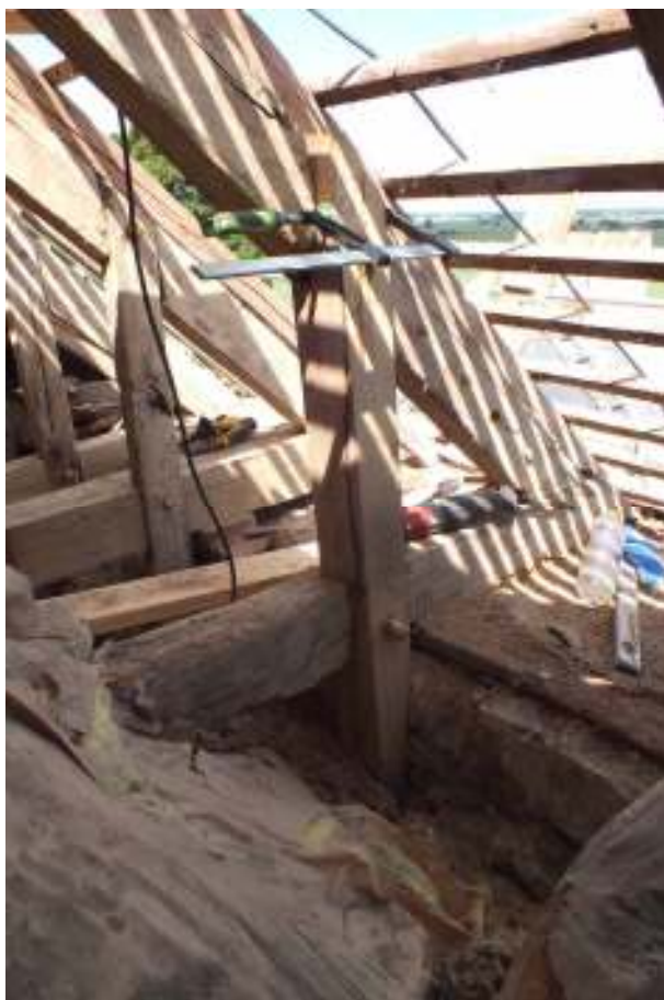
Nytt stödben fogades till den fjärde takstolen, norra takfallet.
