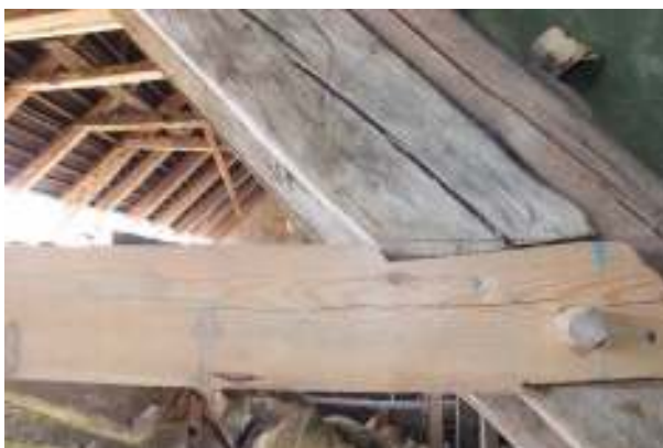
De två nedre bilderna visar nytt hanband som fogades till takstol 5 där hanband saknades. Hanbandet fogades till styrbjälken (mittenbild).
