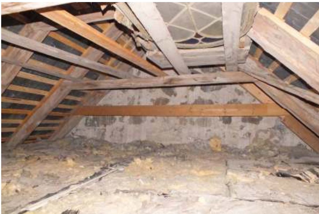
Vapenhusvinden, vars tak av skiffer och plåt ligger på öppen läkt, bilden visar vinden sedd från norr. I den inre takstolen, mot långhussidan, byttes en sparre ut och kompletterades därefter med ett hanband.
