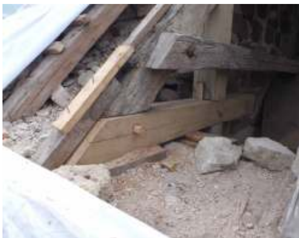
Ny stickbjälke och stödben norra takfallet, takstol 1.
