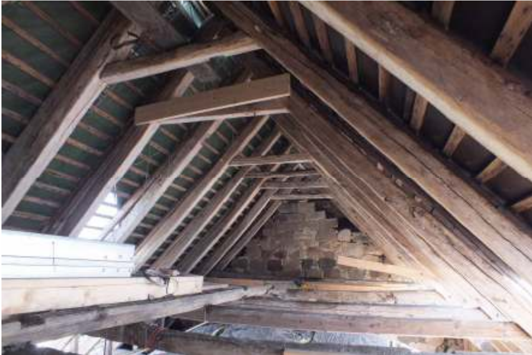
Långhusets taklag sett från 8:e takstolen, från väster.
