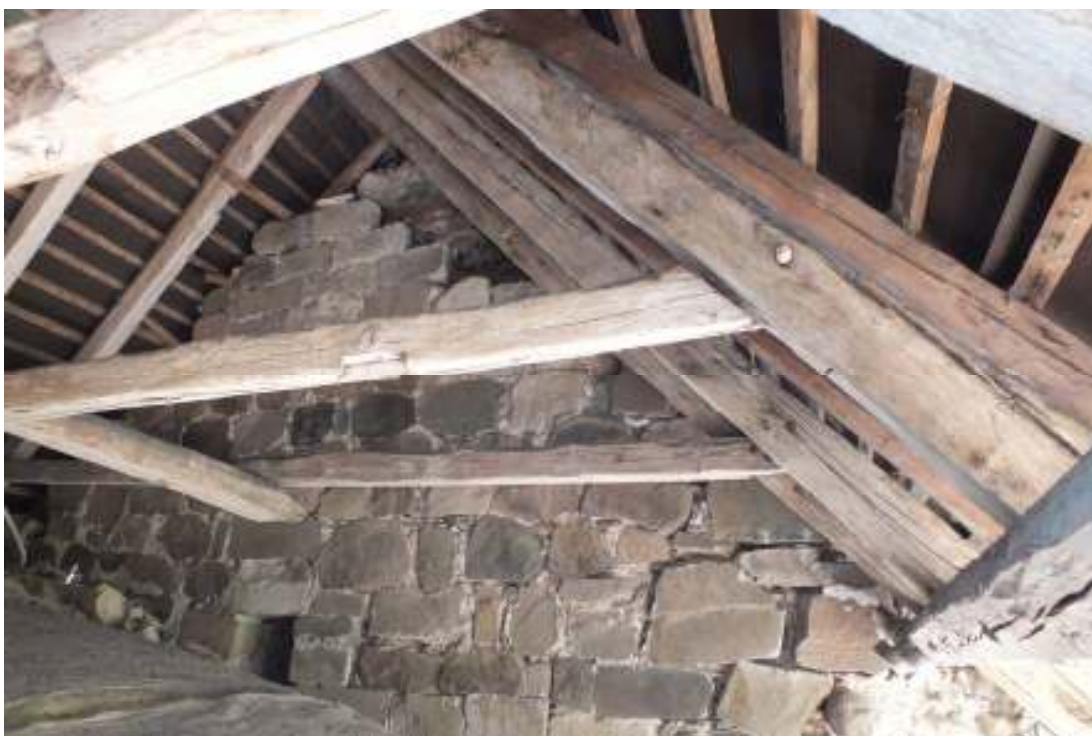
På nedre banbandet i takstol 3 syntes äldre urtag från väster.
