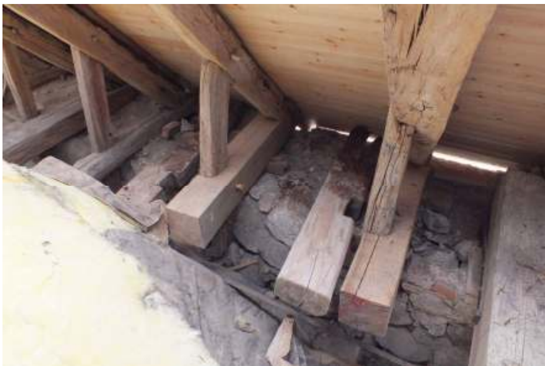
Takstolarna 9 och 10 sett mot söder. Båda stickbjälkarna på södra sidan byttes.
