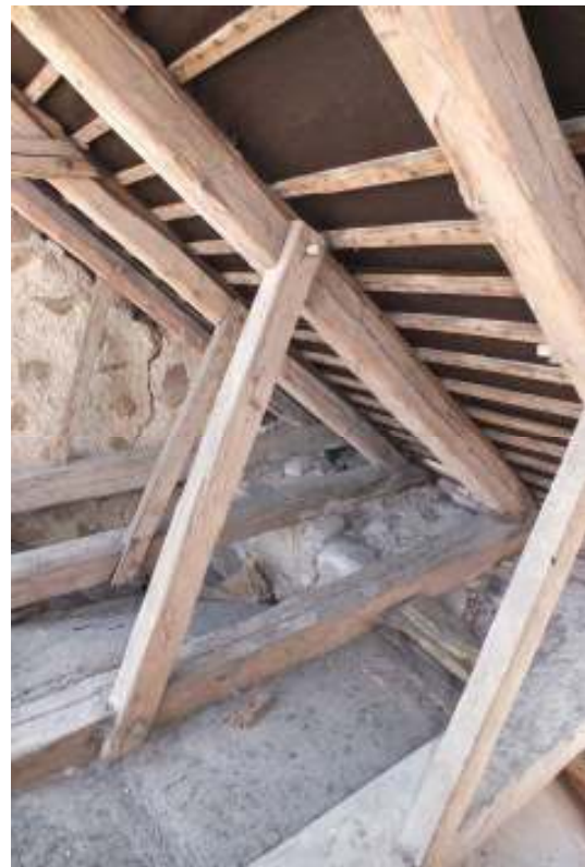
Takstolarna i koret sett från väster, den vänstra bilden mot norr och den högra mot söder. På norra takfallet var stormläkten kvar.
