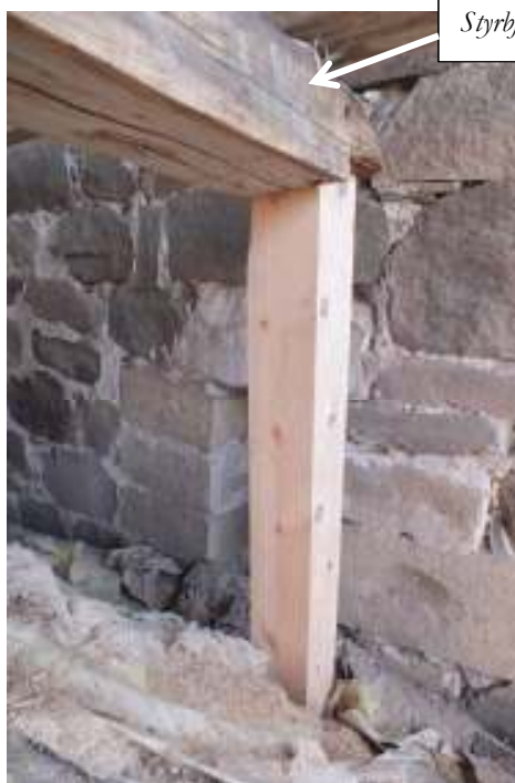
En stolpe placerades på en muravsats under första takstolens hanband och störbjälken som extra stöd.
