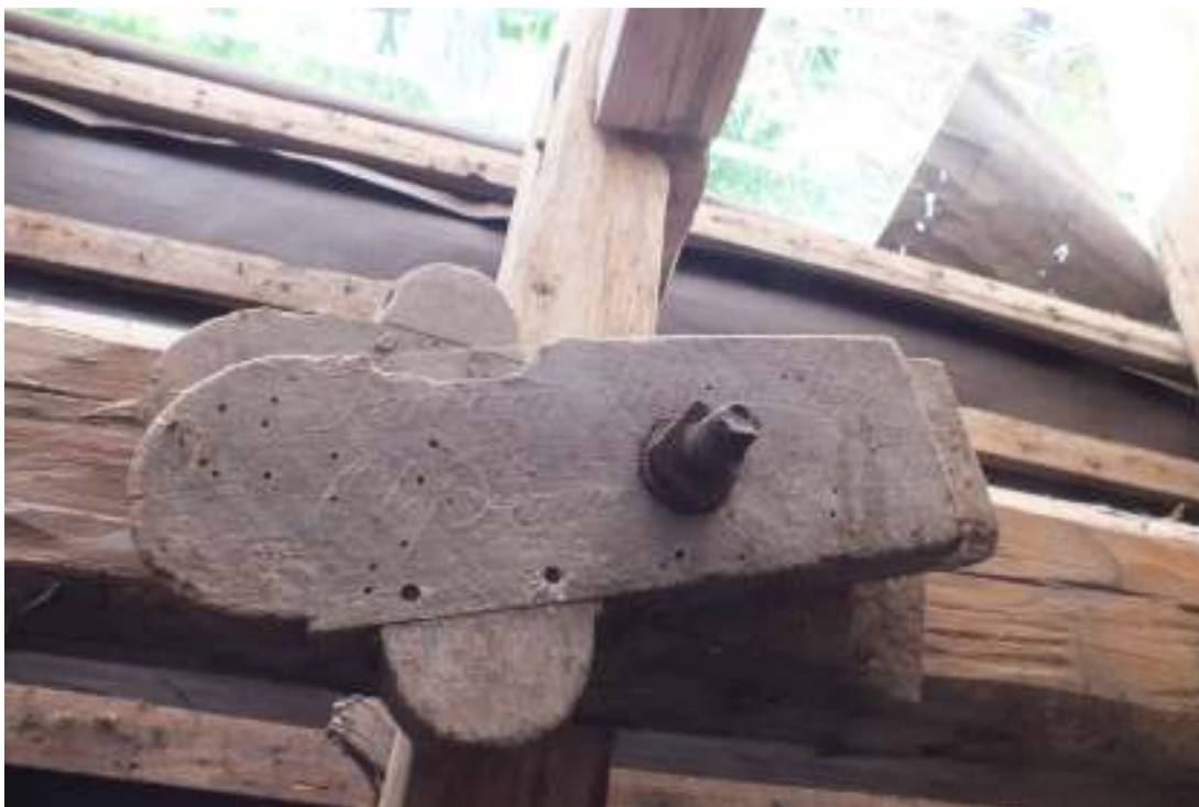
Gravkors har återanvänts i långbusets östra takstol. På den södra finns inskriptionen: "förvaras stoftet af Swen Olof Swensson född Östra Ka...".
