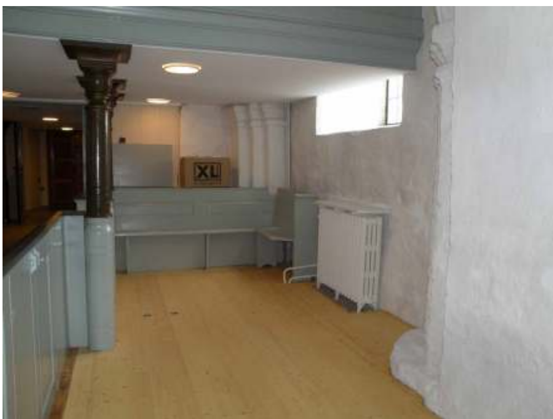
I västförlängningens norra sida lades nytt golv och bjälklag och bänkar togs bort. Golvet lutades, oljades och polerades.
