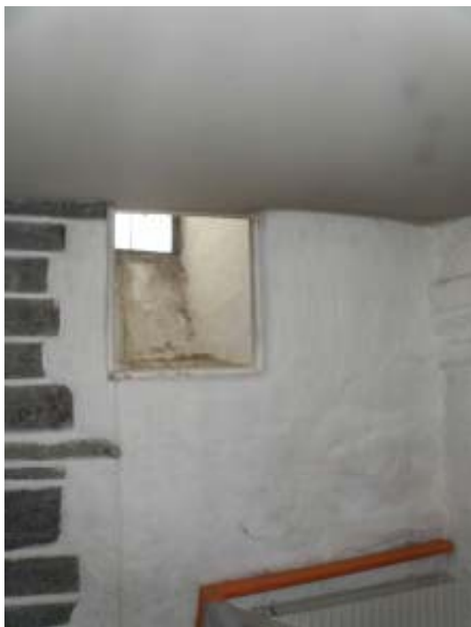
Kraftigt smutsad fönsterbänk i södra fönsteröppningen i västförlängningen. I valvet över orgelläktaren hade kanter klätts med väv för att hålla ihop putsen.
