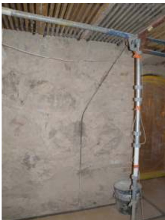
Väggarna i långhuset rensades från puts och putsades om. Murverket består av stora gråstenar med mindre skolsten. Öppningar är murade med tegel. Endast putsen på yttermurar rensades.
