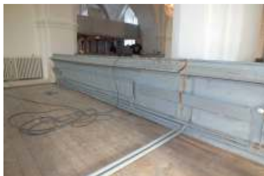
Till vänster syns golvbjälklag i västförlängningen samt till höger nytt golv i korsarmen.
