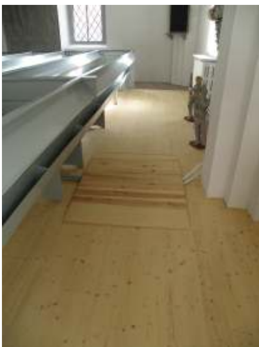
Till vänster: ramp tillverkades över rördragning i södra korsarmen. Till höger syns radiatorer med filter monterade på befintliga radiatorskyddskonsolerna.
