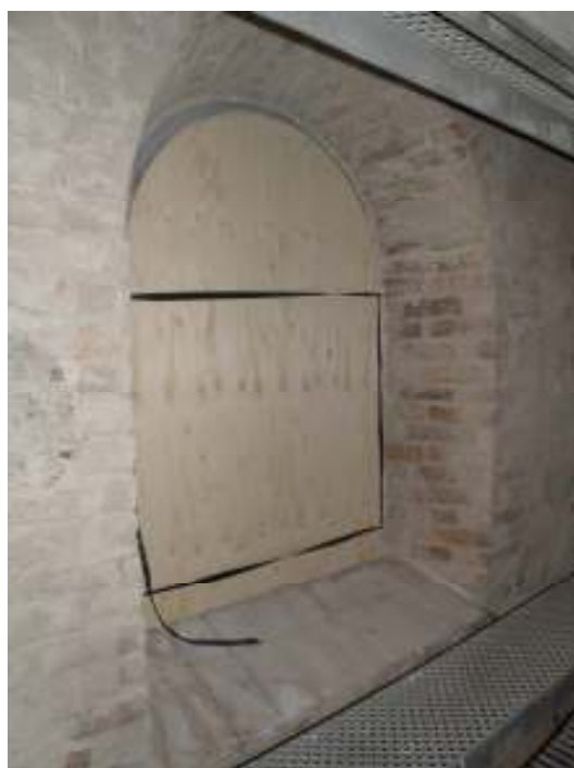
Väggarna i långhuset rensades från puts och putsades om. Murverket består av stora gråstenar med mindre skolsten. Öppningar är murade med tegel. Endast putsen på yttermurar rensades.
