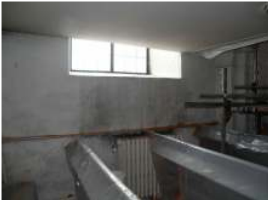
Bild till vänster: Väggarna framför allt under fönstren i västförlängningen var smutsade och här hade också kondens från fönstren orsakat rinningar på väggen. Bild till höger: lokalt fanns mindre sprickor i valven över långhuset.
