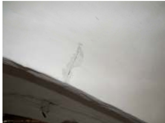
Bild till vänster: Väggarna framför allt under fönstren i västförlängningen var smutsade och här hade också kondens från fönstren orsakat rinningar på väggen. Bild till höger: lokalt fanns mindre sprickor i valven över långhuset.
