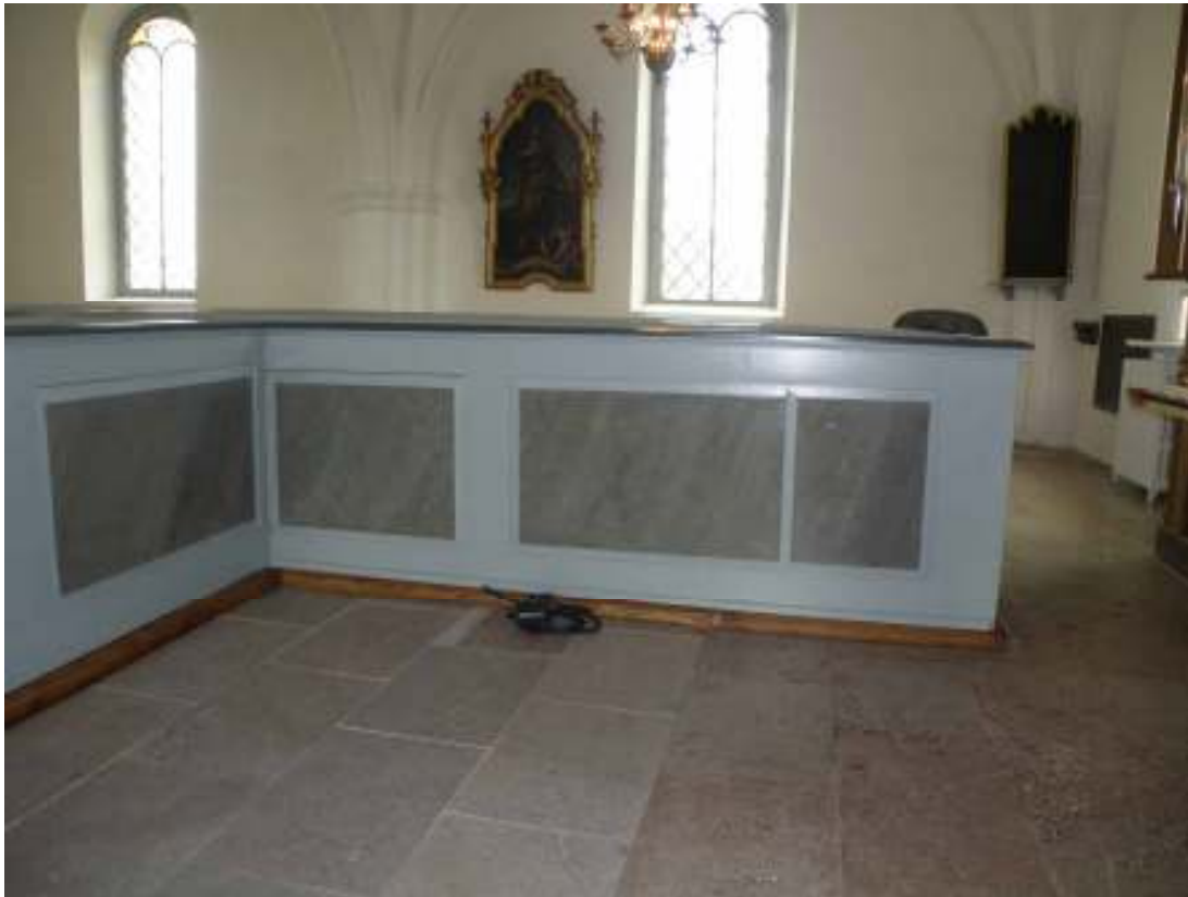
Bänkvarteret sett från söder. Spegelarna mot norr var inte marmorerade då dessa tidigare varit bakom bänkrader som tagits bort under tidigare renoveringar, senast 2012. Dessa marmorades i enlighet med övriga speglar.
