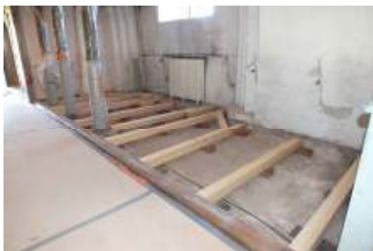
Till vänster syns golvbjälklag i västförlängningen samt till höger nytt golv i korsarmen.
