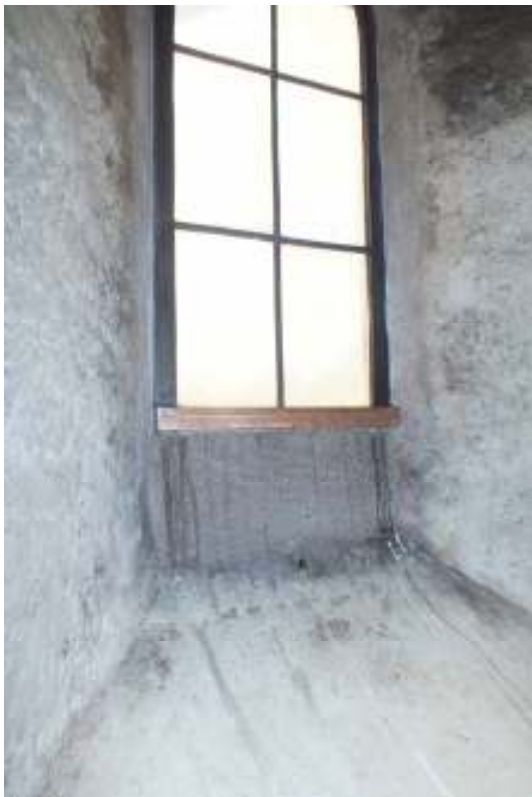
I koret sattes också upp kondensrännor i kopparplåt.
