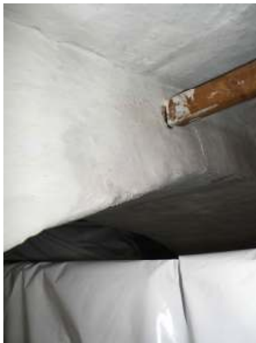
Kraftigt smutsad fönsterbänk i södra fönsteröppningen i västförlängningen. I valvet över orgelläktaren hade kanter klätts med väv för att hålla ihop putsen.
