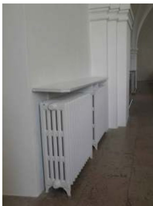
Till vänster: ramp tillverkades över rördragning i södra korsarmen. Till höger syns radiatorer med filter monterade på befintliga radiatorskyddskonsolerna.
