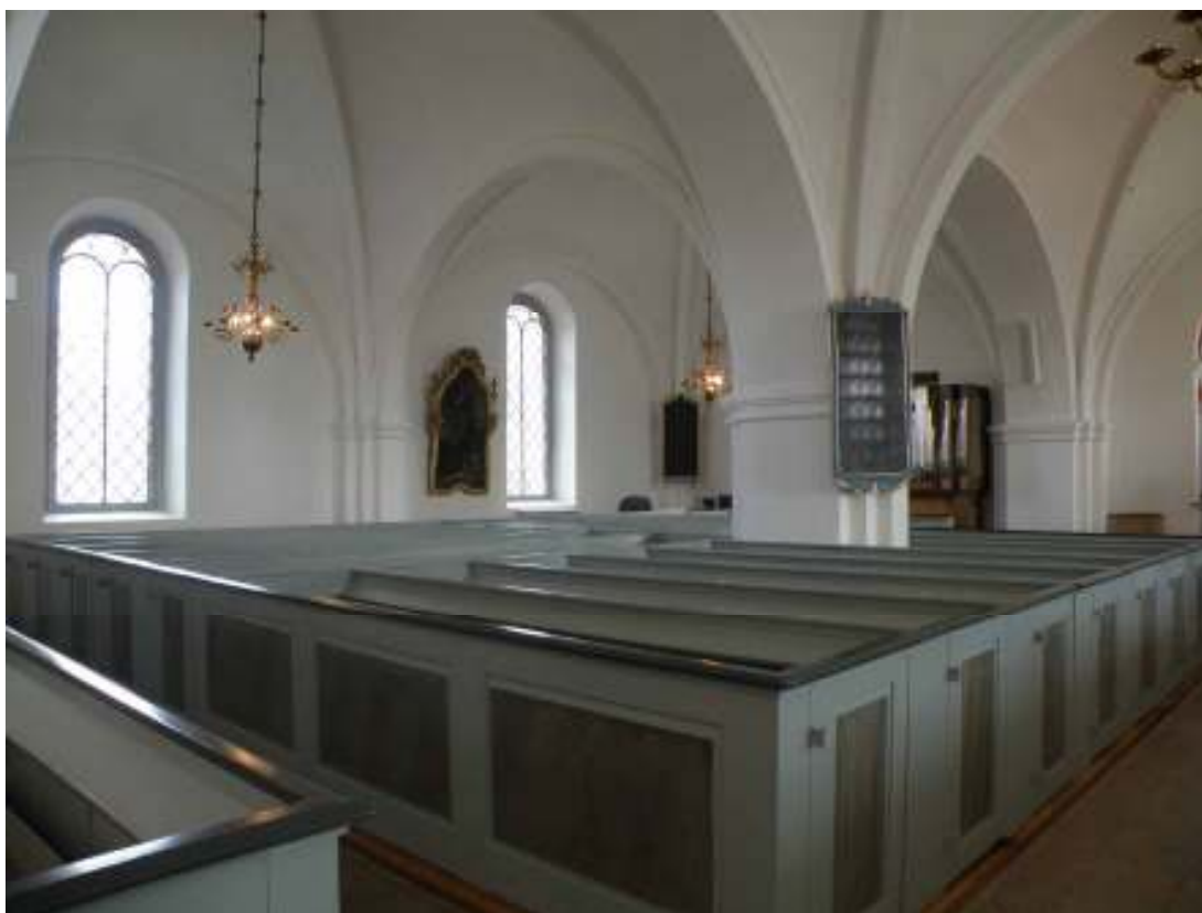
Långhuset och norra korsarmen vid slutbesiktning. Bänkarna har fått en mörkare färgskala helt och hållet från den äldre färgsättningen.
