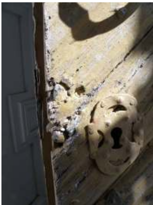
Snickerierna var i behov av ommålning. På södra korsarmsdörren fälldes nytt virke in. På södra korsarmsdörren fälldes nytt virke in i dörrbladets paneltäckning.
