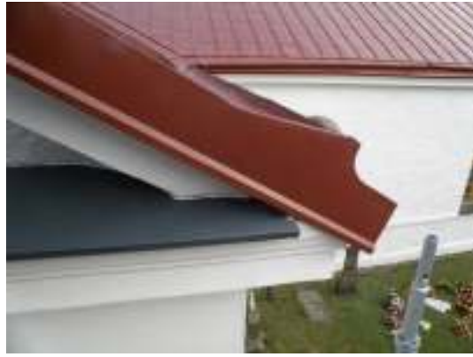
Plåt vid listavtäckningar byttes i fasaderna. Notera profileringen av fasadens övre listverk. Till höger färdig plåttäckning på södra korsarmen.
