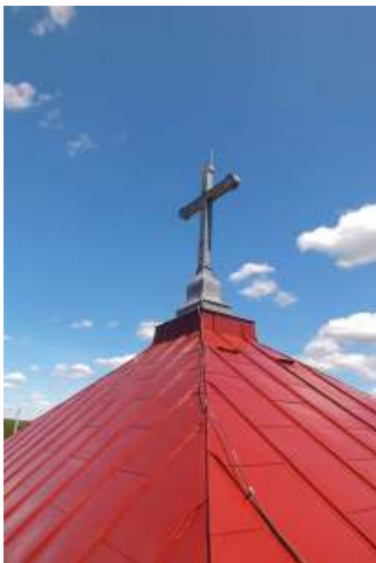
Torntaket efter ommålning. Tornets vattkypor byttes.
