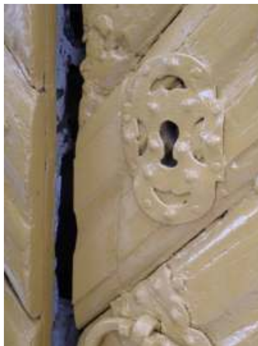
Snickerierna var i behov av ommålning. På södra korsarmsdörren fälldes nytt virke in. På södra korsarmsdörren fälldes nytt virke in i dörrbladets paneltäckning.
