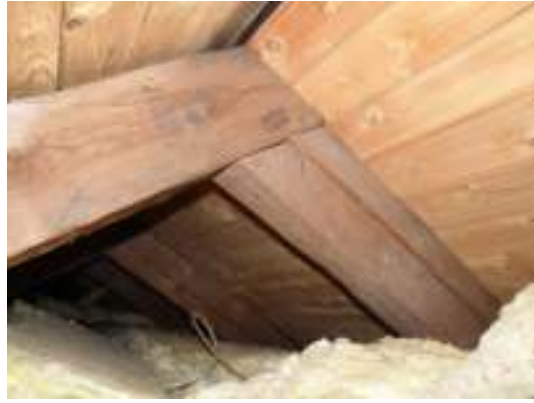
Återanvänt ekvirke i kyrkans taklag. Långhusets västra takstol. Till höger syns taklaget i nock på södra korsarmen från inspektionsluckan.
