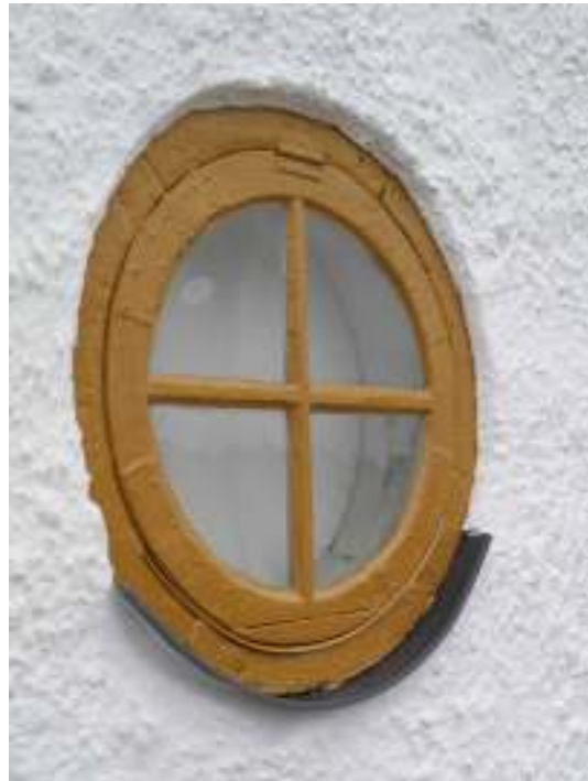
På rundfönstren till korsarmarna fanns fuktskador. Droppbleck och fönsterbleck monterades.
