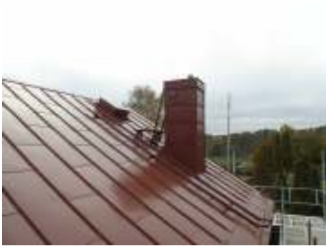
Till vänster, ny lucka i södra korsarmen och skorstenens plåtinklädnad. Till höger: Skräp från fåglar har samlats intill hjälpkupplagen i tornet. Skräpet behöver rensas bort för då detta kan leda till rötskador och biologisk påväxt.
