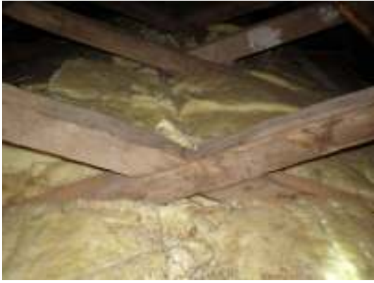
Återanvänt ekvirke i kyrkans taklag. Långhusets västra takstol. Till höger syns taklaget i nock på södra korsarmen från inspektionsluckan.
