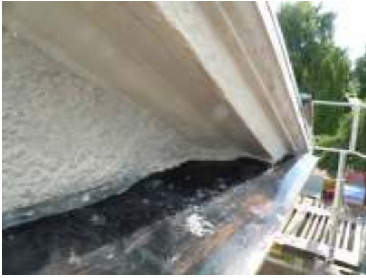
Plåt vid listavtäckningar byttes i fasaderna. Notera profileringen av fasadens övre listverk. Till höger färdig plåttäckning på södra korsarmen.
