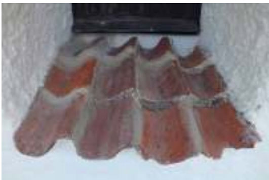
Taktegel i ljudluckornas fönsterbänkar foglagades. I ljudluckorna tjärades. Till höger syns tornets takfotsunderbrädning och listverk efter ommålning.
