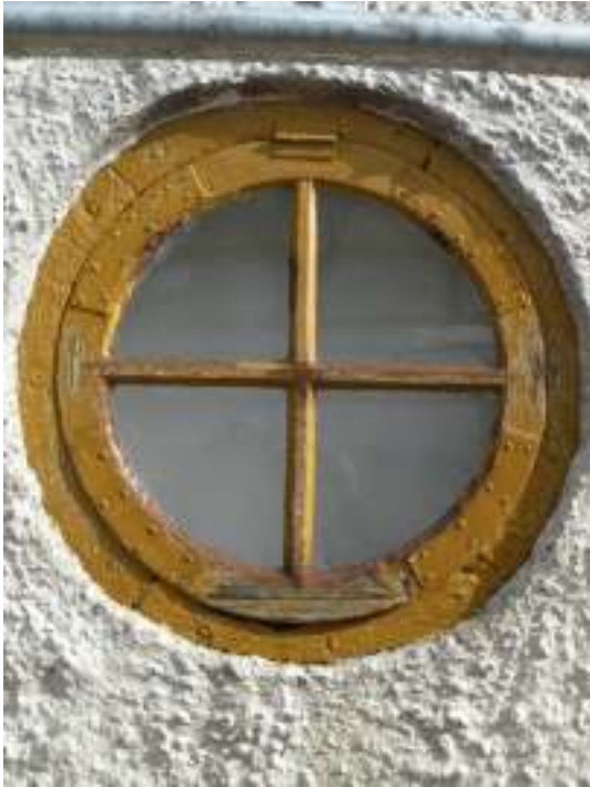
På rundfönstren till korsarmarna fanns fuktskador. Droppbleck och fönsterbleck monterades.
