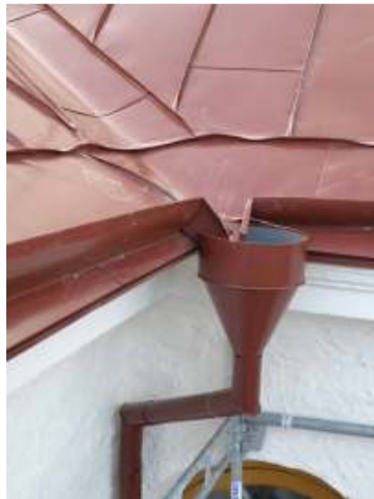
Fotrännan till det nya plåttaket utfördes enligt Kjell Larssons modell med hål i innerplåten för att kondensvatten inte ska bli stående inne i konstruktionen. Till höger syns färdigt resultat och takavvattnings nya vattkupor.
