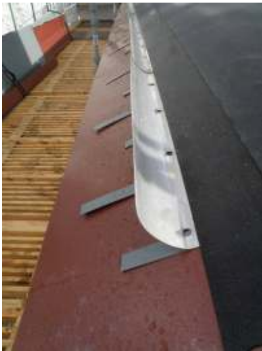
Fotrännan till det nya plåttaket utfördes enligt Kjell Larssons modell med hål i innerplåten för att kondensvatten inte ska bli stående inne i konstruktionen. Till höger syns färdigt resultat och takavvattnings nya vattkupor.
