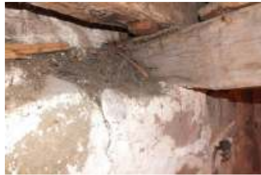
Till vänster, ny lucka i södra korsarmen och skorstenens plåtinklädnad. Till höger: Skräp från fåglar har samlats intill hjälpkupplagen i tornet. Skräpet behöver rensas bort för då detta kan leda till rötskador och biologisk påväxt.
