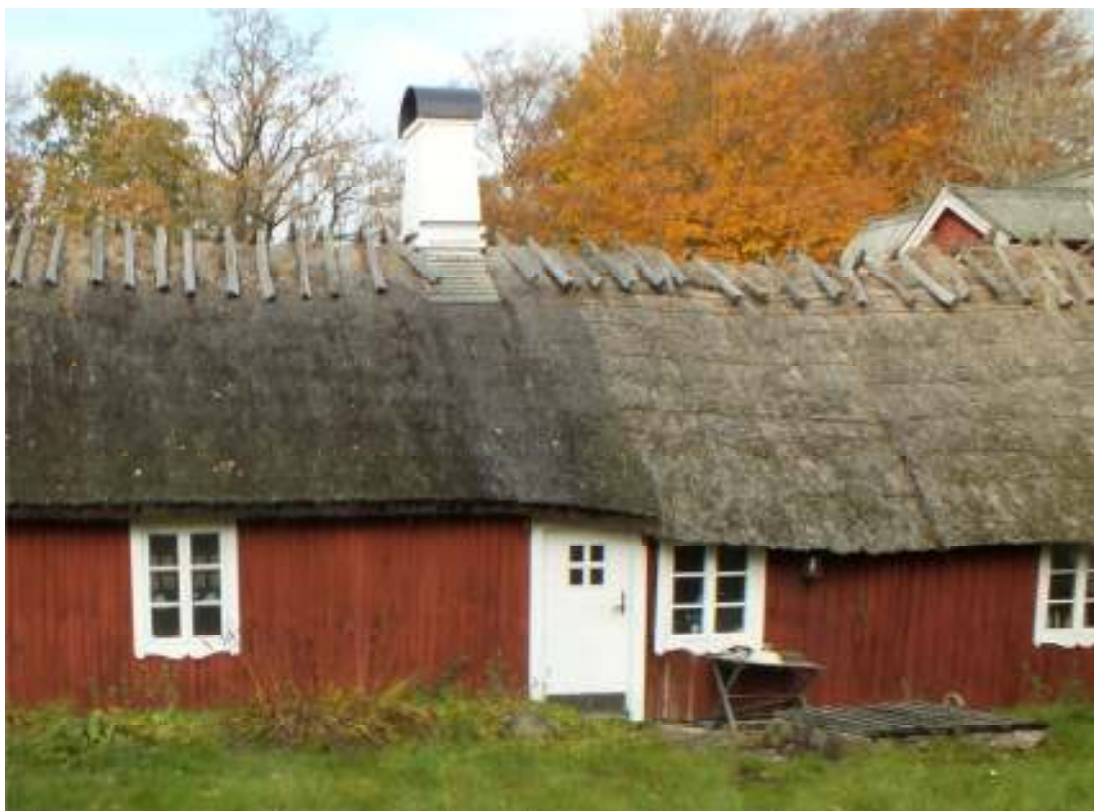
Fig. 4. Boningshuset. Förbrukade stin på södra takfallets östra del.
