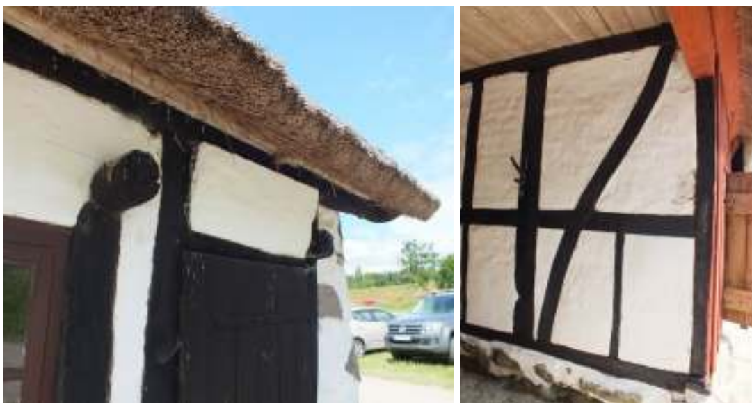
På bilden till vänster ses facket som åtgärdats på den östra längan, notera att det lutar kraftigt utåt. Till höger visas exempel på mindre putslagningar som har utförts, i detta fall i portgången på norra längan.
