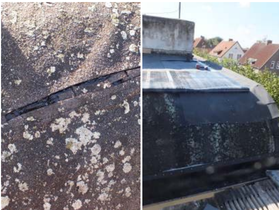
T.v. ses den senaste papptäckningen med uppskuret hål för undersökning av underliggande papp. Den västra sidan (t.h.) lagades med ny panel och underlagspapp innan den nya pappen lades.
