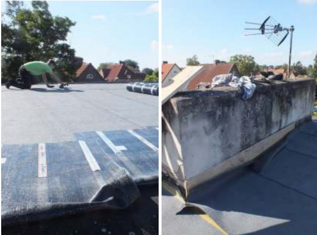
Täckning med ny papp skärs ut och läggs på plats. Kring skorstenen sattes en ny skiva i plywood upp som plåten fästes i.
