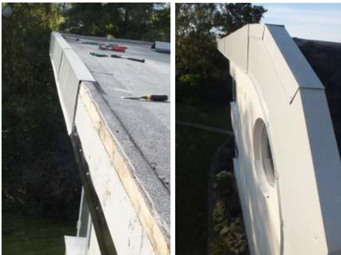
Plåtningen av hängskivorna utfördes med slussfals där infästningen är dold. Till höger ses takets rundning där man var tvungen att utföra plåtningen i flera delar med synlig infästning.
