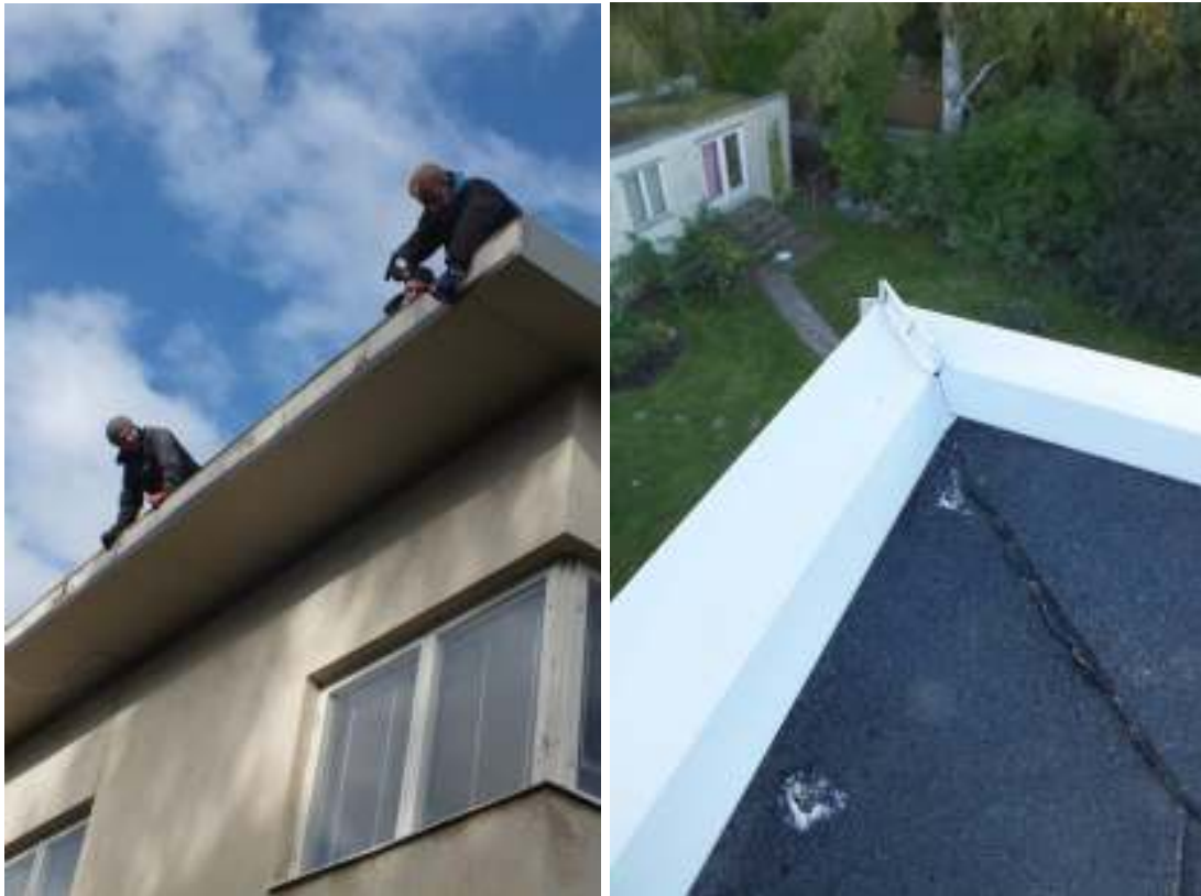
Fästplåtar sätts upp på den södra sidan av taket på den gamla plåtens ovan- och nederkant. Till höger ses det sydöstra hörnet efter att den nya plåten satts på plats.
