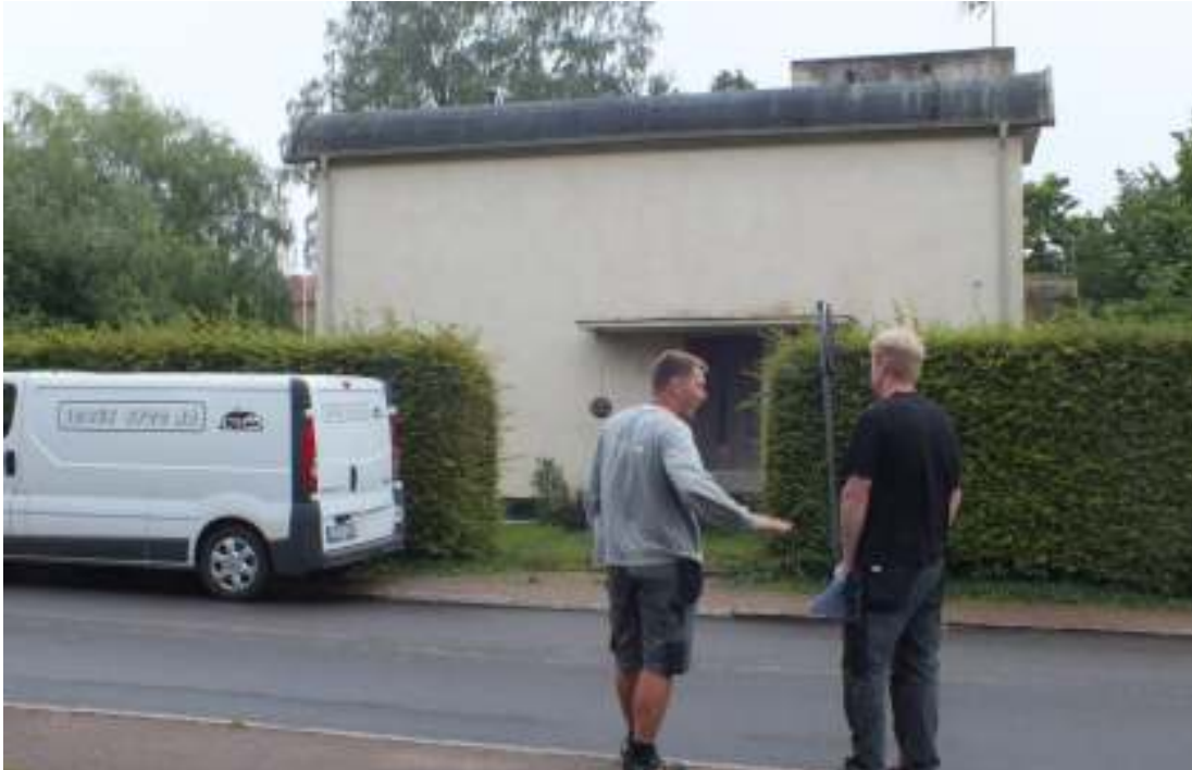
Villa Petterssons tak sett från norr, före takomläggningen, augusti 2013.
