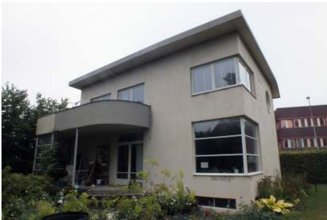
Villa Pettersson sedd från trädgårdssidan i söder. Bilden är tagen före takomläggningen, augusti 2013.
