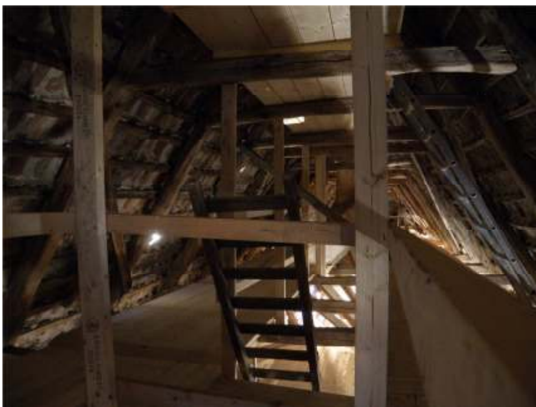
Södra slottslängans spångkonstruktion.
