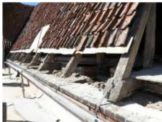
Takpannorna vid norra takfoten borttagna.
