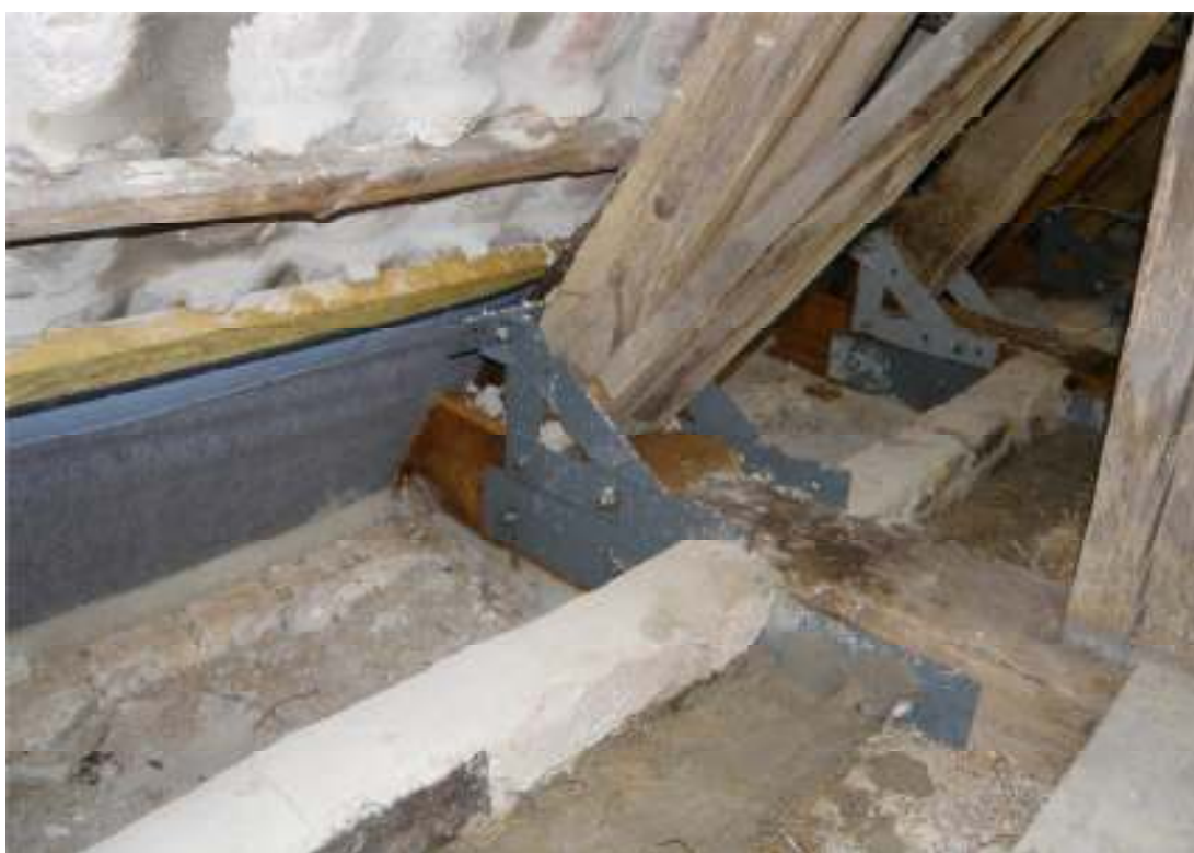
Säkring av sparre/ bindbjälke samt säkring av skarv. Södra takfoten.
