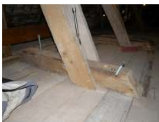
Detalj av snedstyvornas fästning mot golv.
