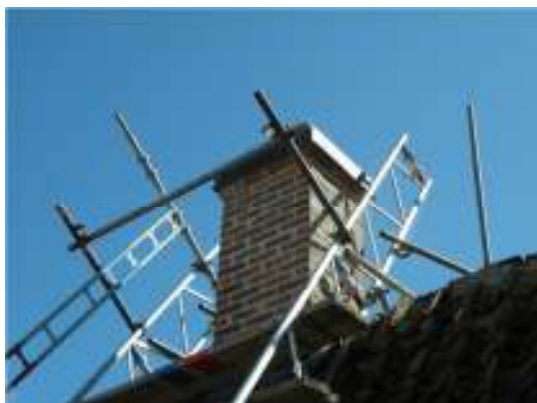
Exempel på omfogning av skorstenarna.
