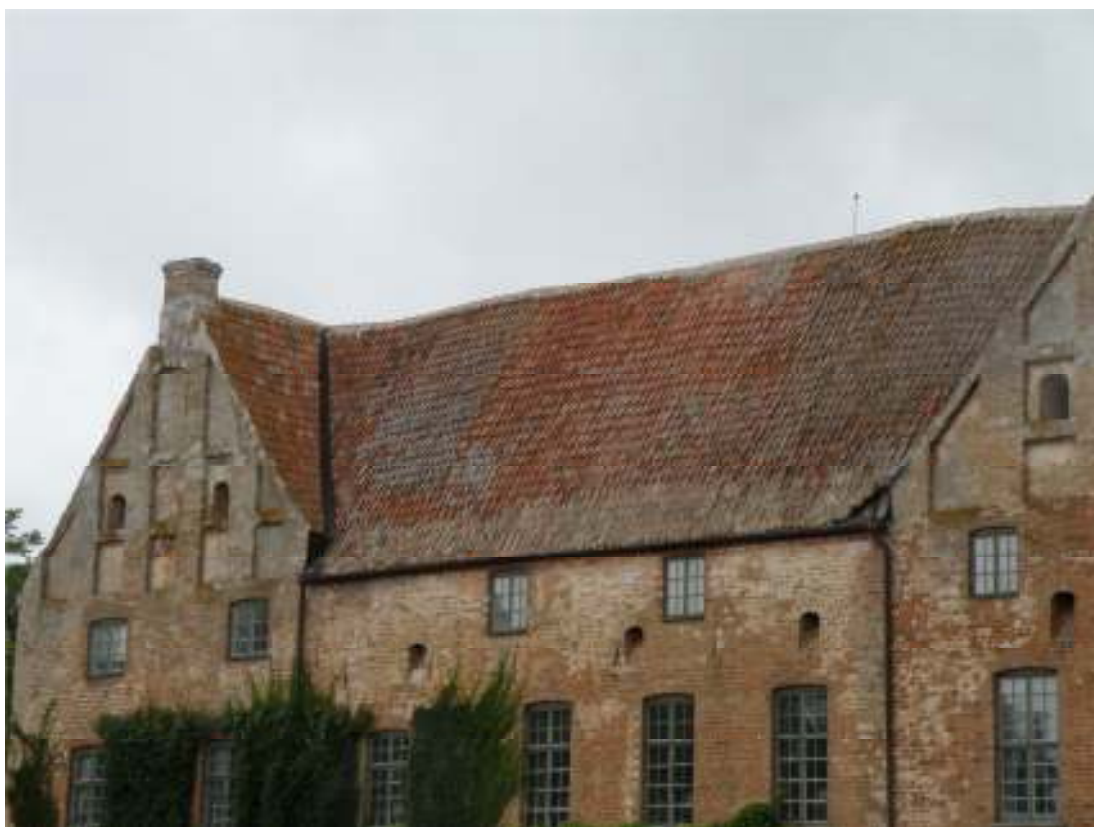
Södra takfallet efter arbetet.
