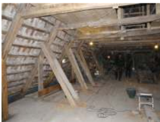
Snedstyvorna på södra sidan.
