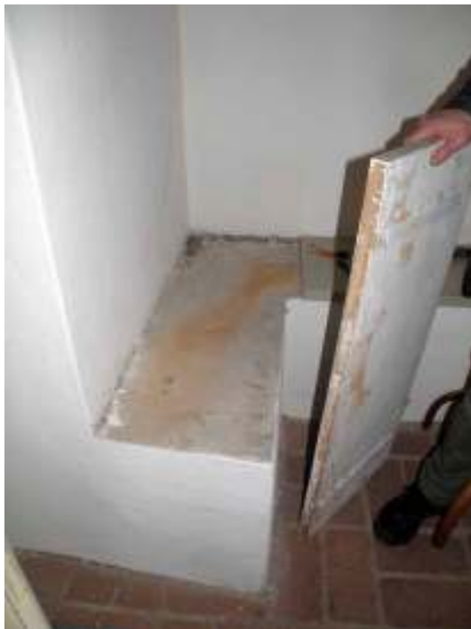
Matarledningar till värmen låg inmurade i vapenbusets murade bänkar. Ledningarna i denna del byttes inte ut då de var i tillförlitligt skick. Matarledning i bänkkvarteren drogs i befintlig kabelränna. Härifrån drogs ledningarna vidare till korarmarna och därifrån till kor och absid.
