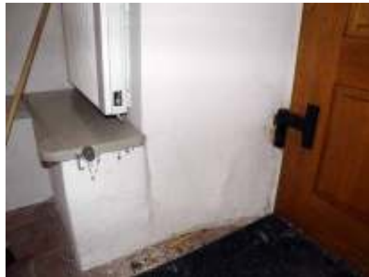
Bänkvärmare från 1950-talet var monterade under bänkarna. Till höger syns radiator i vapenuset. Ledningsdragningen går inne i väggen troligtvis i dörrsmynan och upp till tornets andra våning. Fotografier tagna före renoveringen.
