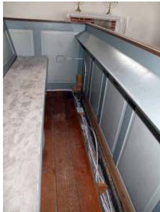
Matarledningar till värmen låg inmurade i vapenbusets murade bänkar. Ledningarna i denna del byttes inte ut då de var i tillförlitligt skick. Matarledning i bänkkvarteren drogs i befintlig kabelränna. Härifrån drogs ledningarna vidare till korarmarna och därifrån till kor och absid.
