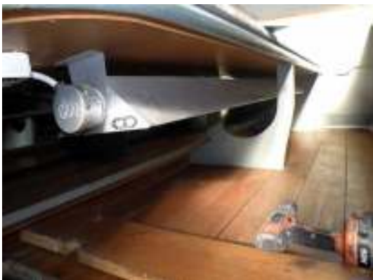
Bänkvärmare från 1950-talet var monterade under bänkarna. Till höger syns radiator i vapenuset. Ledningsdragningen går inne i väggen troligtvis i dörrsmynan och upp till tornets andra våning. Fotografier tagna före renoveringen.
