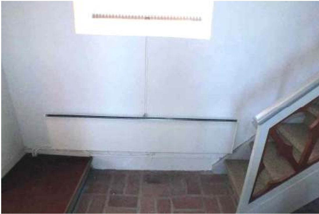
Ny radiator vid korets södra sida. Väggen har putslagats och målats in.
