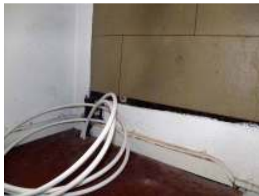
Ledning matades i rör under tegelgolvet fram till korsarmens nordöstra hörn (t.v.) och vid korets sydöstra hörn (t.h.)
