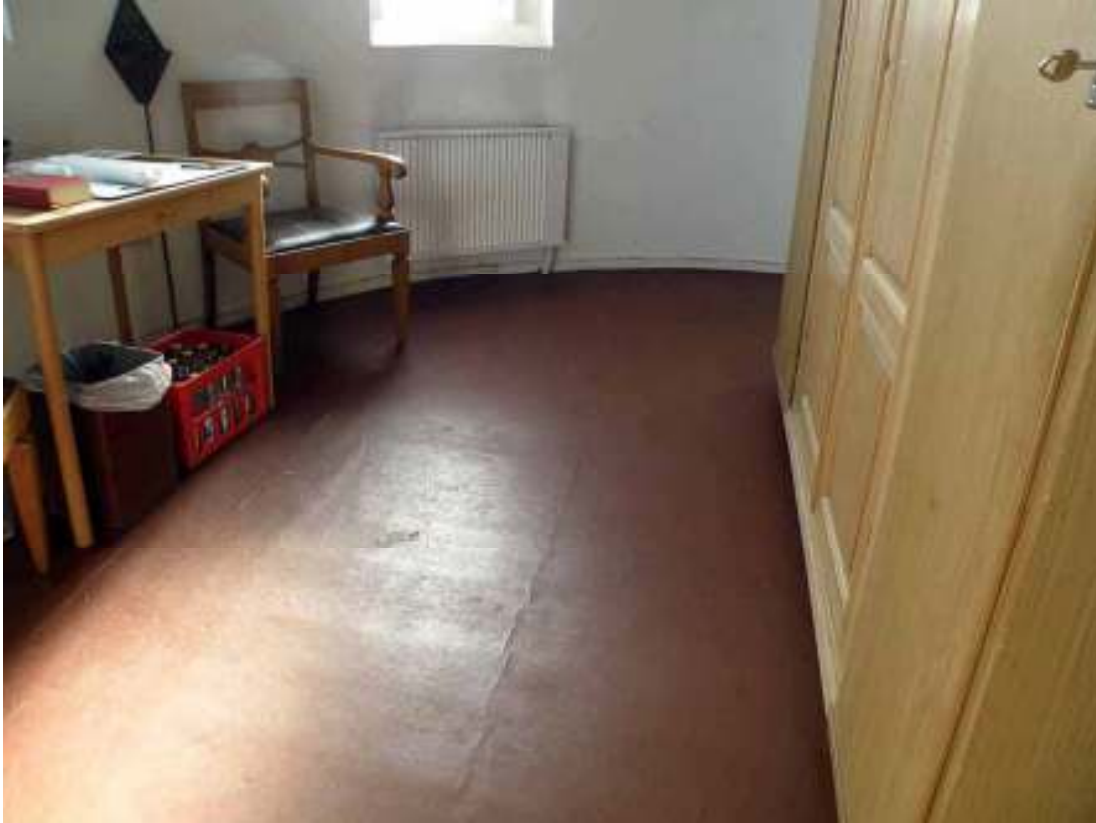
I absiden, sakristian, ligger en äldre linoleummatta på ett brädgolv. I fonden syns den befintliga radiatorn före utförd renovering
