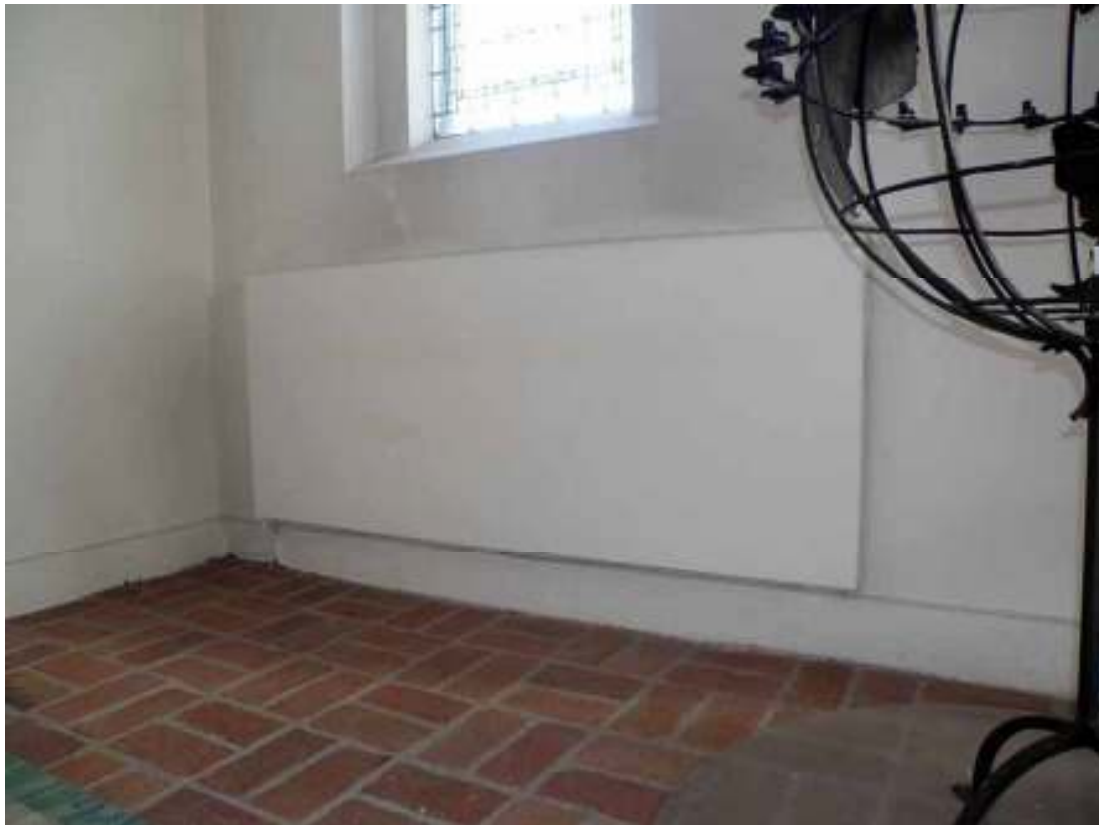
Befintlig vägghängd radiator i norra korsarmen, före renoveringen. De vägghängda radiatorerna var monterade på skivor av eternit.
