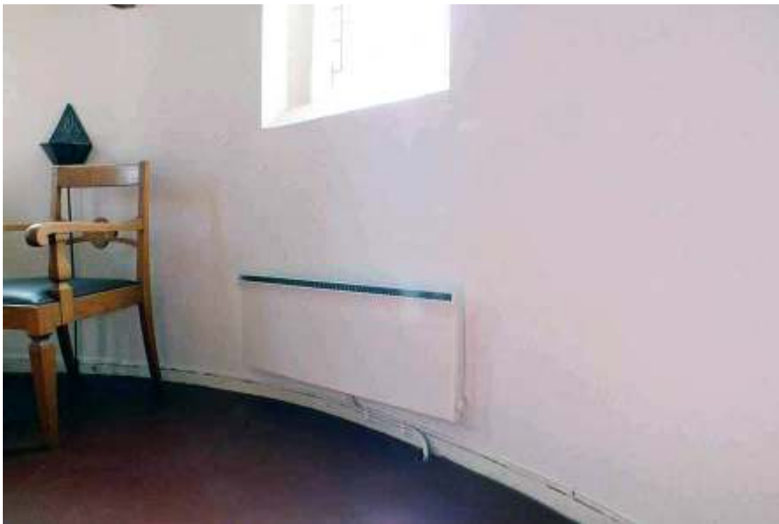
Ny radiator i sakristian. Bakom radiatorerna i sakristian finns kvadermålningen bevarad.
