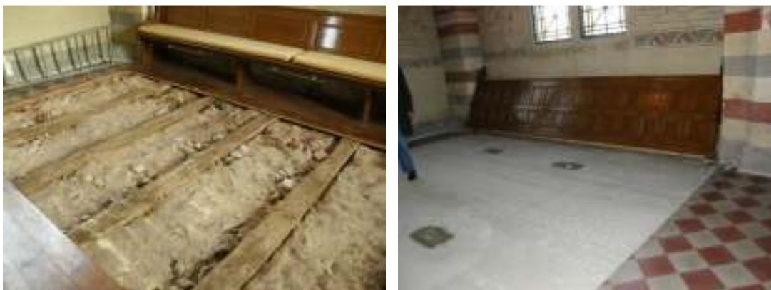
Furugolvet revs tillsammans med bjälkar och trossbottenfyllning. Bilden till höger visar det nygjutna betonggolvet.
