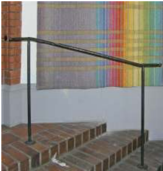
Trappräckena längs väggen på båda sidor om trappan togs bort i samband med att ramperna byggdes upp. Nya trappräcken efter de gamla som förebild monterades mellan trappan och ramperna. Juni 2011.
