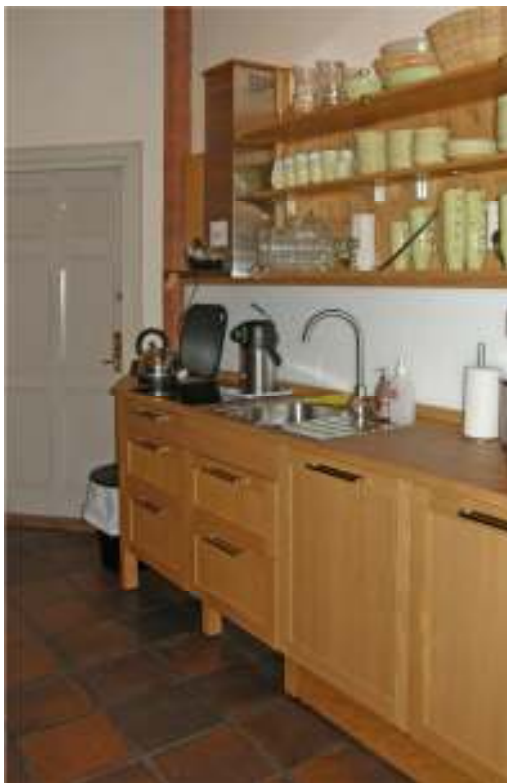
Det södra rummet är inrett med ett pentry. Skåpen har placerats ovanpå det befintliga golvet. Hyllorna är fastskruvade i en träpanel som sattes upp vid 1992 års renovering. Hålltagning i väggen har gjorts i samband med indragning av vatten och ventilation.
