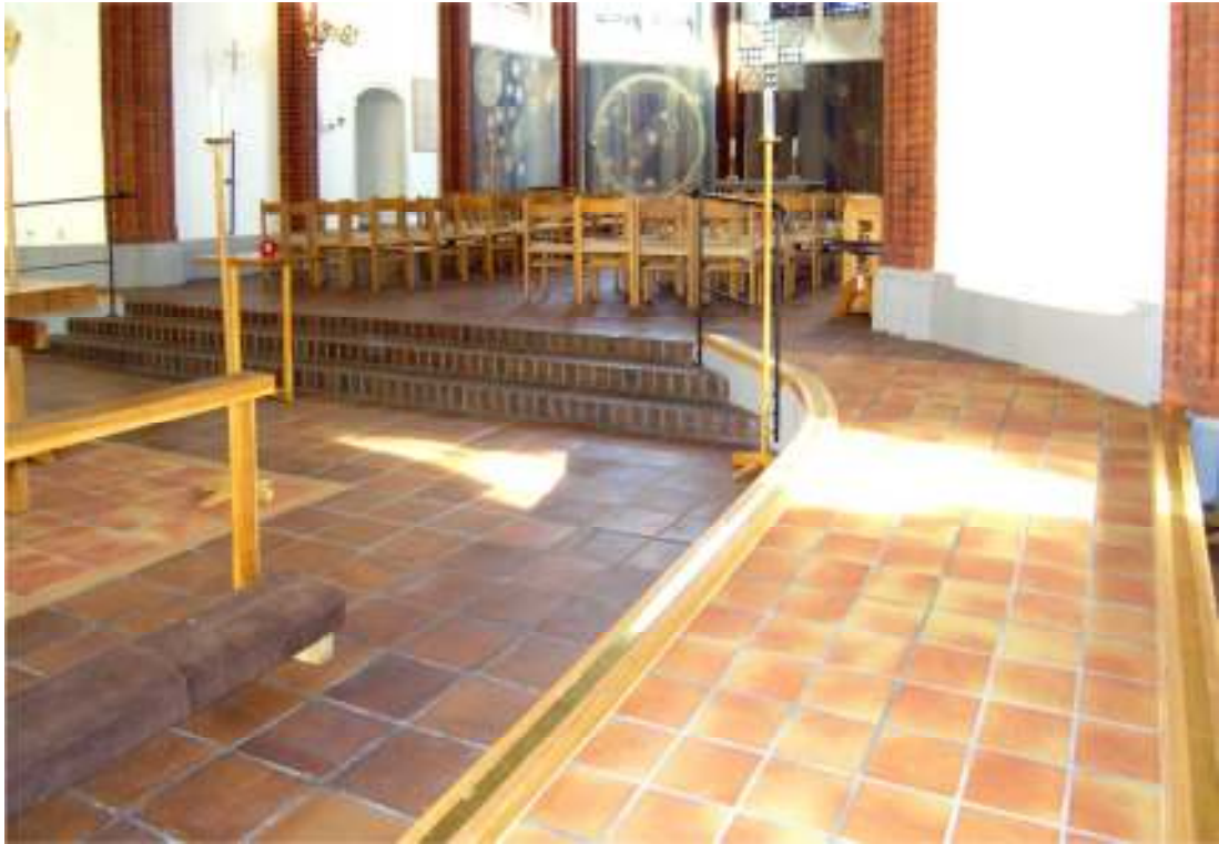
Rampen på södra sidan. Plattorna skiljer sig i både storlek och färg. Plattorna kommer att pigmenteras för att mer likna de gamla plattorna. Januari 2012.
