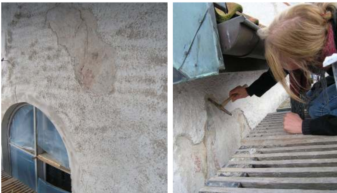
På södra långhusfasaden, snett ovanför det östligaste fönstret, återfanns målerirester av vad som förefaller vara en fönsteromfattning. Fyndet finns inmätt och dokumenterat i konservatorsrapporten. Bilden till höger visar konservator Ingrid Wedberg som undersöker om det finns en bemälad takfris. Någon sådan återfanns inte på koret.
