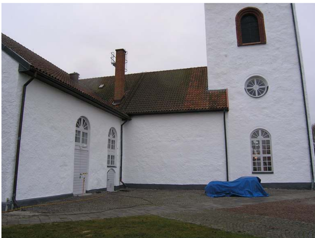
Stoby kyrka, del av norra korsarmen samt nordvästra fasaden, 2012 efter avslutad fasadrenovering. Jämför med bilden ovan och observera särskilt ändrat utseende på dörrarna i norra korsarmen.
