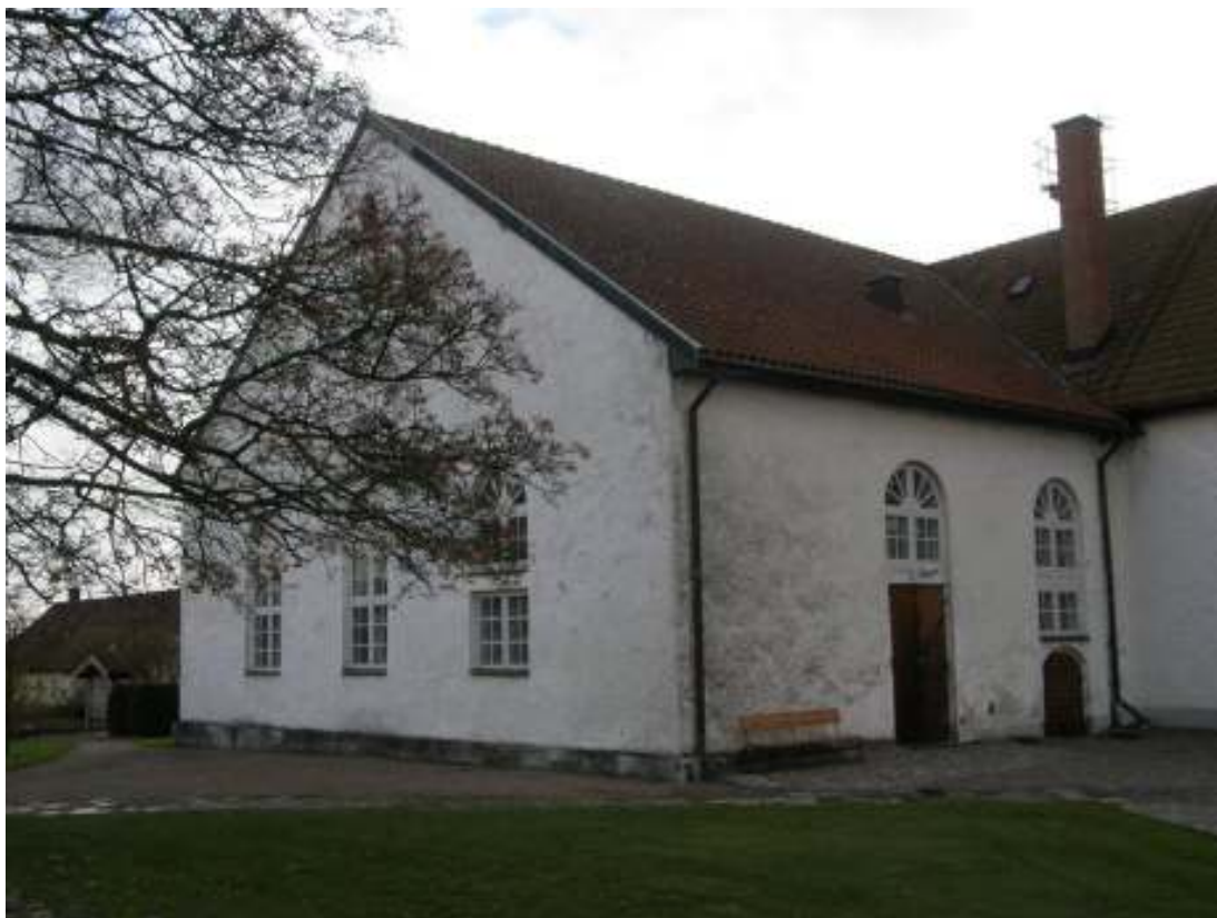
Stoby kyrka, norra korsarmen 2010 före fasadrenovering.
