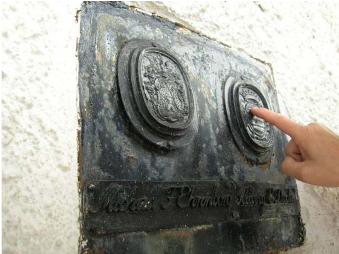
Minnesplattan över Michael F Ehrenborg och Hedvig E Dücker är i behov av konserveringsåtgärd.
