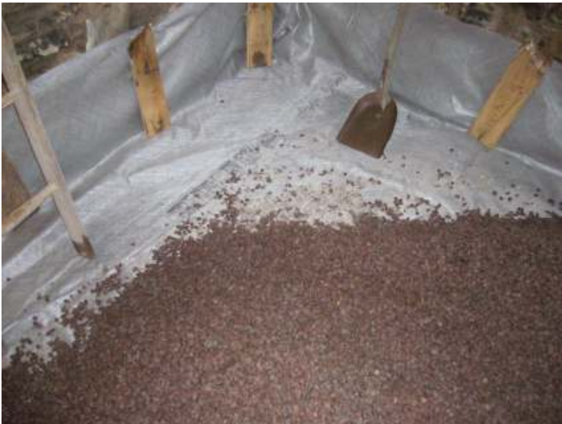
Fig. 15. Västra källaren, makadam läggs på fiberduken.
