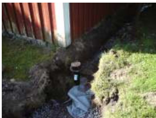
Fig. 3. Ny rensbrunn av gjutjärn.
