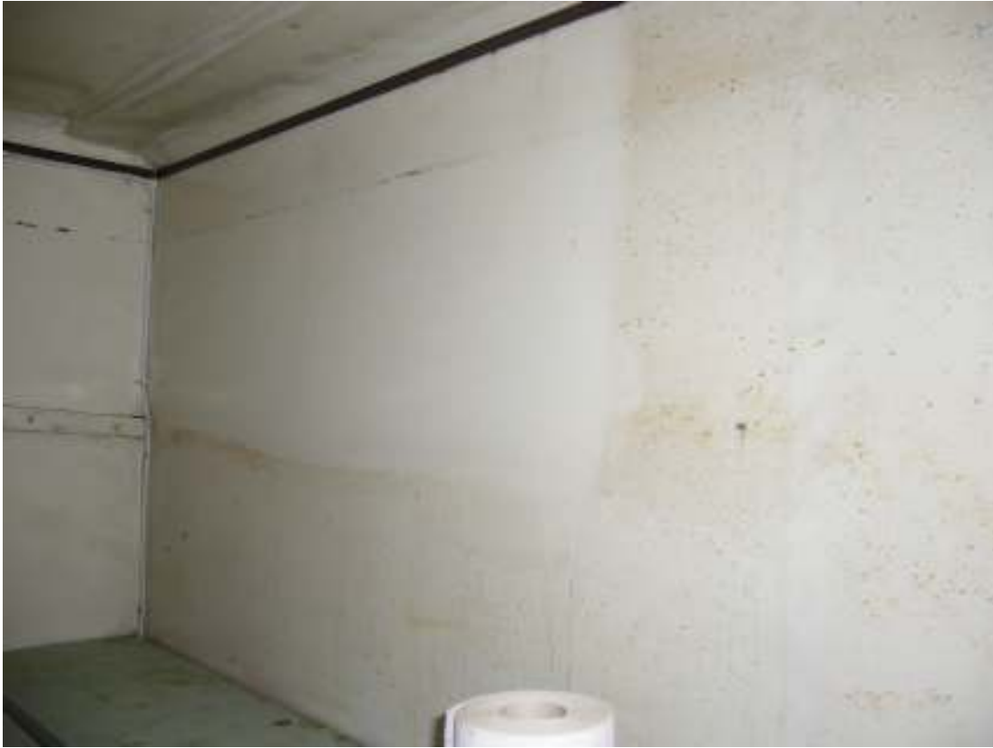
Fig. 22. Rengörning av kökets väggar och tak (under arbetet).
