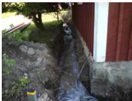
Fig. 4. Dräneringsschakt, västra fasaden.
