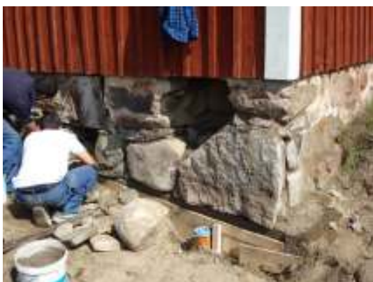
Fig. 12. Grundstenarna återsätts.
