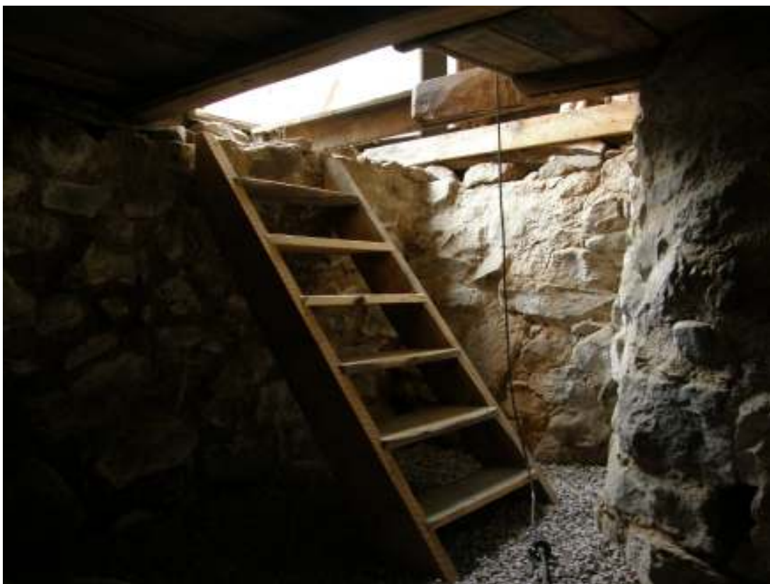
Fig. 9. Den restaurerade källartrappan vid farstunedgången.
