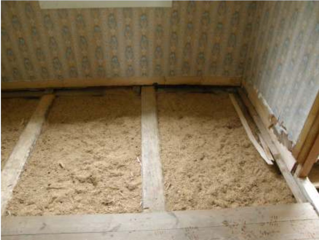
Fig. 18. Ny trossbottenfyllning i nordvästra rummet.
