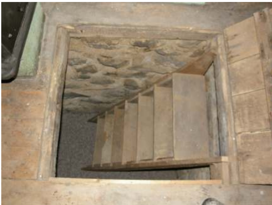
Fig. 20. Kökets källartrappa restaurerad.
