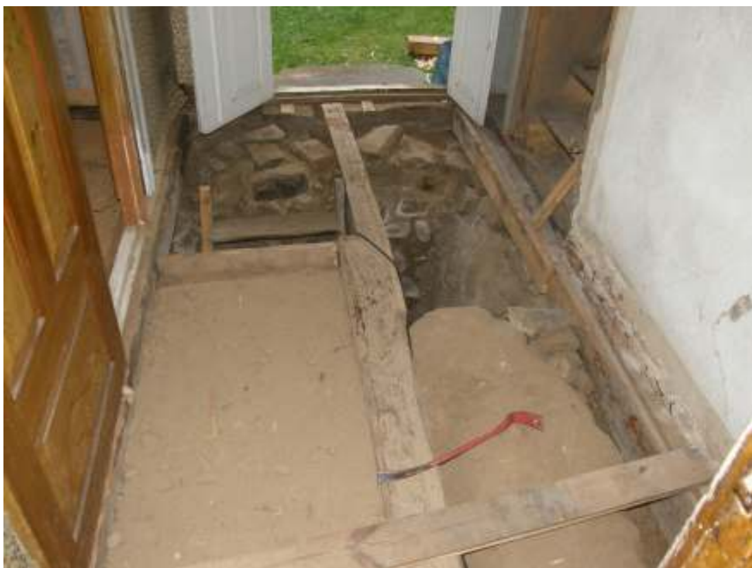
Fig. 16. Farstun, under arbetet.
