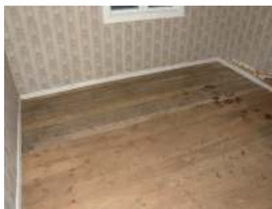
Fig. 6. Golvet återlagt i nordvästra rummet.
