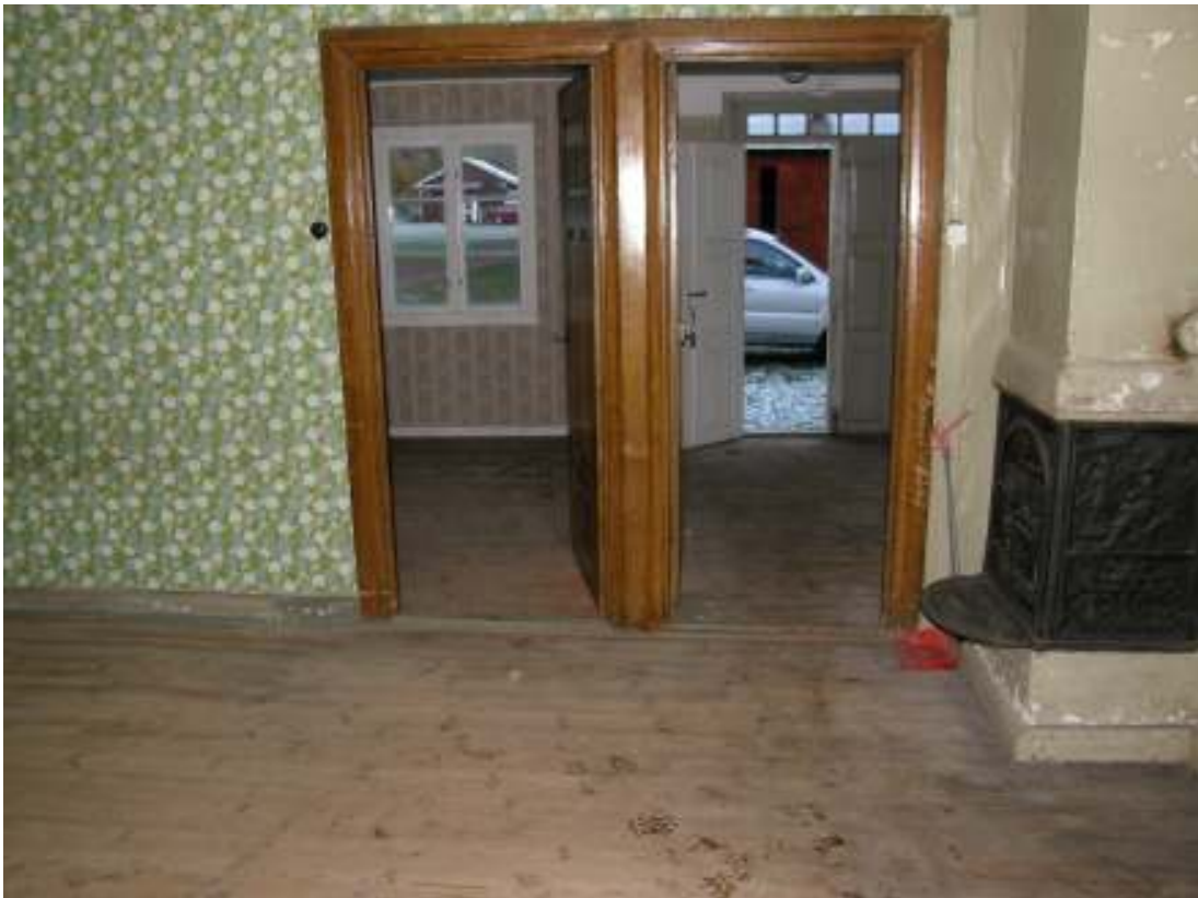
Fig. 19. Efter arbetet, vy mot norr.
