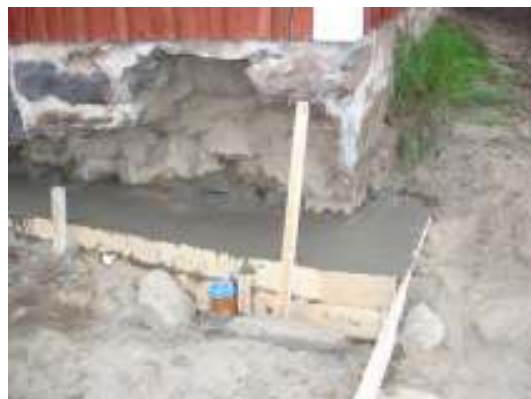
Fig. 11. Nygjutet underlag.
