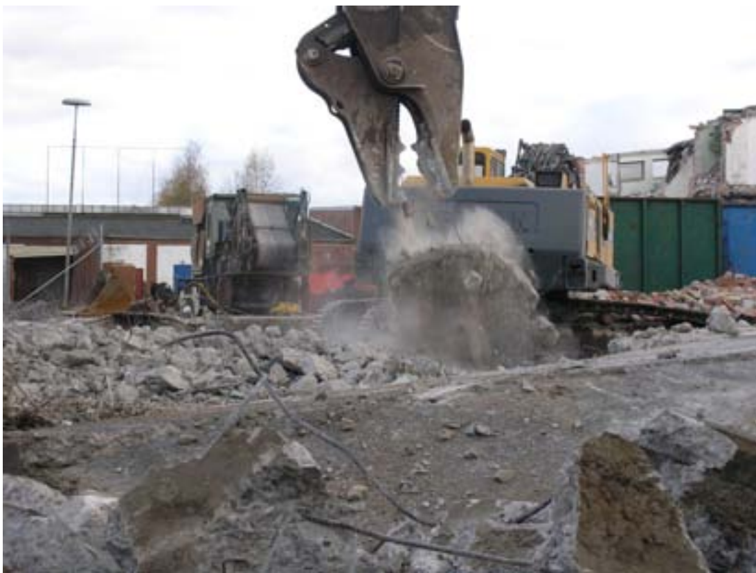
Rivningen av Scans anläggning är ett skådespel. Flera nyfikna stannar till utanför staketet för att följa hur de armerade betongkonstruktionerna får ge vika för rivningsmaskinernas framfart.
