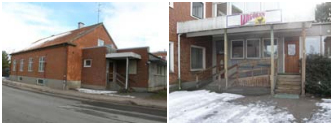
För att binda samman kontorsbyggnaden med produktionsanläggning uppfördes en låg byggnad, i vilken senare bostadshotellet Lergöken hade sin reception.
