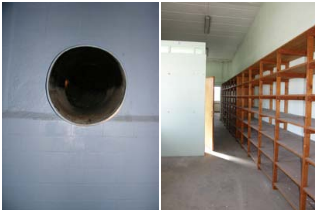
Till vänster syns mynningen till det rör genom vilket budarna transporterades från slakten till budarbetarna i källaren. Till höger syns en av de många hyllor som fortfarande finns i anläggningen. Förmodligen förvarades rena arbetskläder på hyllplanen.
