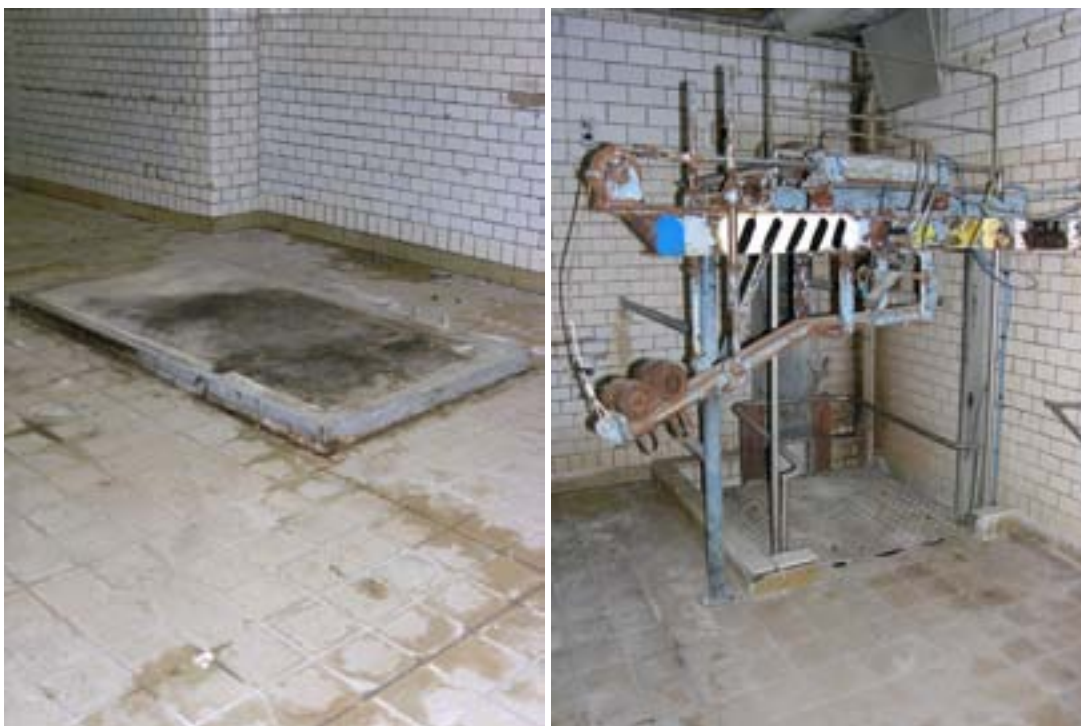
Till vänster syns fundamentet till den så kallade blandaren i vilken korvsmeten blandades. Till höger står del av ett tidigare transportband, vilket fraktade den färdiga korvsmeten vidare till korvstopparnas avdelning en trappa ner.
