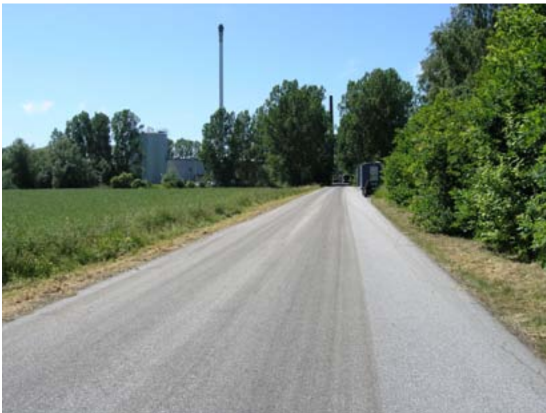
Konvex anläggning i Krummöllan är ofta omdebatterad, då grannar menar att de störs av dålig lukt. Ledningen arbetar med att försöka minska problemet. Tillståndet att bedriva köttmjölsproduktion är tidsbegränsat.
