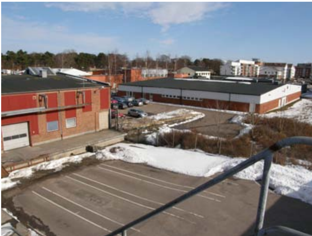
Vy från taket åt sydost, där industrifastigheterna ännu präglar den omgivande bebyggelsen.
