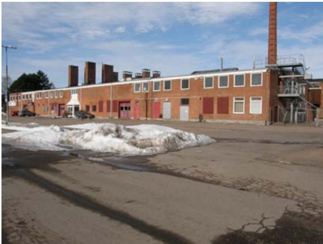
Sett från Industrigatan och centrum karaktäriseras mötet med Scans anläggning framförallt av den röda tegelmuren och de många skorstenarna (både den klassiskt runda och höga fabrikskorstenen och de många mindre, rektangulära som har samlats i grupp).
