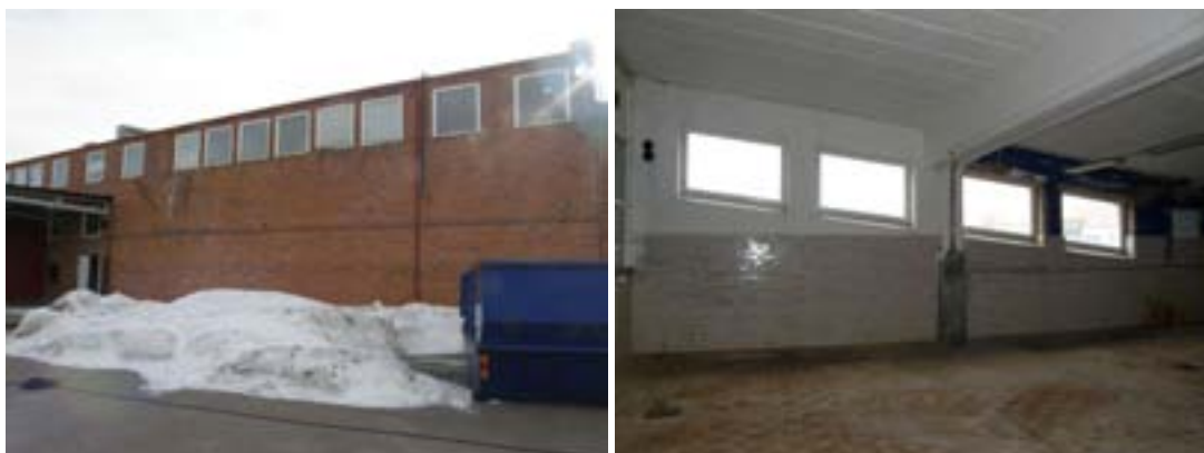
Anläggningen som till övervägande del fick sin form mellan åren 1949-1951 präglades av funktion men här finns även flera inslag av arkitektonisk omsorg, såsom det snedställda fönsterbandet i tarmrenseriet på ovanvåningen.
