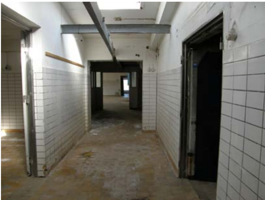
Rum i fil för köttproduktion. Ovanljuset i korridoren kompenserar bristen på vanliga fönster långt inne i den djupa industrianläggningen.
