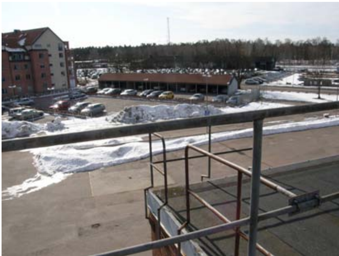
Vy från taket åt sydväst, där sentida bostadsbebyggelse kommer allt närmare Scans anläggning.
