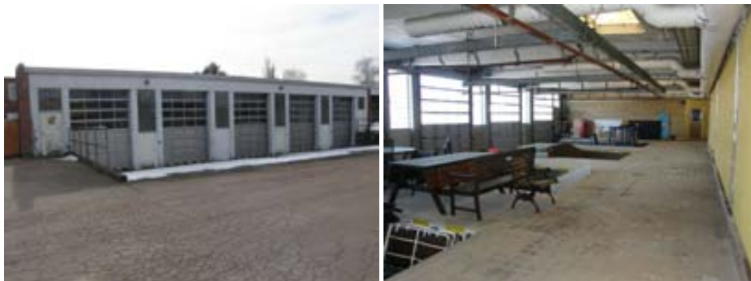
Utlastningen skedde ursprungligen under bar himmel men byggdes senare in för att underlätta hanteringen. Vid Regionmuseets dokumentation användes lokalen som förråd.
