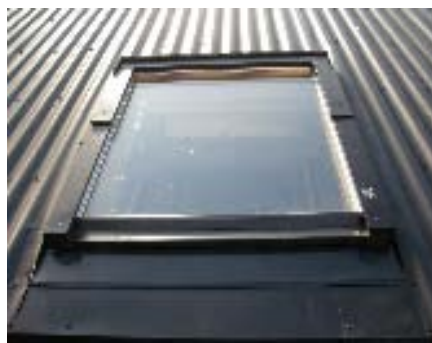
Fotot till vänster visar det gamla mindre takfönster över bostaden när taket är isolerat och påbyggt. Bilden till höger visar det "nygamla" takfönstret på plats med "nygammal" plåt.
