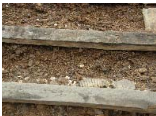
Närbild på torvisolering och läkt
