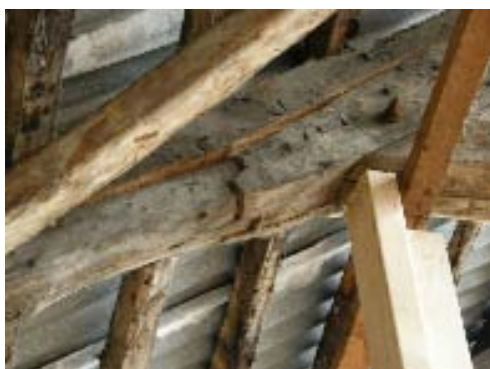
Sprucken och delvis knäckt sparre, och sprucket hanband.
