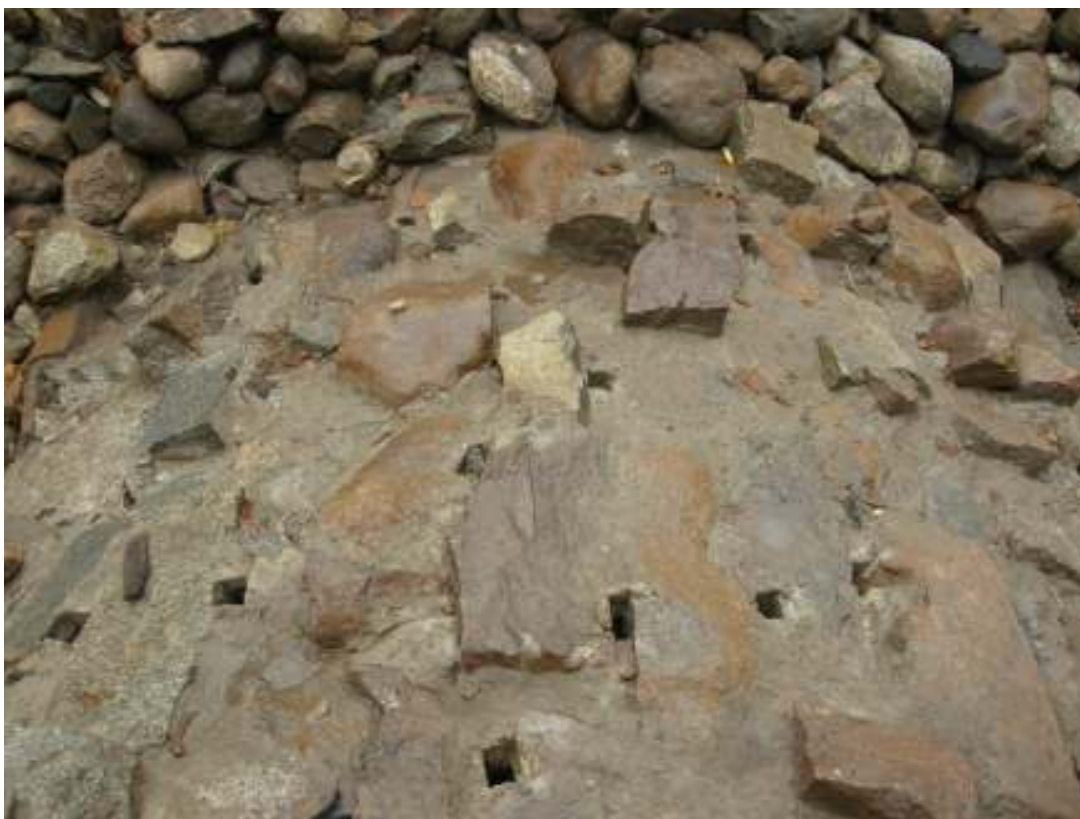
Sentida omfogning ovan valvet. I hålen har tidigare suttit ekkilar.
