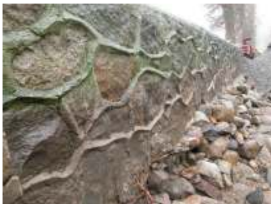
Exempel på fogning, innan arbetet.
