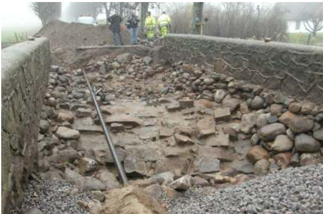
Fyllnadsmassan ovan valvet urgrävd, vy mot öster.
