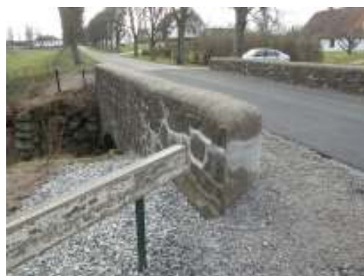
Norra barriären efter arbetet.
