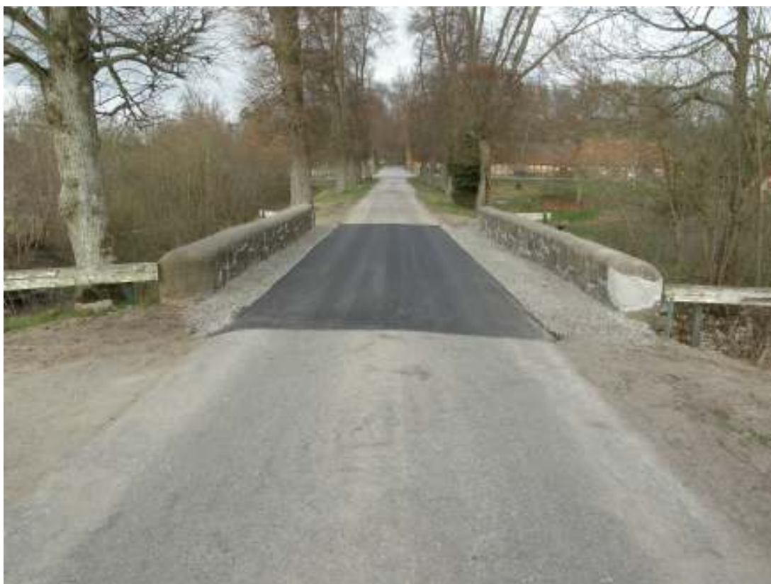
Ny farbana efter arbetet, vy mot väster.
