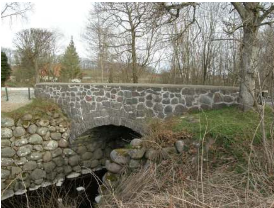
Norra brosidan efter arbetet.
