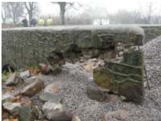
Norra barriären under arbetet.
