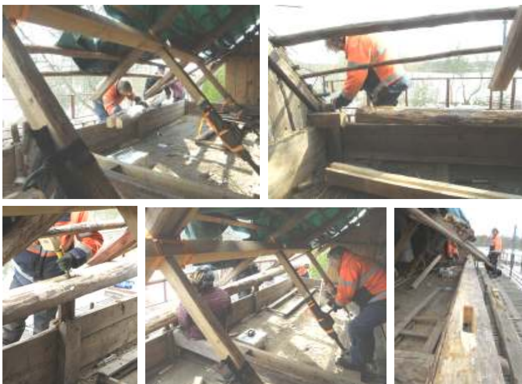
Bildsviten visar arbetet med att lyfta den nya lejden på plats och de mindre justeringar som fick göras innan den passats in.
