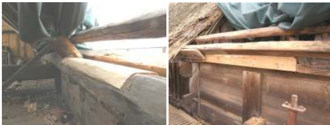
Bilderna visar lagningen som gjordes på bryggbusets lejd i väster. På den högra bilden syns plankan som ersatt rötskadade partier utmed lejdens utsida.
