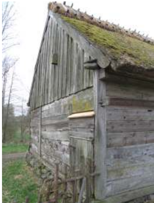
Den vänstra bilden visar brygghusets södra gavel där de ljusare träpartierna visar lagningarna som gjorts i sparren, vindskeivan och solbrädan, lejdens ändträ skymtar också fram. På den högra bilden syns ny vattlist över södra längans östra port.
