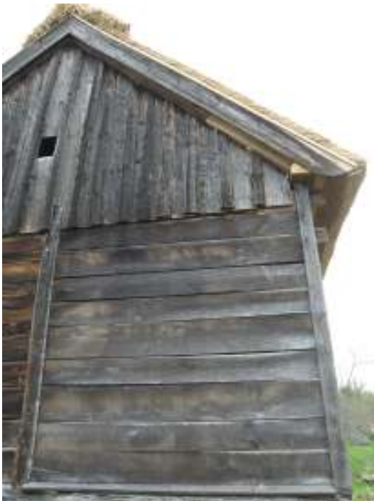
Den vänstra bilden visar brygghusets södra gavel där de ljusare träpartierna visar lagningarna som gjorts i sparren, vindskeivan och solbrädan, lejdens ändträ skymtar också fram. På den högra bilden syns ny vattlist över södra längans östra port.
