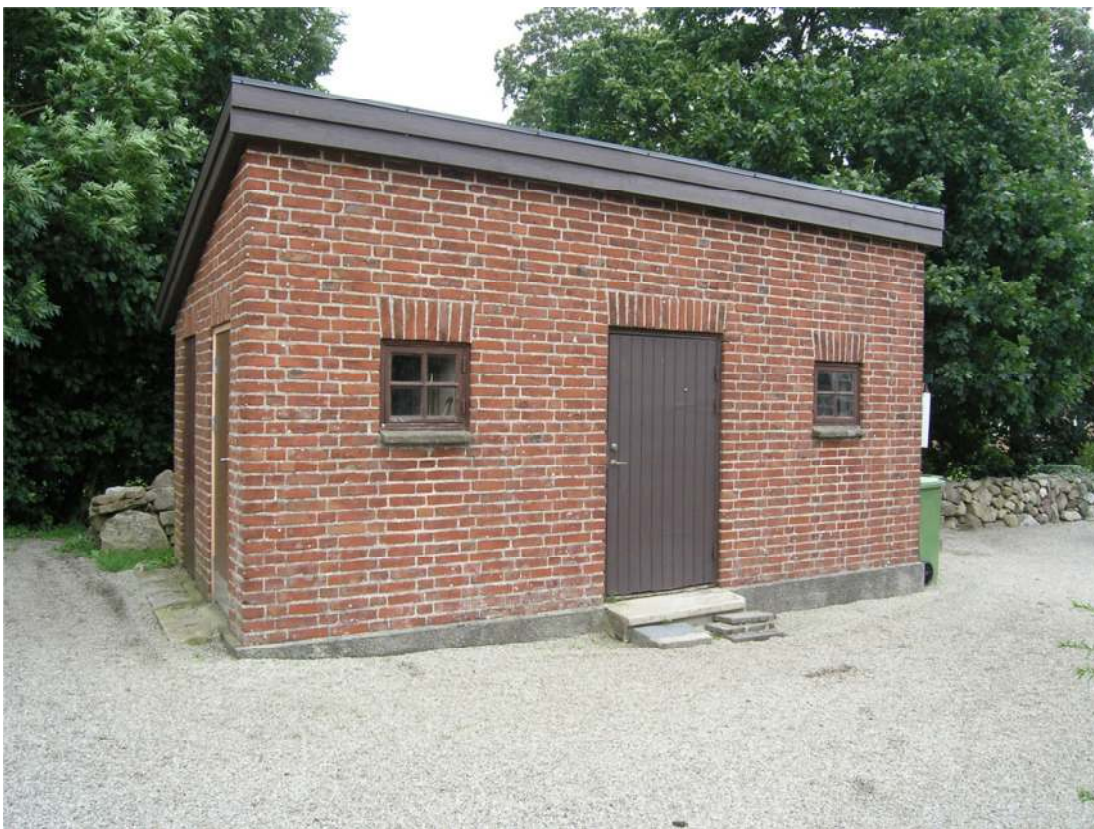
Förrådsbyggnaden i kyrkogårdens nordvästra hörn. En enkel och diskret byggnad uppförd i gedigna material.
